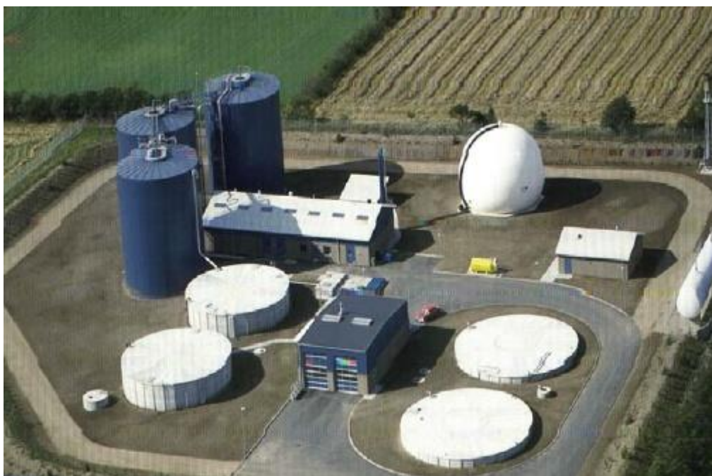
Εικόνα 14: Μονάδα παραγωγής βιοαερίου[13]
