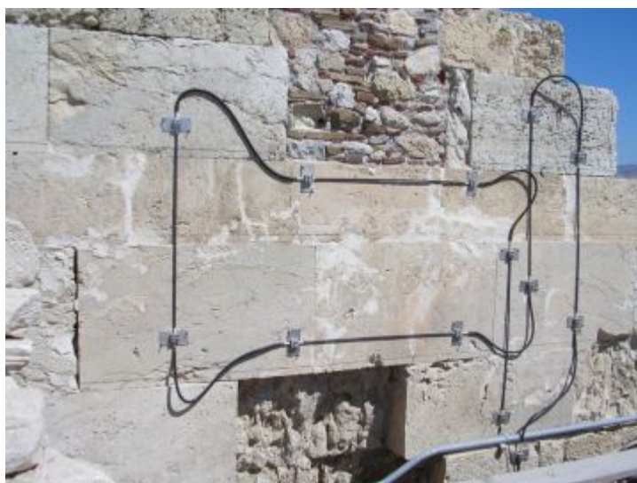
Σχήμα.6 οπτικές ίνες, χρησιμοποιούμενες από την υπηρεσία συντήρησης μνημείων.
