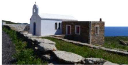
οικογενειακή εκκλησία της αγίας αικατερίνης + βοηθητικό κτίσμα
