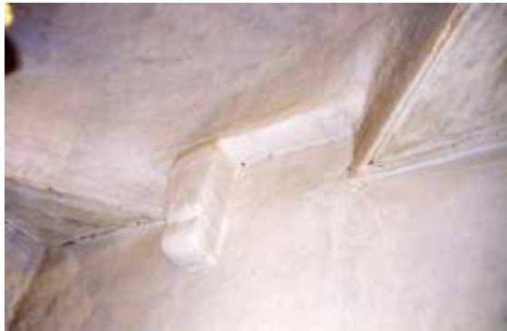
Εικ. 101-102. Καθολικό, παρεκκλήσιο Αγίων Πατέρων. Λεπτομέρειες της έδρασης του θόλου στο δυτικό τοίχο και των παραθύρων στα βορειοανατολικά.
