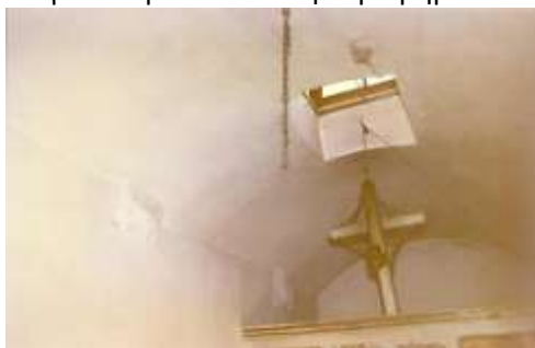
Εικ.148-149. Ο βόρειος τοίχος του παρεκκλησίου διασώζει δύο λίθινους προβόλους στη γένεση του θόλου
