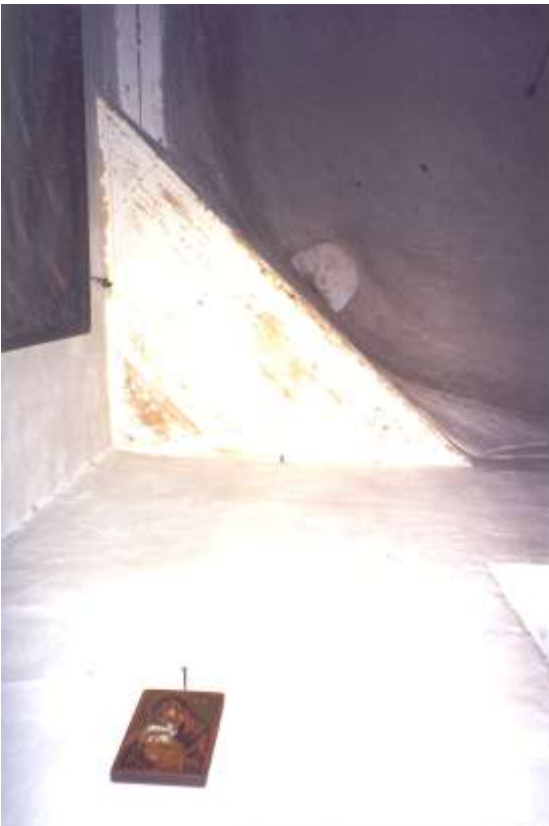
Εικ.74-75. Καθολικό, παρεκκλήσιο Αγίου Ιακώβου Αδελφοθέου. Η έδραση του θόλου στη βορειοδυτική γωνία και νοτιοανατολική γωνία του παρεκκλησίου.
