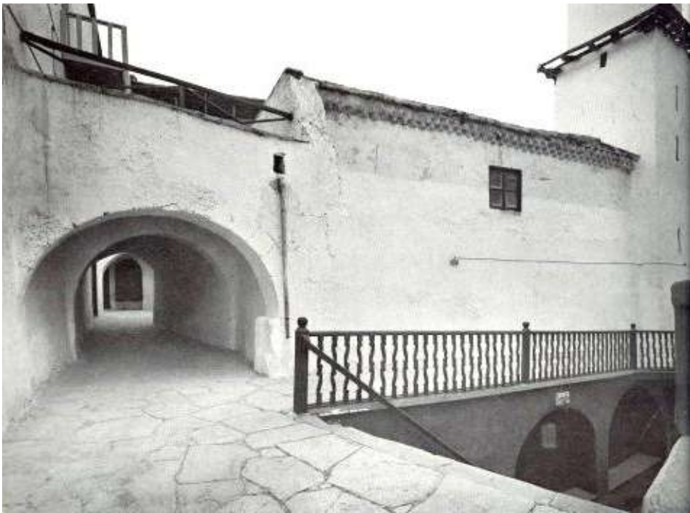
Εικ. 387. Μονή Σινά. Ανατολική όψη τζαμιού με πλίνθινη οδοντωτή ταινία στο γείσο (Forsyth, The church and fortress, Πίν. XV).
