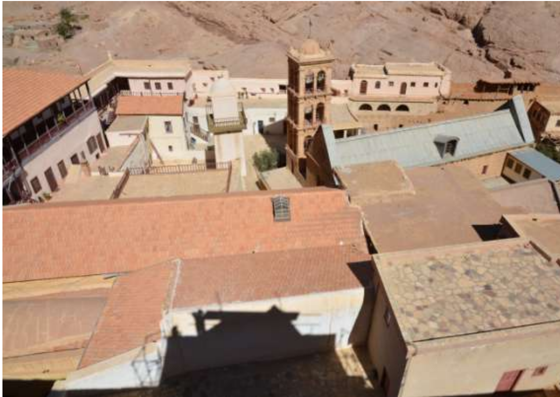
Εικ. 6. Μονή Σινά. Άποψη του δυτικού τμήματος του κεντρικού πυρήνα από νότια.
