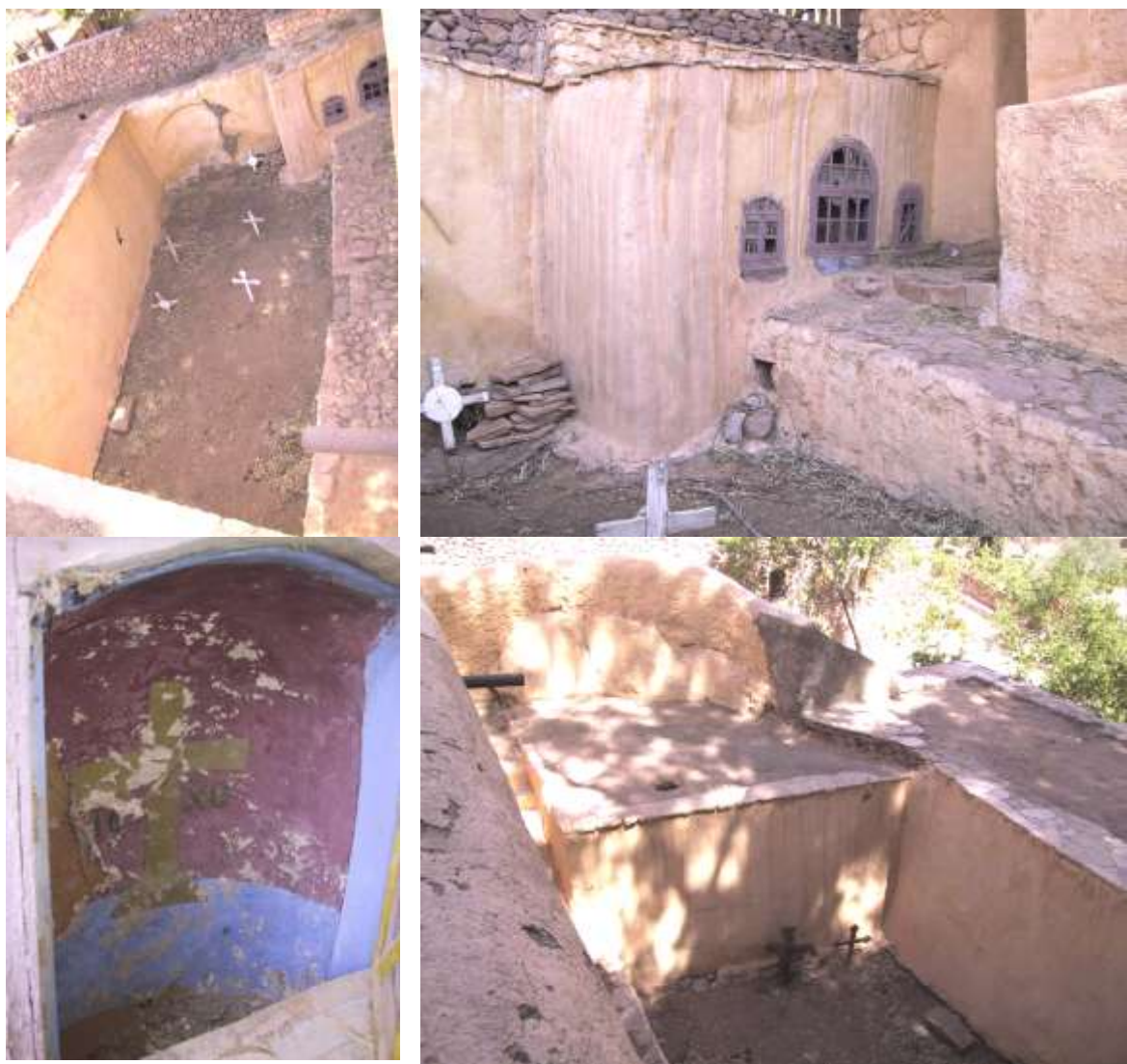
Εικ. 366-369. Κοιμητηριακό Παρεκκλήσιο Παναγίας. Απόψεις ερειπίων ανατολικού τοίχου παρεκκλησίου Παναγίας και γενική άποψη χώρου ταφών.
