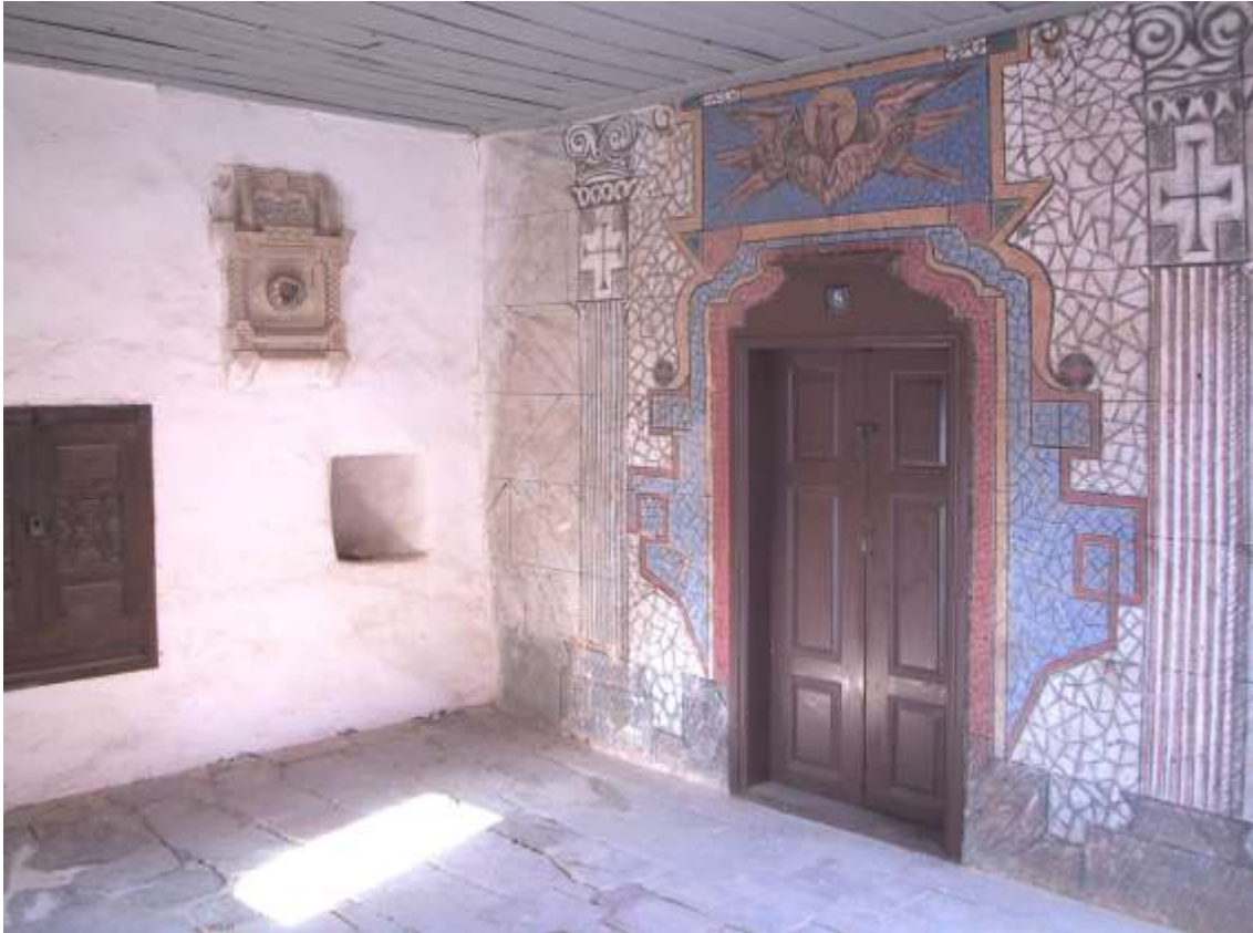
Εικ.355. Παρεκκλήσιο Αγίων Ιακώβου και Ιωάννου του Θεολόγου, άποψη της δυτικής εισόδου, του ημιυπαίθριου εξωνάρθηκα και τμήματος του εξωτερικού βόρειου τείχους.
