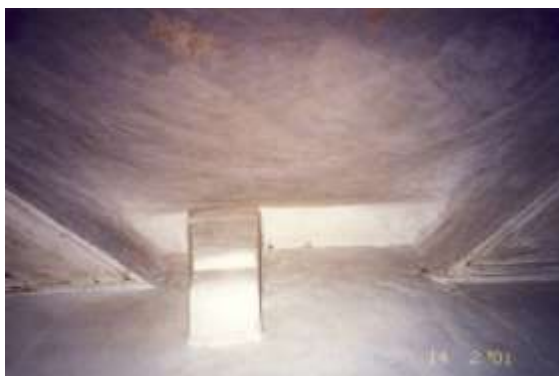
Εικ. 103-104. Καθολικό, παρεκκλήσιο Αγίων Πατέρων. Λεπτομέρειες της έδρασης του θόλου στο δυτικό τοίχο στη νοτιοανατολική γωνία του παρεκκλησίου.
