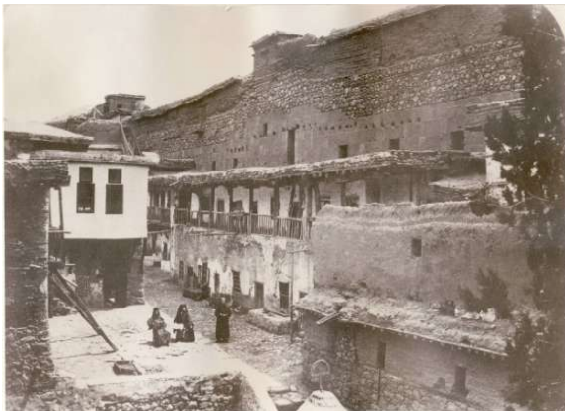
Εικ.183. Μονή Σινά, νοτιοδυτική αυλή. Πάνω από το δώμα της νότιας πτέρυγας διακρίνεται η είσοδος στο παρεκκλήσιο του Νότιου τείχους, 1869. (Wilson, Palmer, Ordnance Survey ).
