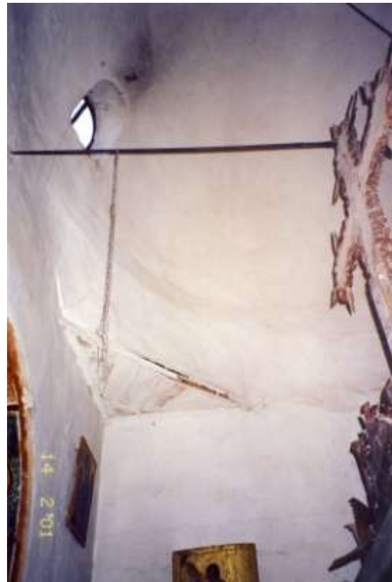
Εικ.74-75. Καθολικό, παρεκκλήσιο Αγίου Ιακώβου Αδελφοθέου. Η έδραση του θόλου στη βορειοδυτική γωνία και νοτιοανατολική γωνία του παρεκκλησίου.
