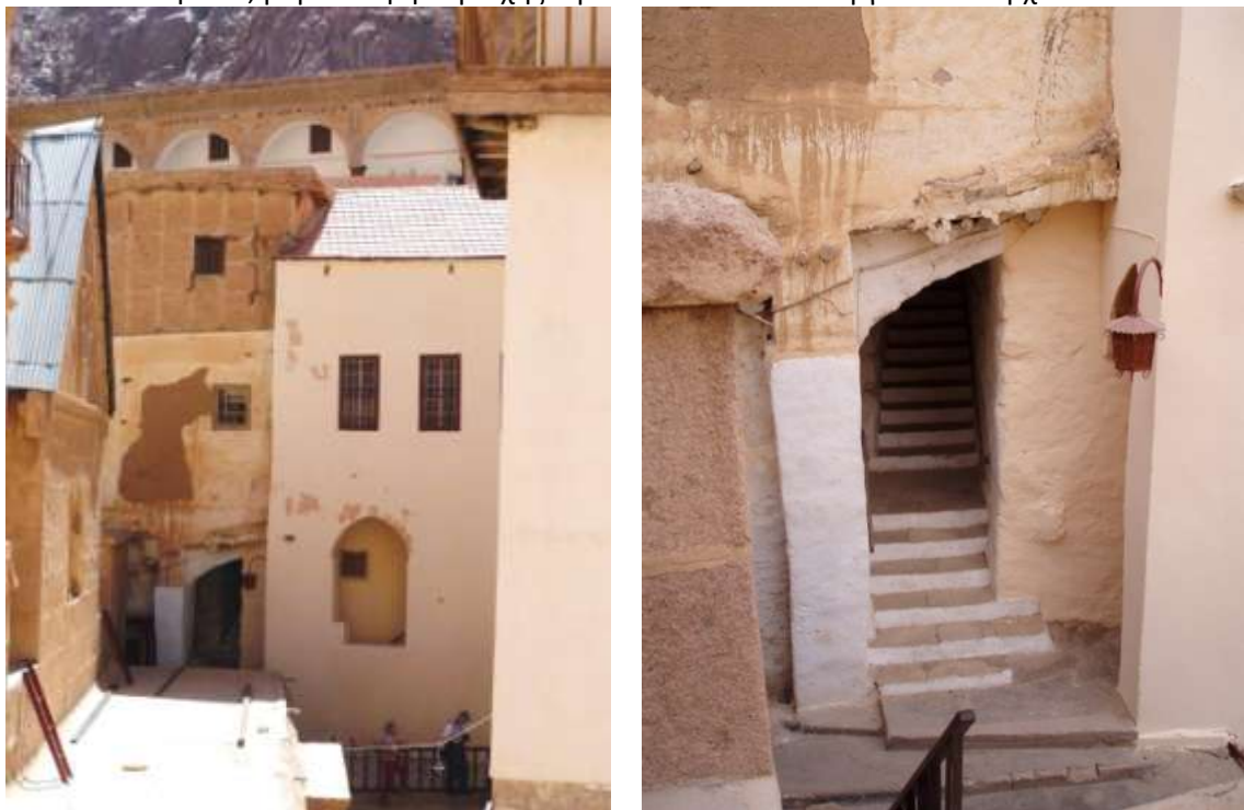
Εικ. 15-16. Μονή Σινά, βόρεια όψη περιοχής προΐουστινάνειου Πύργου και λεπτομέρεια της ΝΑ γωνίας του.
