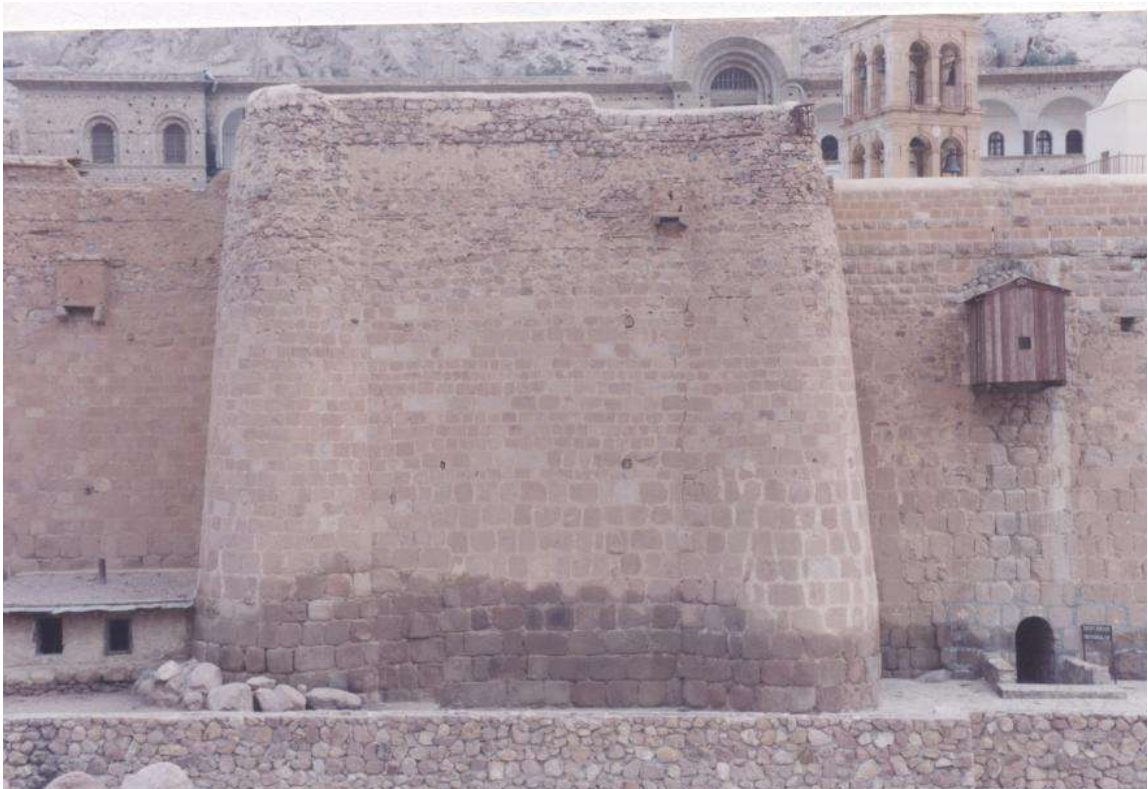
Εικ. 335. Άποψη της εξωτερικής πλευράς του πύργου του Αγίου Γεωργίου με το παρεκκλήσιο στην ανώτερη του στάθμη.
