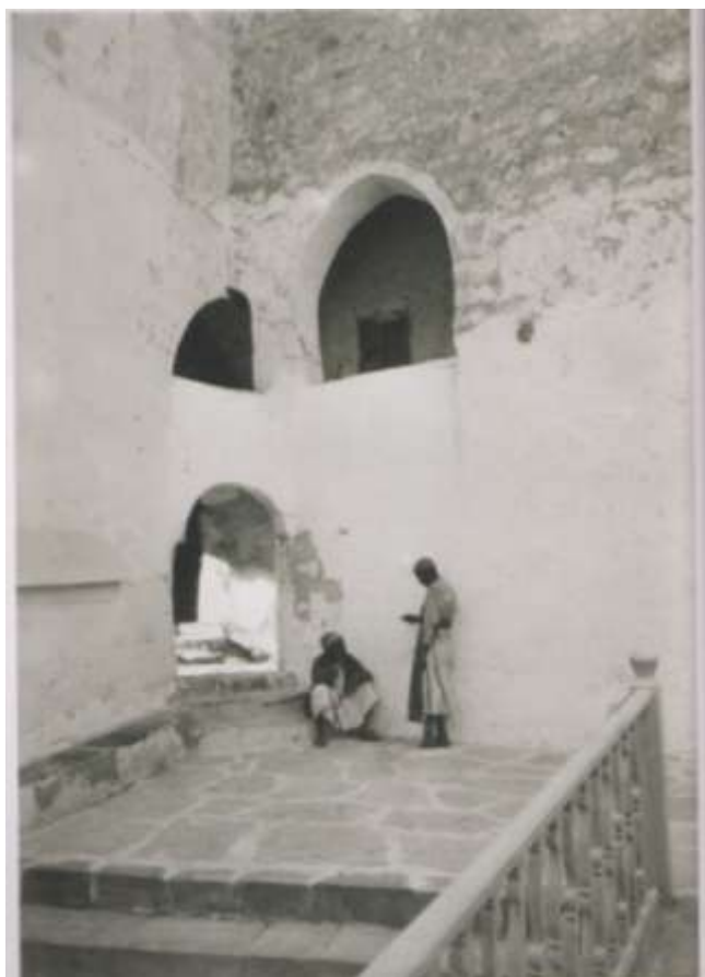
Εικ. 180. Άποψη στο νότιο άκρο της δυτικής όψης του Καθολικού με το τόξο που έφερε το παρεκκλήσιο του Αγίου Ιωάννου Θεολόγου το 1929 (Baddeley, Boissonas ,30).
