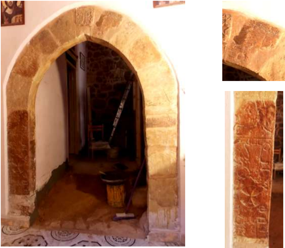
Εικ. 236 α-γ. Τμήματα του επιστυλίου του 6 ου αιώνα τοιχισμένα σε θύρωμα σε χώρο βόρεια του παρεκκλησίου του Αγίου Στεφάνου.
