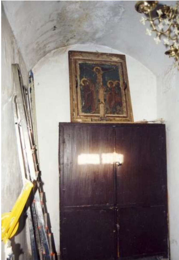
Εικ.142. Καθολικό, παρεκκλήσιο Αγίων Ιωακείμ και Άννας. Ο δυτικός τοίχος στη συμβολή με το βόρειο σώζει ίχνη απολαξυμένου λίθινου προβόλου.
