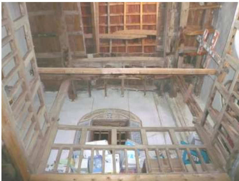
Εικ. 38-39. Άποψη του βόρειου τοίχου του παρεκκλησίου της Κοιμήσεως από το αίθριο του πύργου.
