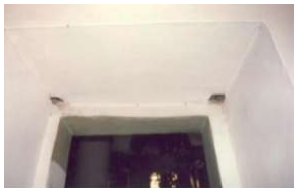
Εικ.154. Καθολικό. Παρεκκλήσιο Αγίου Συμεών Στυλίου. Η θύρα εισόδου με ίχνη στροφών στο υπέρθυρο.
