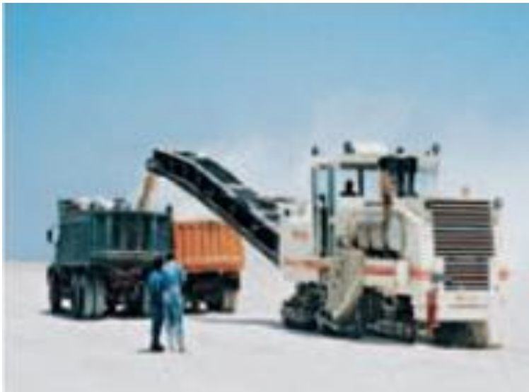
Εικόνα 3. 34. Παράλληλη κίνηση φορτηγών πριν την αλλαγή. Wirtgen (2010).
