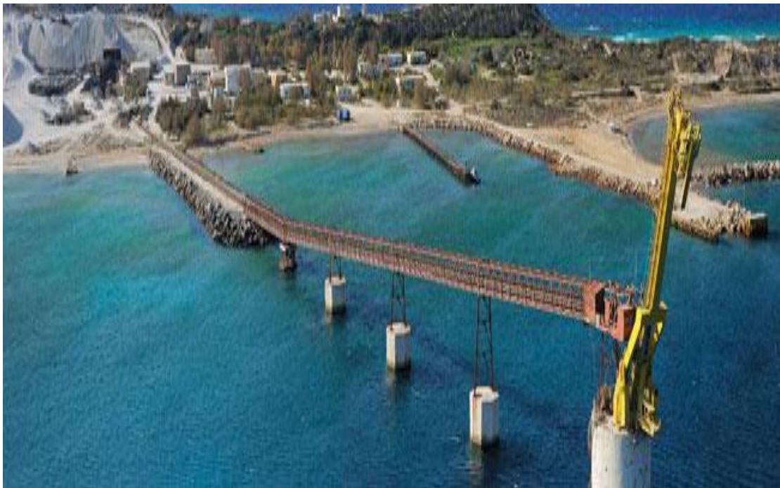
Εικόνα 4. 4. Εγκατάσταση φόρτωσης φορτηγών πλοίων. ΛΑΒΑ ΑΕ
