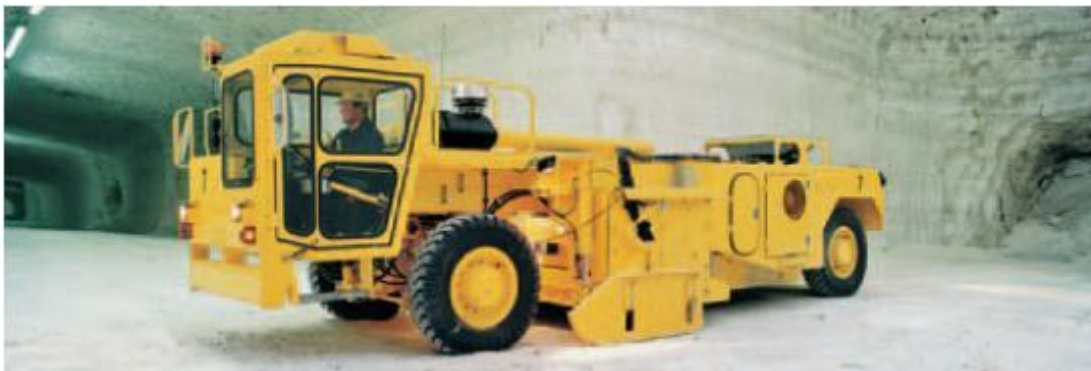
Εικόνα 3. 4. Αποκατάσταση οδού σε υπόγειο ορυχείο. Wirtgen (2010).
