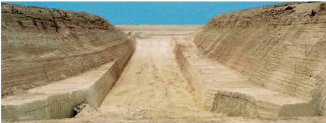
Εικόνα 3. 2. Εκσκαφή τάφρου με surface miner. Wirtgen (2010).
