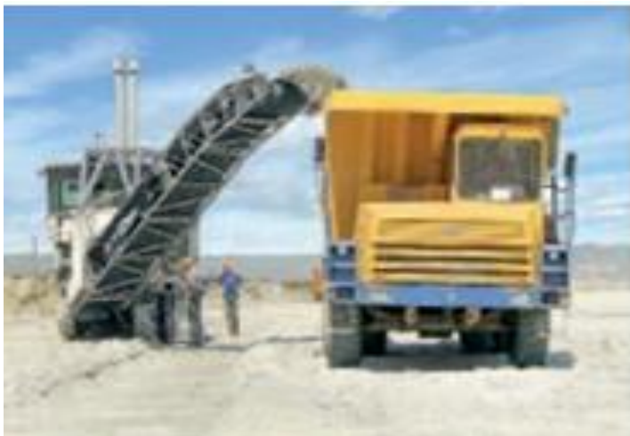
Εικόνα 3. 31. Άμεση φόρτωση υλικού πλευρικά. Wirtgen (2010).
