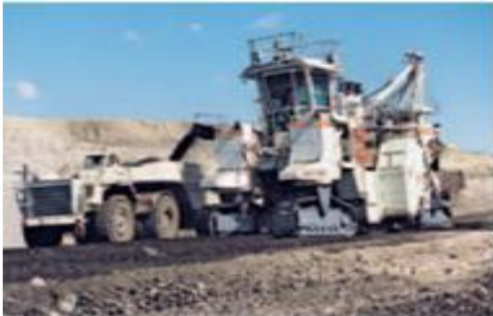
Εικόνα 3. 33. Άμεση φόρτωση υλικού. Wirtgen (2010).
