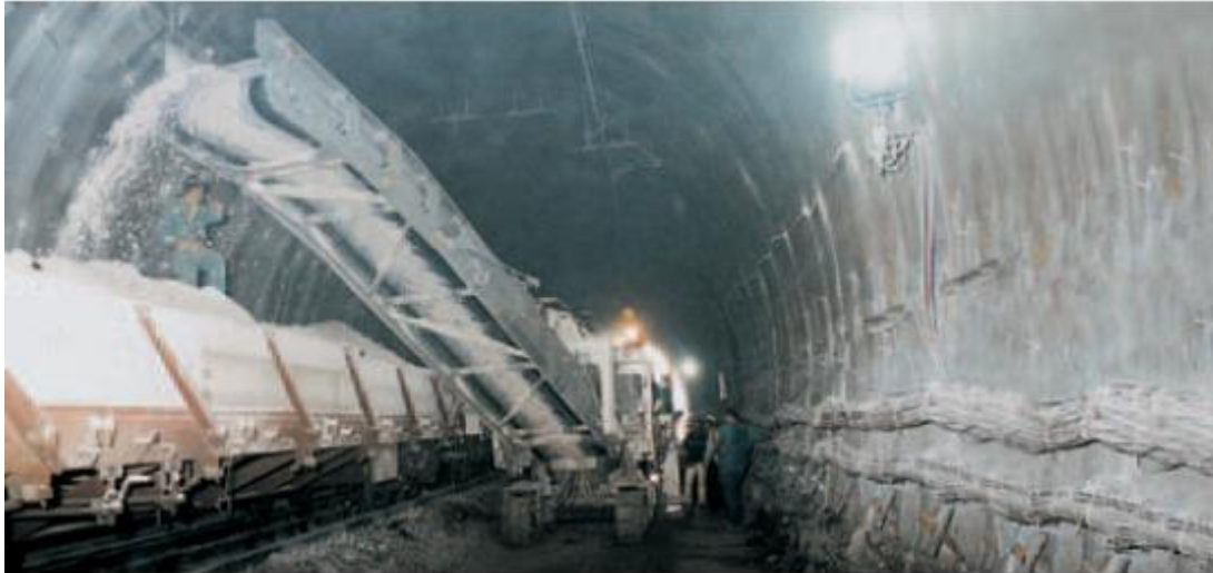
Εικόνα 3. 3. Διαμόρφωση δαπέδου υπόγειας στοάς. Wirtgen (2010).
