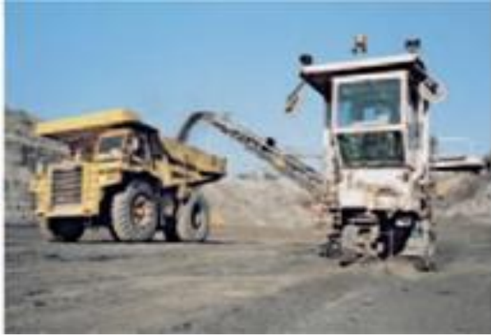
Εικόνα 3. 32. Άμεση φόρτωση υλικού. Wirtgen (2010).
