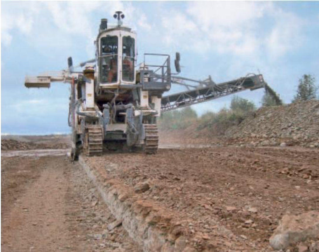
Εικόνα 3. 14. Εξόρυξη λεπτών στρωμάτων εδάφους. Wirtgen (2010).
