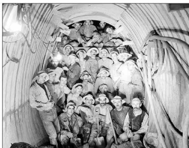
κατασκευή σήραγγας Μπογιατίου - 1928
