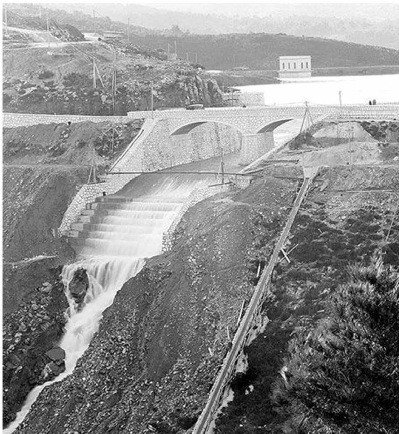
αστοχία κατά την κατασκευή
