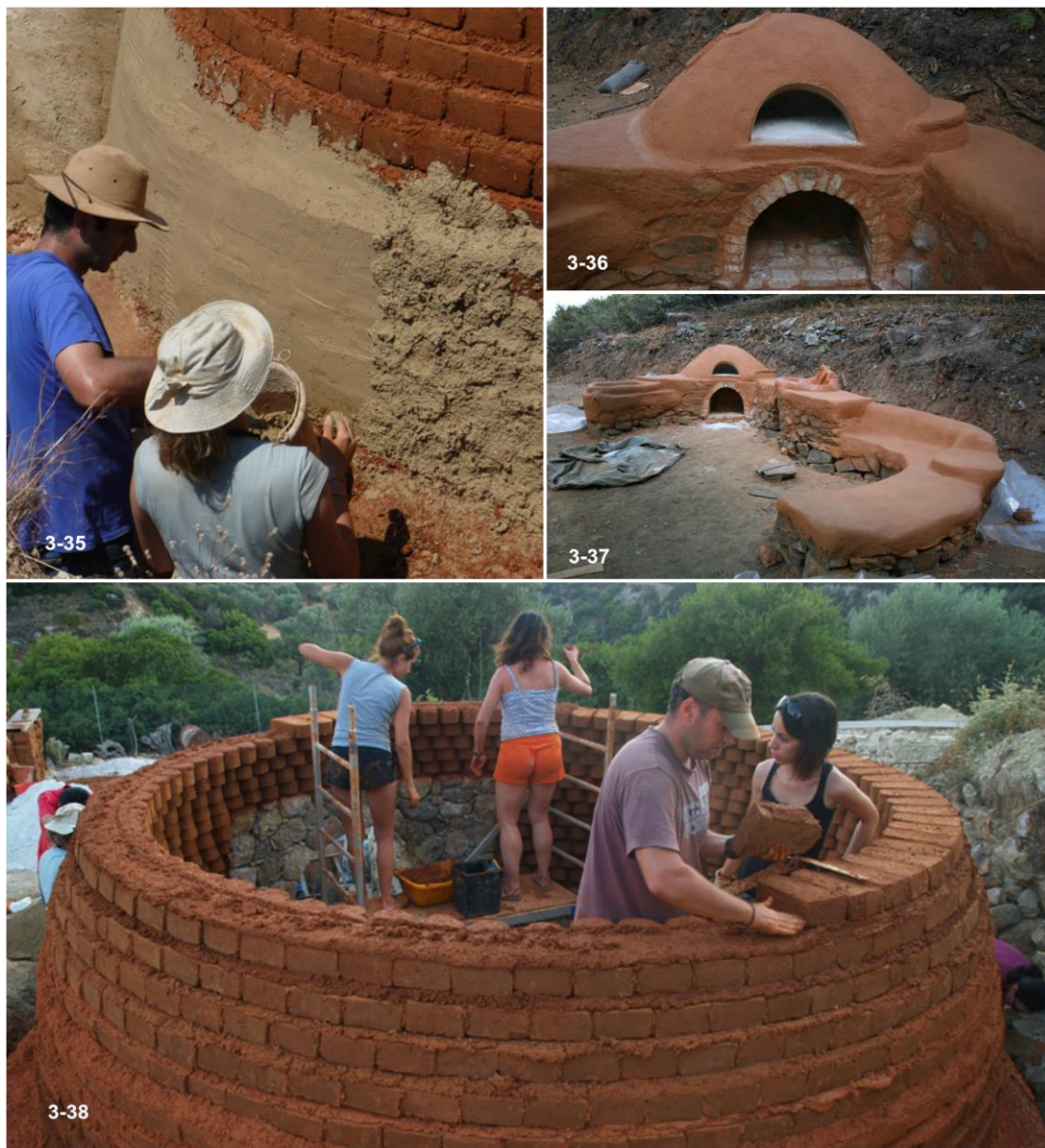
Εικ.3-35, 3-38: 3ο κατασκευαστικό σεμινάριο: «Κατασκευή θόλου με πλιθιές adobe», με συμμετοχή του καθηγητή Dr.Gernot Minke του Πανεπιστημίου Kassel της Γερμανίας, Ιούλιος 2011, Παλαιοχώρα, Χανιά. Εικ. 3-36, 3-37: 2ο κατασκευαστικό σεμινάριο: «Τεχνική cob», σε συνεργασία με την ομάδα Cob, Σέμπρωνας, Χανιά, Αύγουστος 2010. (Πηγή: www.piliko.gr )
