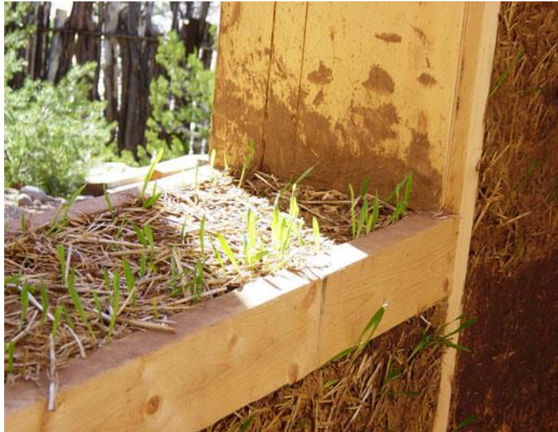
Εικ.2-10: Ξύλινος σκελετός με μείγμα από straw clay (Πηγή: http://www.econesthomes.com/ )
