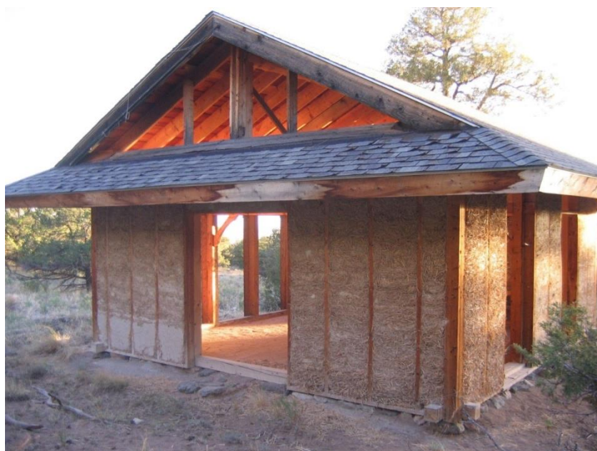
Εικ.2-9: Κατοικία στο Crestone του Κολοράντο. Ξύλινος σκελετός με μείγμα από straw clay
