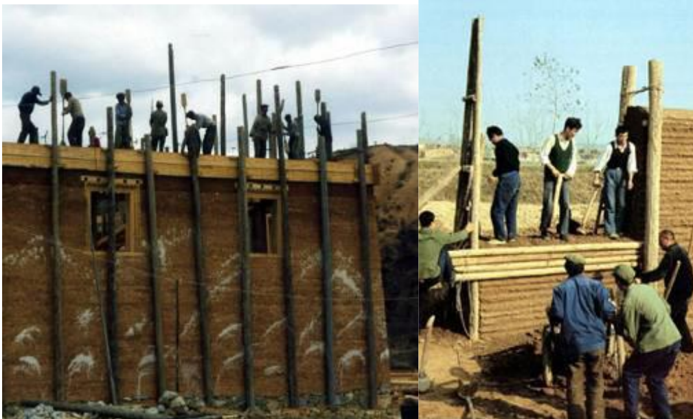
Εικ.2-12, 2-13: Χρήση καλουπιών για την κάθετη τεχνική rammed earth στην Κίνα
