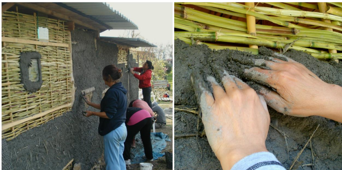
Εικ.2-14, 2-15: Τεχνική του τσατμά, εφαρμογή μείγματος πάνω σε πλεγμένα καλάμια (Πηγή: προσωπικό αρχείο)
