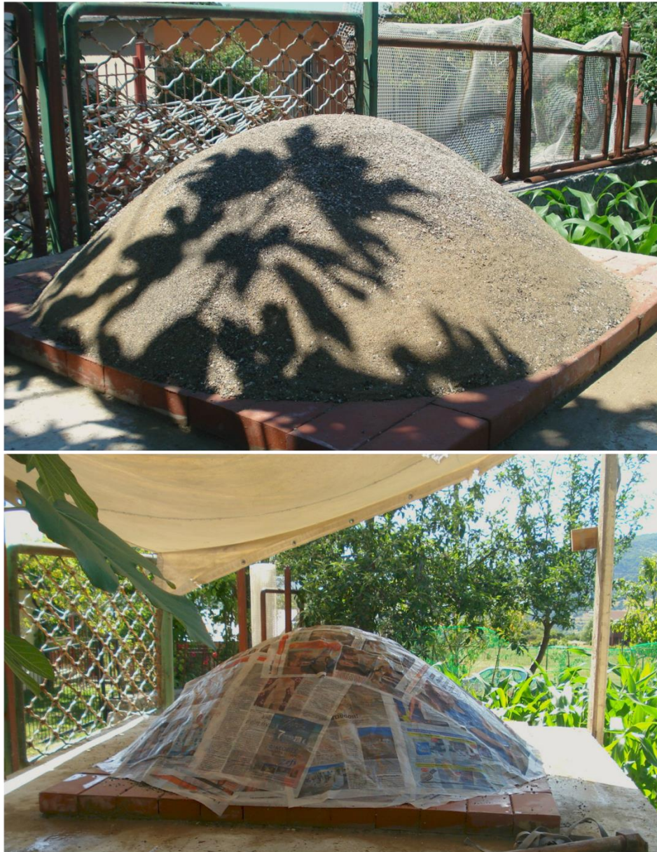
Εικ.5-8, 5-9: Δημιουργία καλουπιού και επικάλυψη με εφημερίδες (Πηγή: προσωπικό αρχείο)
