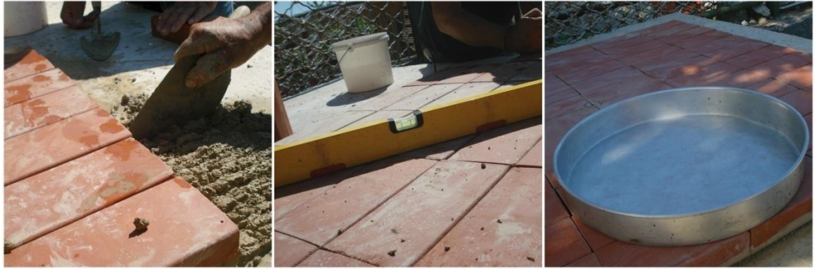
Εικ.5-3, 5-4, 5-5: Τοποθέτηση πυρότουβλων και μέτρηση διαστάσεων του φούρνου (Πηγή: προσωπικό αρχείο)
