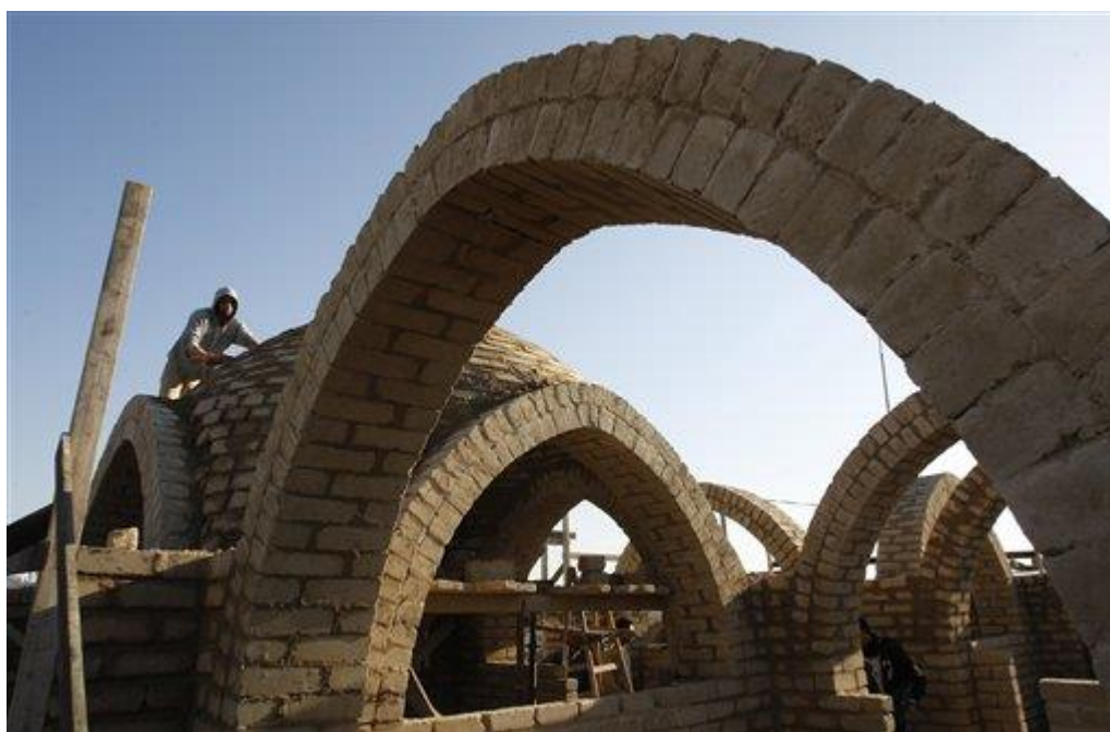
Εικ.3-18: Κατασκευή κατοικιών με τη μέθοδο των συμπιεσμένων ωμοπλίνθων
