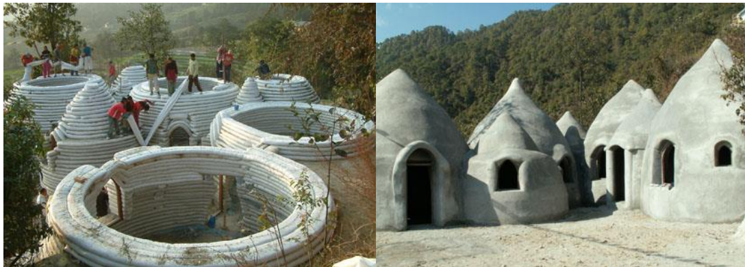
Εικ.3-20, 3-21: Κατασκευή κατοικιών στο Pegasus Children's Project με τη μέθοδο των superadobe
