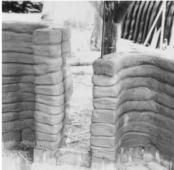
Εικ.2-17: Τοιχοποιία από εξώθηση πηλού, πειραματική κατοικία στο Πανεπιστήμιο του Kassel της Γερμανίας, 1982 (Πηγή: Building with earth, Gernot Minke, σελ. 76)
