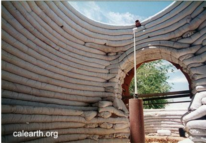
Εικ.2-16: Εσωτερική όψη από την κατασκευή μιας κατοικίας με την τεχνική των superadobe (Πηγή: http://calearth.org )
