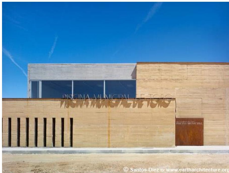
Εικ.3-7: Δημόσια πισίνα, Toro, Ισπανία (Πηγή: http://eartharchitecture.org )
