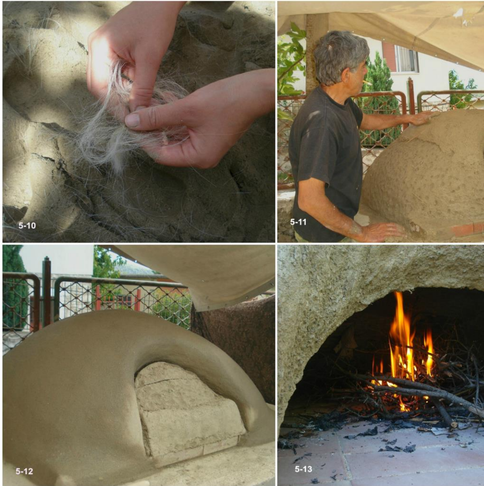
Εικ.5-10: Χρήση γιδόμαλλου για το επίχρισμα Εικ.5-11: Κατασκευή φούρνου Εικ.5-12: Ολοκληρωμένη όψη Εικ.5-13: Το πρώτο κάψιμο (Πηγή: προσωπικό αρχείο)
