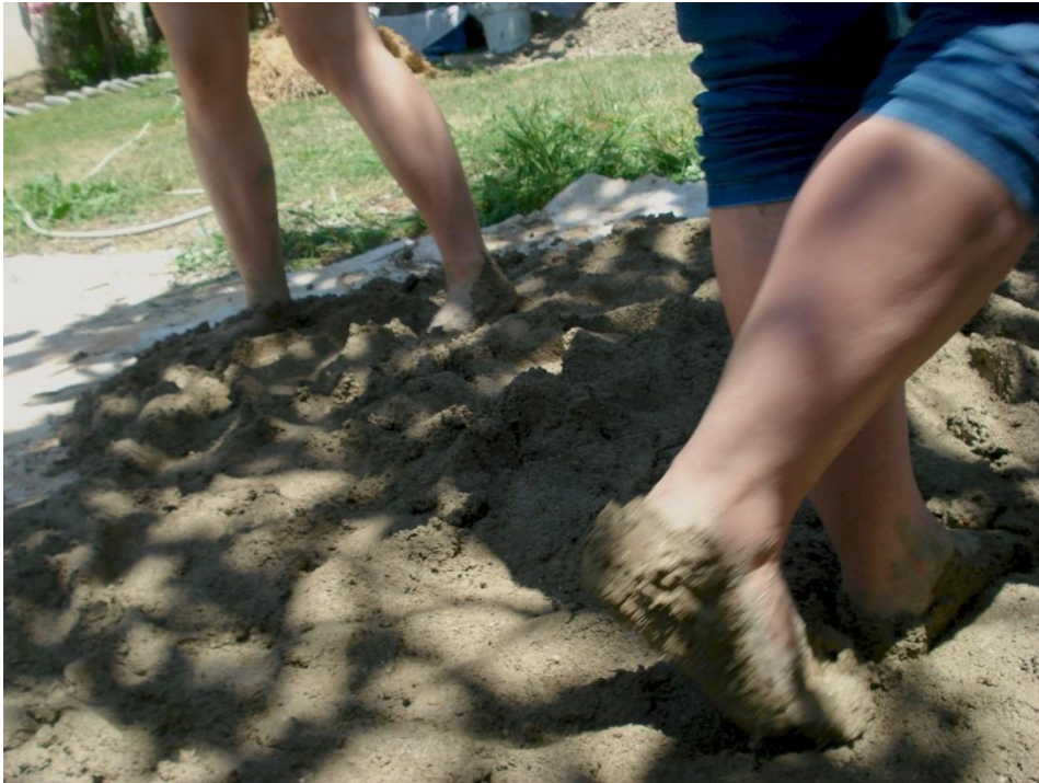
Εικ.5-1: Ανάμειξη υλικών με τα πόδια (Πηγή: προσωπικό αρχείο)
