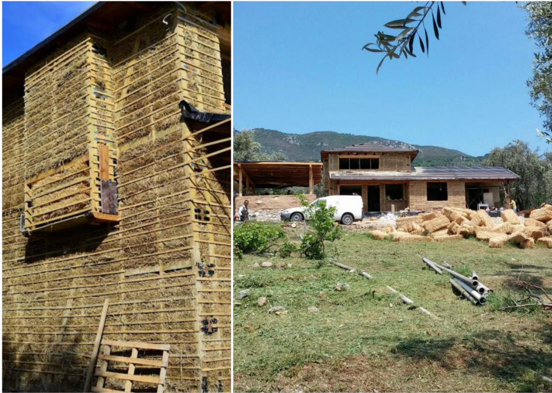
Εικ.3-30: Τοίχοι με αχυροπηλό. Εικ.3-31: Γενική όψη της κατοικίας, Αγριά, Βόλος
