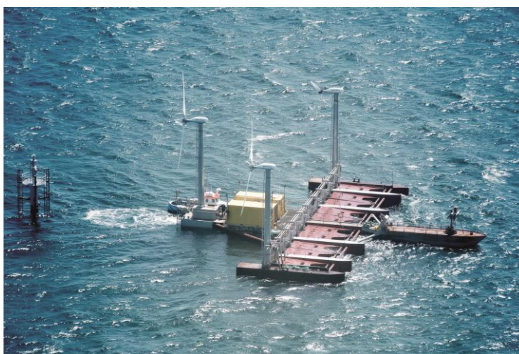
Εικόνα 2.33 Υβριδική κατασκευή Α/Γ με μηχανισμούς ανάκτησης κυματικής ενέργειας: Poseidon. Πηγή: [33]
