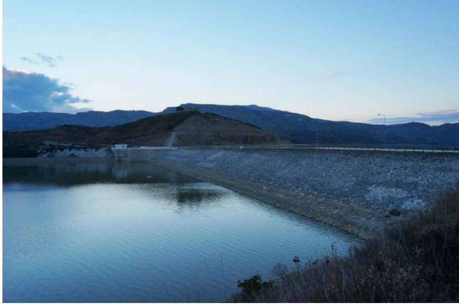
Εικόνα 3.2 Φράγμα Ποταμών Αμαρίου από την ανατολική πλευρά
