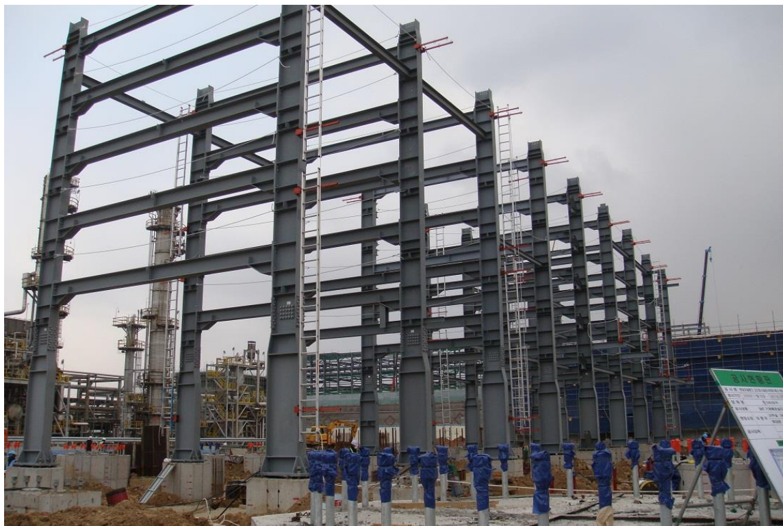
Εικόνα 2.5: Pipe rack στη φάση κατασκευής.
