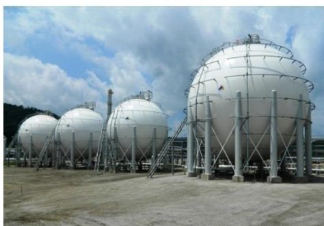
Εικόνα 2.2: Δεξαμενή (πάνω αριστερά), μονάδα κλασματικής απόσταξης (πάνω δεξιά), σφαιρικές δεξαμενές αποθήκευσης (κάτω αριστερά), οριζόντια κυλινδρικό δοχείο αποθήκευσης (κάτω δεξιά).
