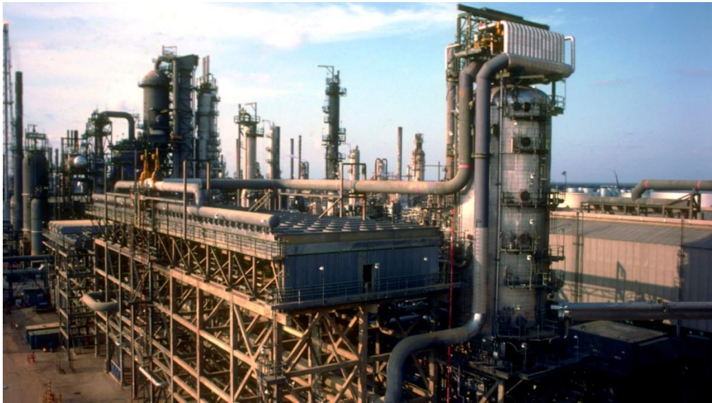
Εικόνα 2.3: Πλαισιακός φορέας υποστήριξης σωληνώσεων (pipe rack).
