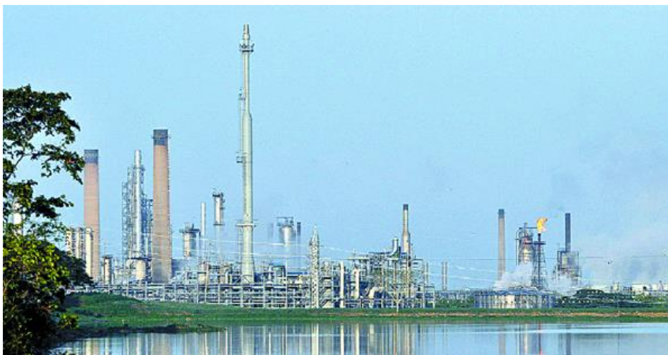
Εικόνα 2.1: Η μονάδα αλκυλίωσης της Petrotrin, Trinidad & Tobago.
