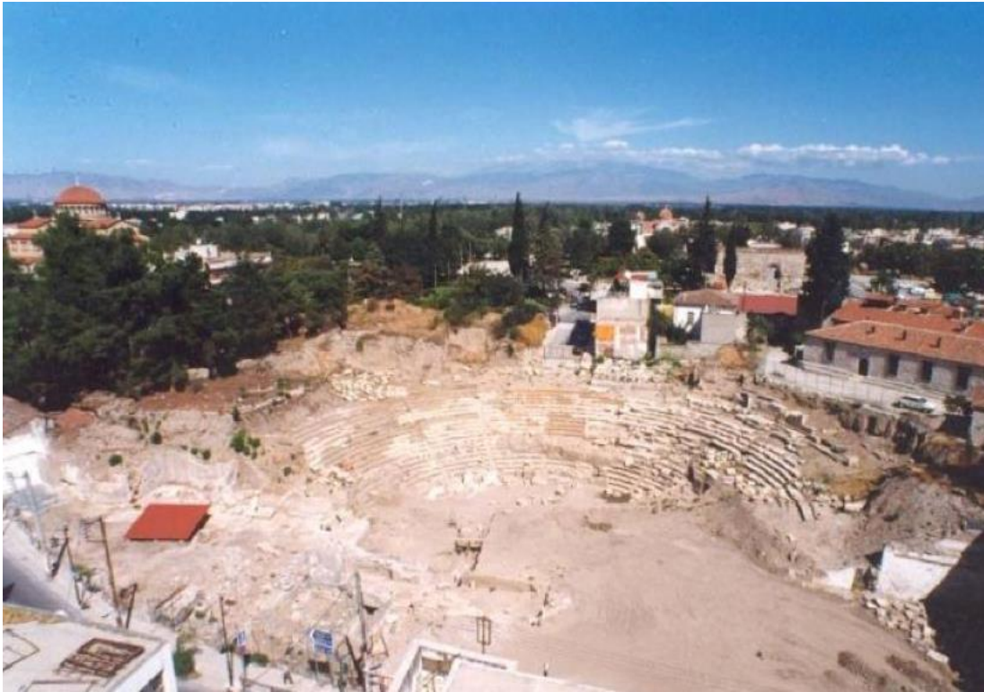
Εικόνα 63: Άποψη του θεάτρου μετά τη δεύτερη φάση κατεδαφίσεων, 1998.
