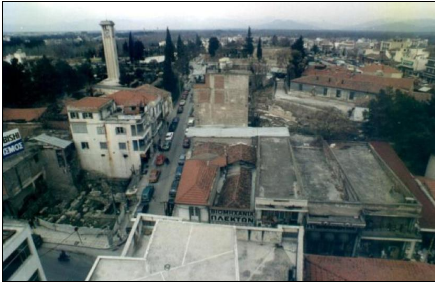
Εικόνα 58: Έναρξη κατεδαφίσεων απαλλοτριωμένων κτιρίων, 1992.
