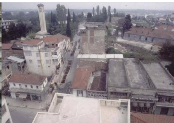
Εικόνα 56: Διάνοιξη οδός Παπαναστασίου, 1985
