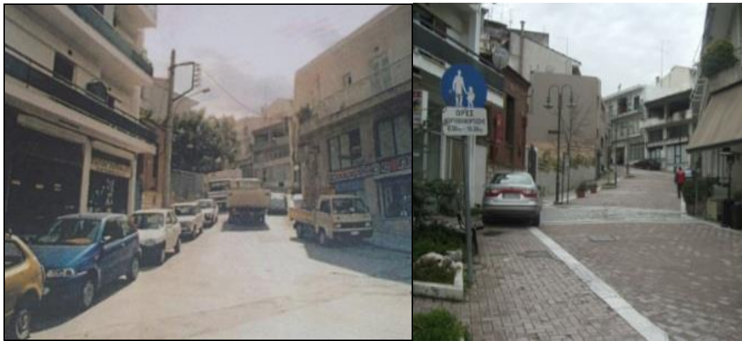
Εικόνα 95: πεζοδρόμηση οδού Φιλελλήνων
