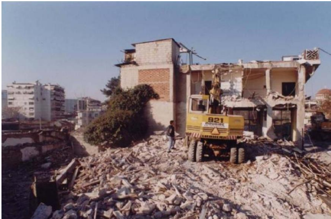
Εικόνα 64: Κατεδαφίσεις τρίτης φάσης απαλλοτριώσεων, 1999.
