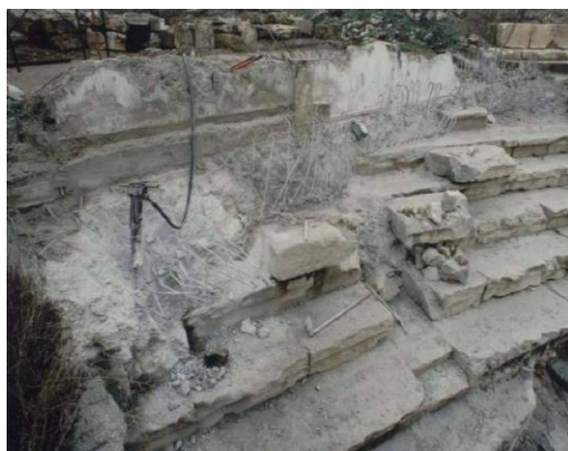
Εικόνα 55: Κατεδάφιση πρώτης οικοδομής, αποκάλυψη κερκίδων.
