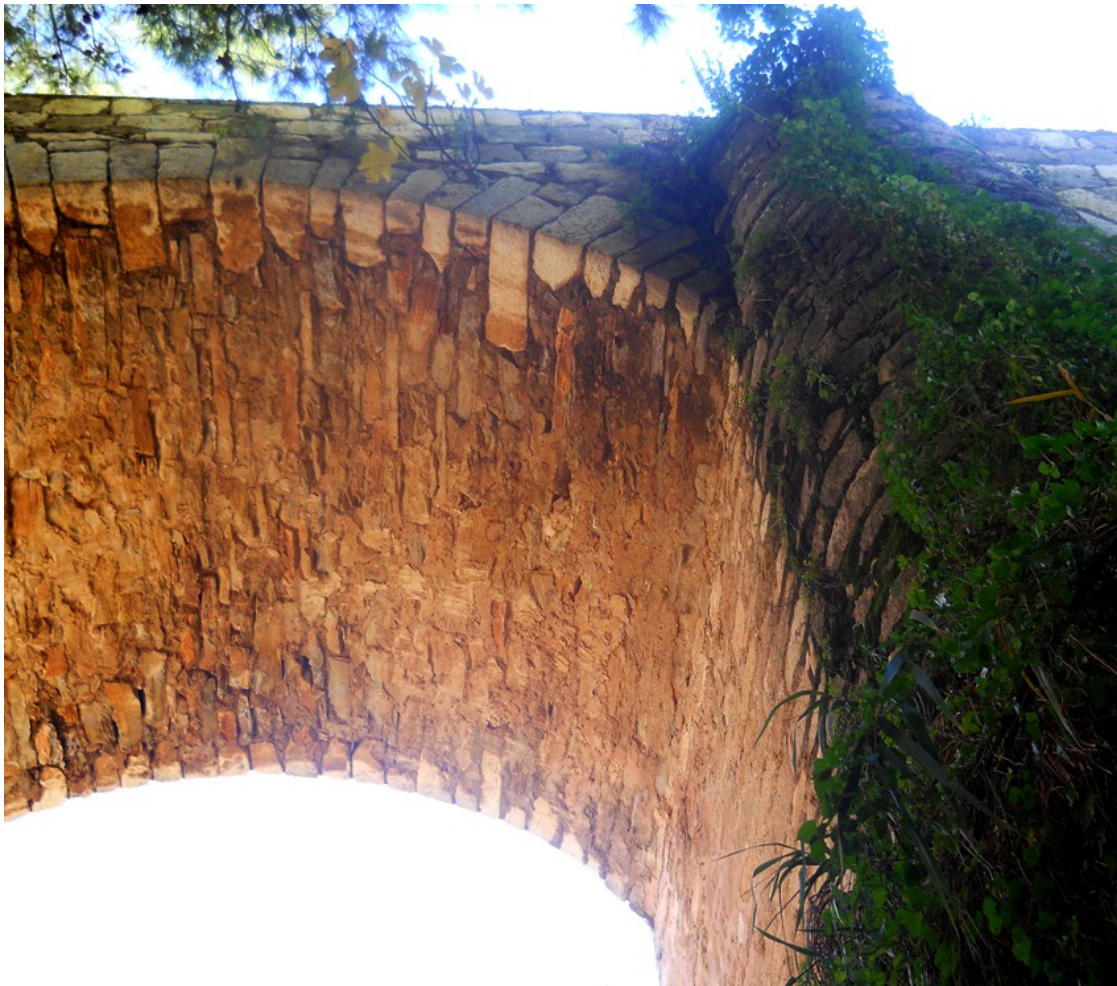
Εικ.75. Εσωρράχιο 4 ης καμάρας, διακρίνονται οι οπές από την πτώση των κονιαμάτων. Πηγή: Προσωπικό Αρχείο
