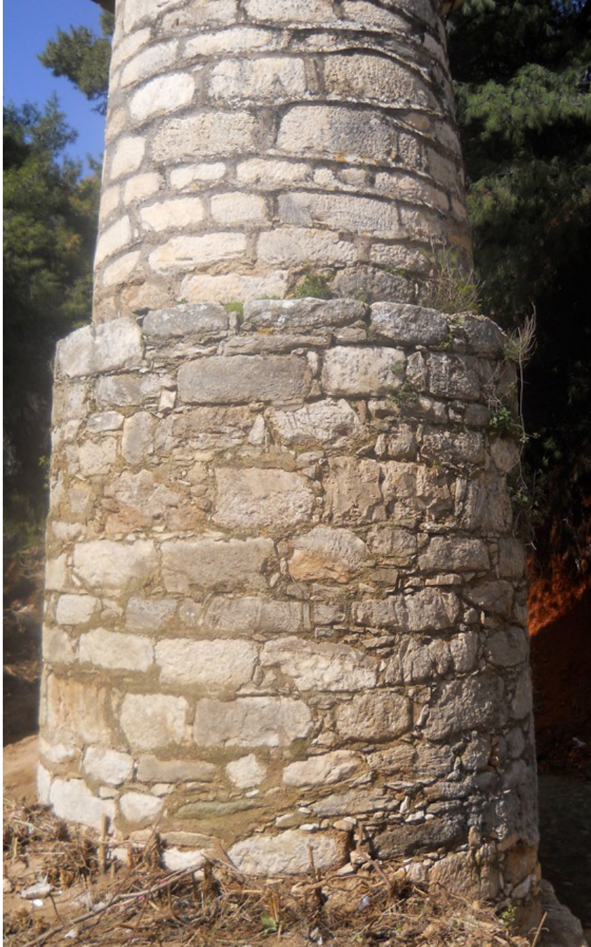
Εικ.74. Φθορά των διακοσμητικών αρμών στο 4 ο βάθρο στη βάση του. Το πάνω μέρος διατηρεί ακόμα τους αρμούς. Με την πτώση του αρμολογήματος αποκαλύφθηκαν οι μικρές πετρούλες που έμπαιναν στους αρμούς. Πηγή: Προσωπικό Αρχείο
