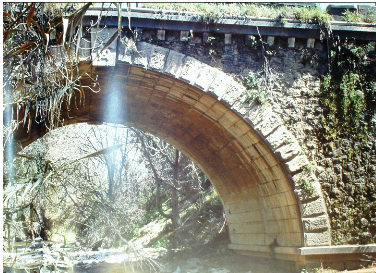
Εικ.29. Η γέφυρα του Γεώργιου Α΄ στον Κηφισό ποταμό Πηγή : Γ. και Ε. Μπεληγιάννη, Πέτρινα τοξωτά γεφύρια της Ελλάδας
