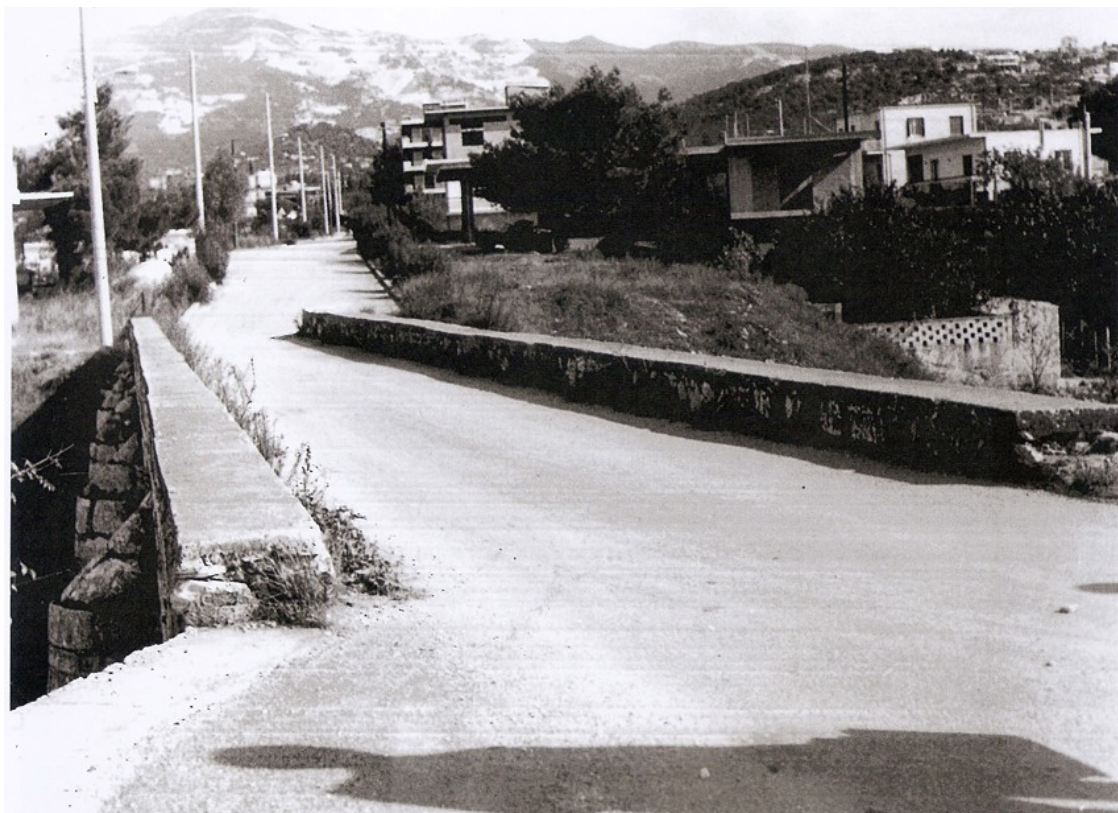
Εικ.52. Από τη φωτογράφιση στις 28-11-78, η γέφυρα χωρίς τα διαχωριστικά πεζούλια. Πηγή : Εφορεία Νεωτ. Μνημείων
