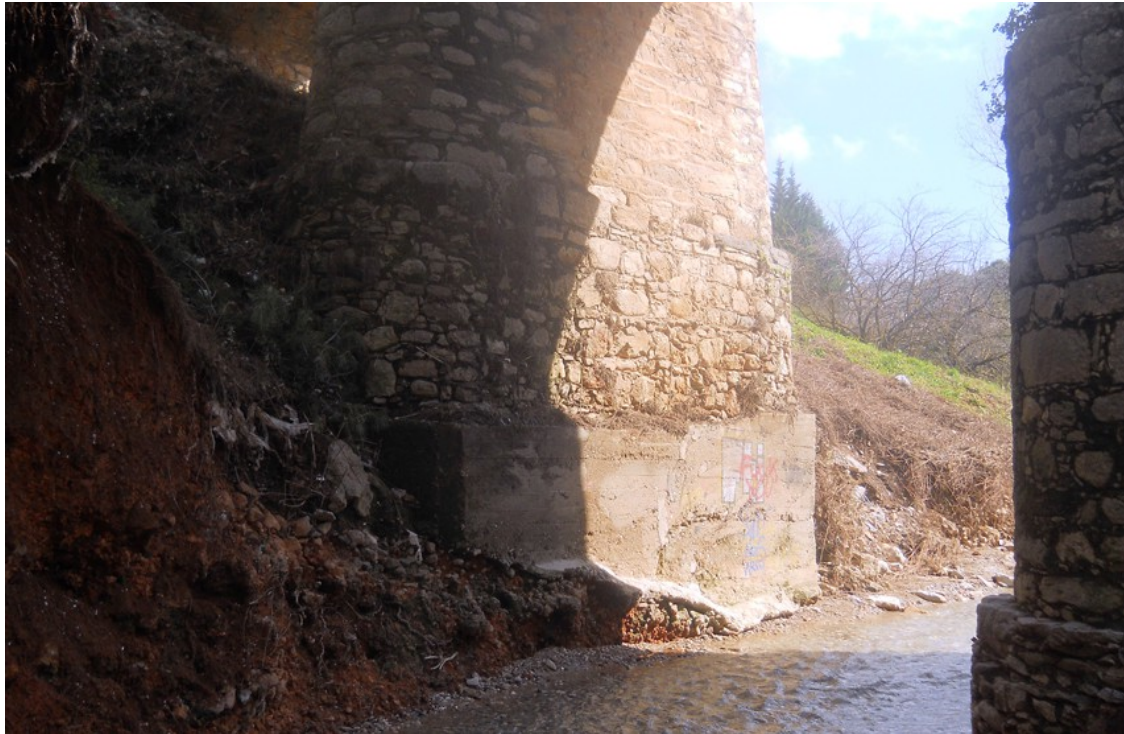
Εικ.72. Η τσιμεντένια ενίσχυση στη βάση του 5 ου βάθρου. Πηγή: Προσωπικό Αρχείο
