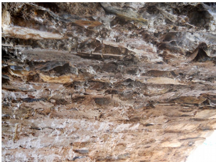
Εικ.75. Εσωρράχιο 4 ης καμάρας, διακρίνονται οι οπές από την πτώση των κονιαμάτων. Πηγή: Προσωπικό Αρχείο
