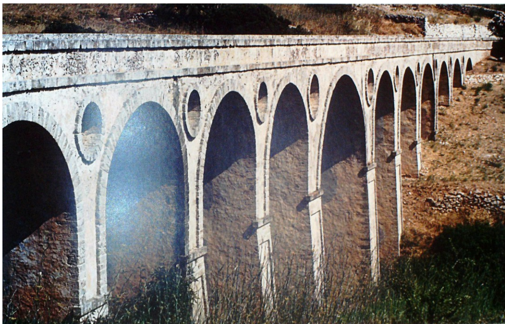
Εικ.40. Το γεφύρι του Κατουνιού.
