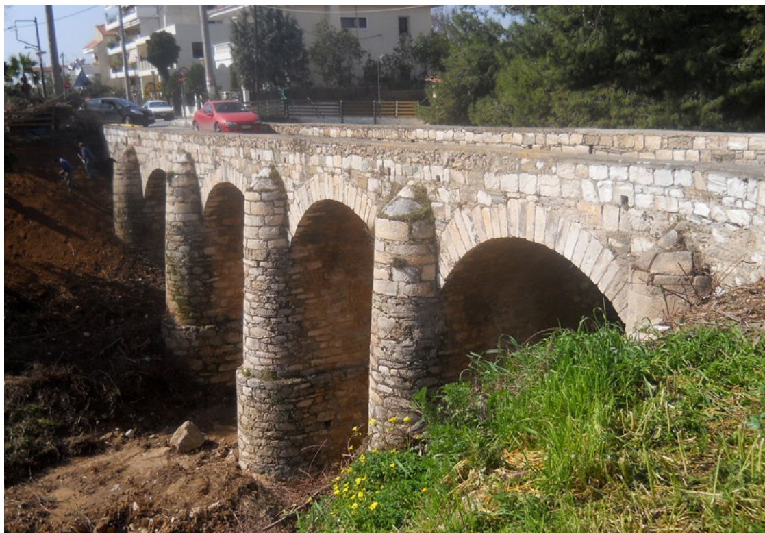
Εικ.13. Η γέφυρα της Δούκισσας, διακρίνεται ο βράχος στη βάση της μεσαικής καμάρας. Πηγή: Προσωπικό αρχείο
