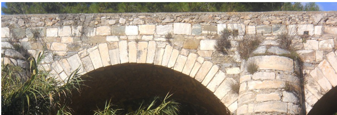
Εικ.70. Η υποβάθμιση των στηθαίων. Πηγή: Προσωπικό Αρχείο
