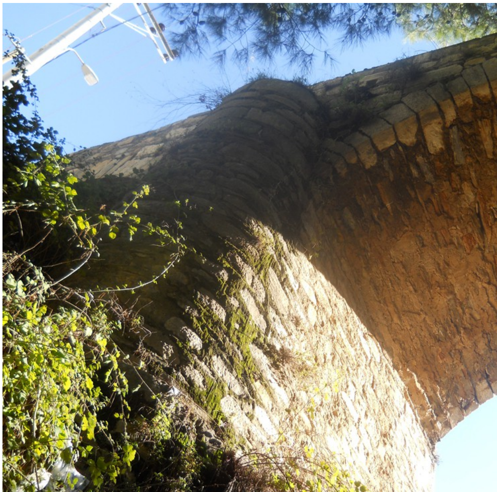
Εικ.77. Το 5 ο βαθρο από την δυτική πλευρά όπου παρατηρούνται βρύα και λειχήνες κάτω ακριβώς από την υδρορρόη αλλά και στην υπόλοιπη επιφάνεια.
