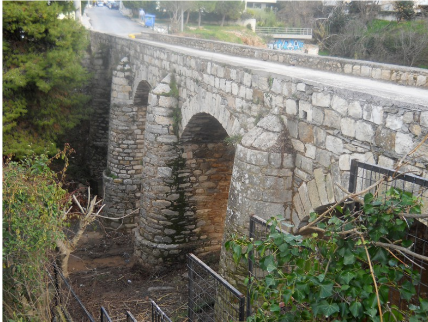
Εικ.78. Η δυτική όψη της γέφυρας και η γειτνίαση της με το φράχτη του παράνομου κτίσματος. Πηγή: Προσωπικό Αρχείο
