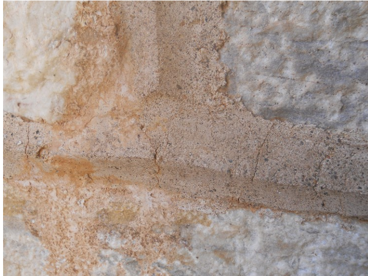
Εικ.65. Δείγμα των διακοσμητικών αρμών και του κονιάματος. Πηγή: Προσωπικό Αρχείο.
