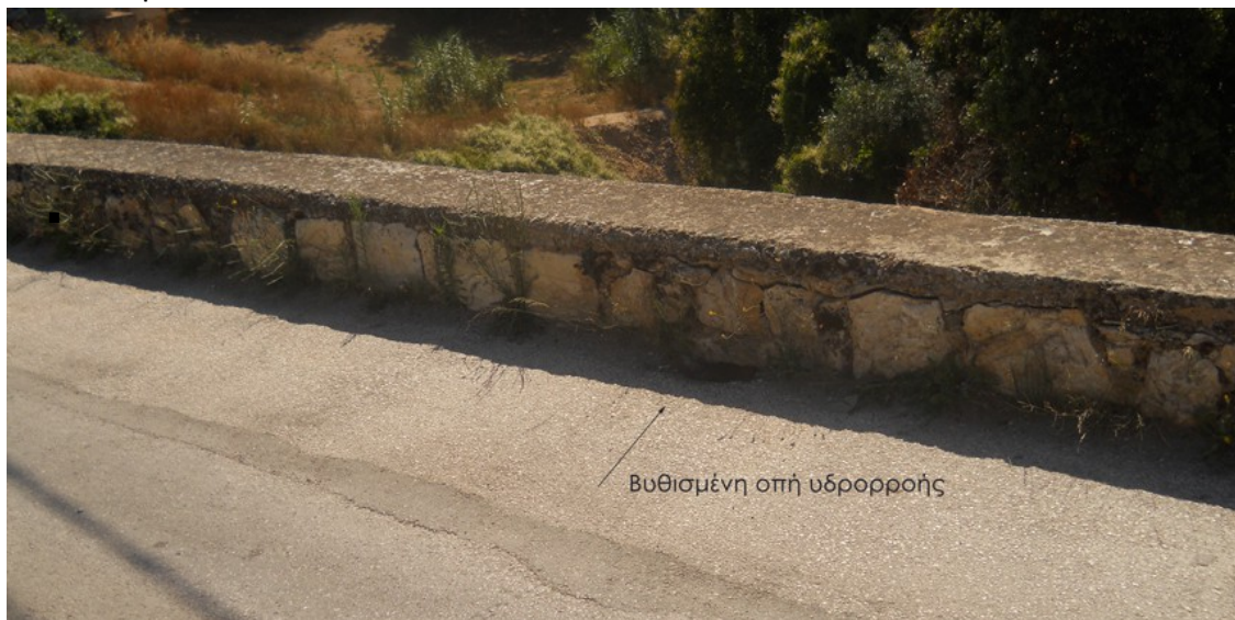
Εικ.73. Βυθισμένη οπή υδρορροής στην 1 η καμάρα. Πηγή: Προσωπικό Αρχείο
