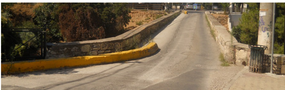
Εικ.71. Οι καμπύλες απολήξεις. Πηγή: Προσωπικό Αρχείο
