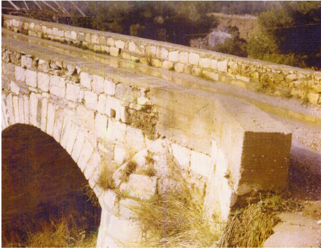
Εικ.53. Από τη φωτογράφιση στις 28-11-78, η τσιμεντένια βόρεια απόληξη της γέφυρας.
