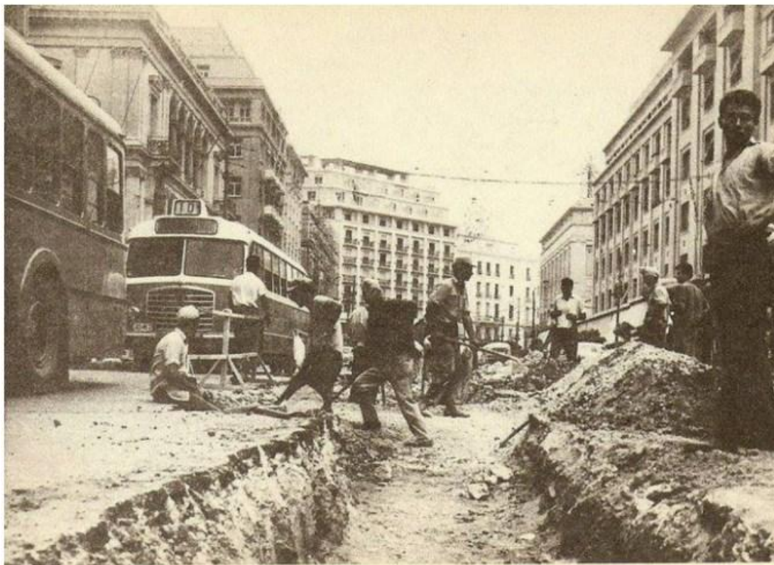
Έργα στην Πανεπιστημίου μετά το ξήλωμα της γραμμής του Τραμ Πηγή: http://www.mixanitouxronou.gr
