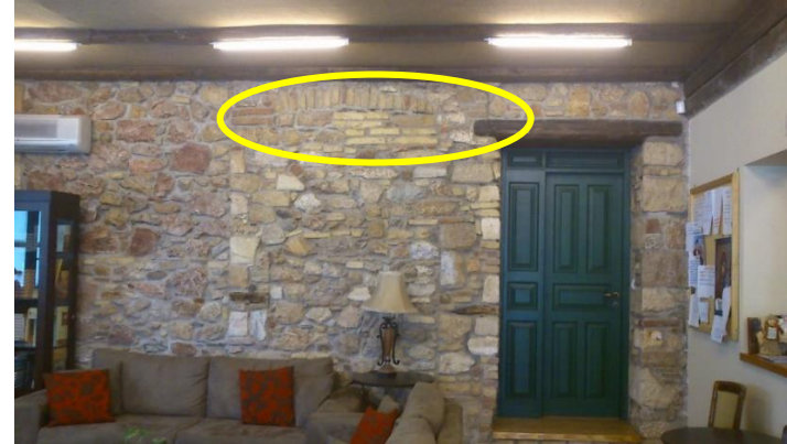
Εικόνα 67: Τόξο πάνω από παλαιότερο άνοιγμα- Ισόγειο οικίας Δουρούτη
