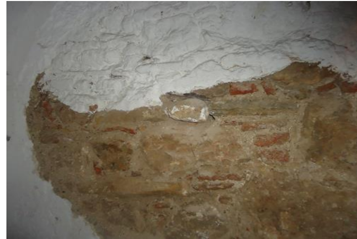
Εικόνα 40: Τοιχοποιία υπογείου οικίας Δουρούτη
