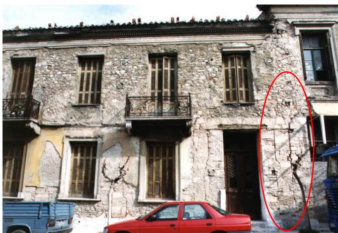
Εικόνα 63: Ασυνέχεια σε τμήμα του συγκροτήματος του Μεταξουργείου (Αρχείο Δήμου Αθηναίων)
