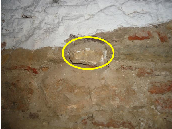
Εικόνα 68: Δειγματοληψία λίθου υπογείου
