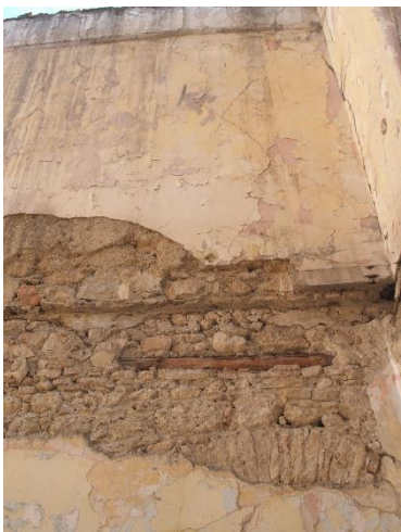
Εικόνα 56: Ξυλοδεσιά σε τμήμα του τοίχου σε διπλανό κτίριο( Αρχείο Δήμου Αθηναίων)
