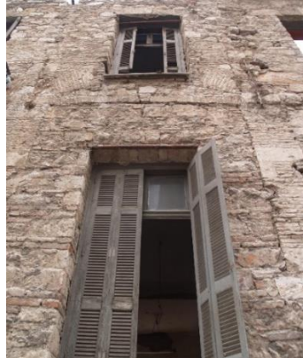
Εικόνα 66: Ανακουφιστικό τόξο (Αρχείο Δήμου Αθηναίων)
