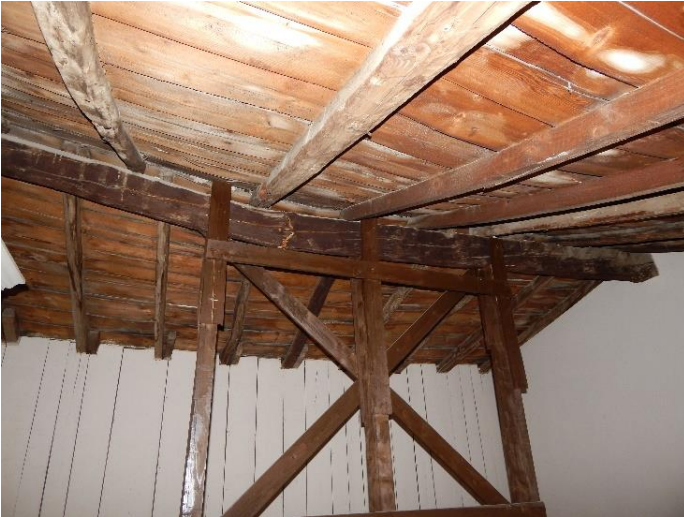
Εικόνα 4: Δίρριχτη στέγη εσωτερικά. (Χώρος σοφίτας)
