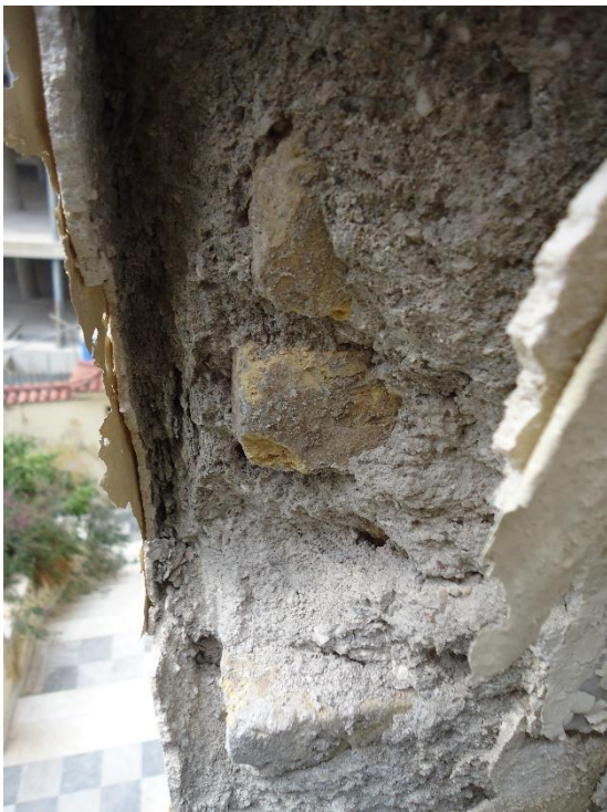
Εικόνα 18: Υλικό υποστυλωμάτων( υποστύλωμα β' ορόφου)
