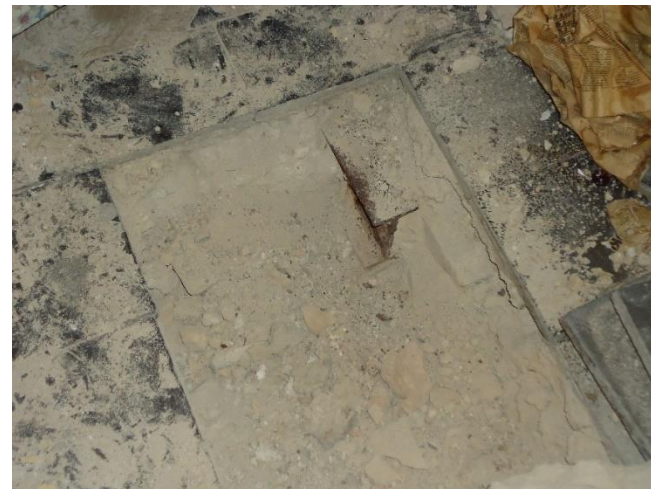
Εικόνα 11: Μεταλλική δοκός διπλού ταυ(διερευνητική τομή)
