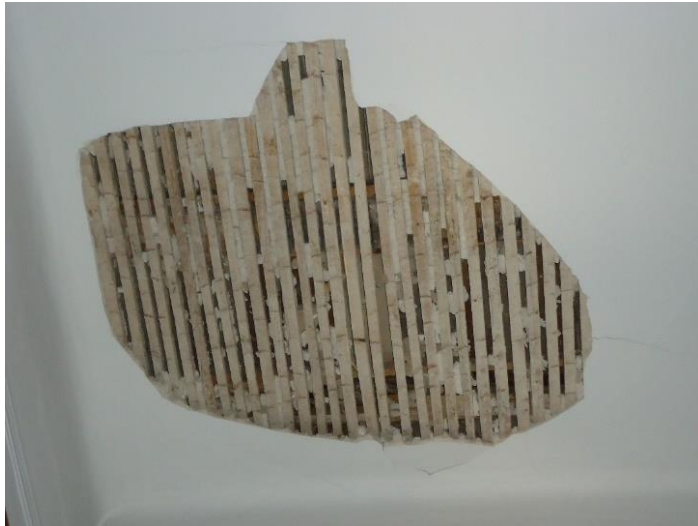
Εικόνα 9: Λεπτομέρεια ξύλινου πατώματος- εμφανές το μπαγδατί (Προσωπικό αρχείο Κάβουρας Μαρίας)
