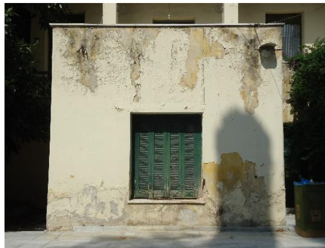
Εικόνα 21: Εντοπισμός υγρασίας.
