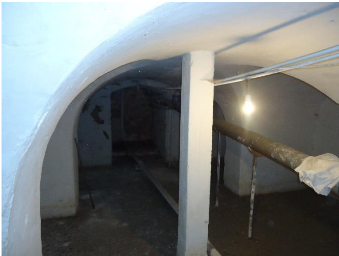
Εικόνα 25: Υποστύλωμα στο υπόγειο
