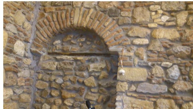
Εικόνα 59: Ξυλοδεσιά σε πιθανό παλιό άνοιγμα στο ισόγειο της οικίας Δουρούτη
