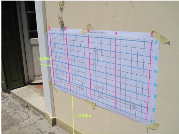
Εικόνα 56: Σημείο μέτρησης 3 εξωτερικά- Θέση κανάβου (κατεύθυνση μετρήσεων)
