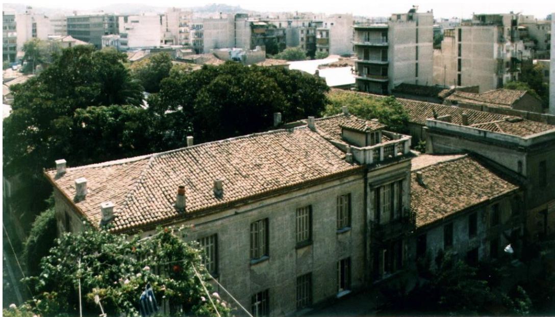
Εικόνα 38: Φωτογραφία πριν τις εργασίες αντικατάστασης του επιχρίσματος
