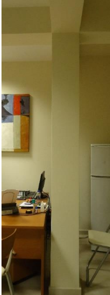
Εικόνα 134: Φωτογραφία εσωτερικού υποστυλώματος
