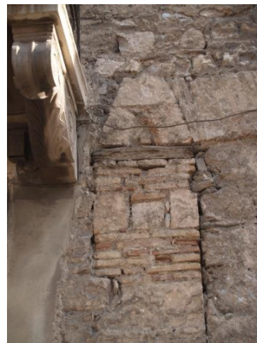
Εικόνα 57: Ξυλοδεσιά σε τμήμα παλαιότερου ανοίγματος- Συγκρότημα Μεταξουργείου(Αρχείο Δήμου Αθηναίων)
