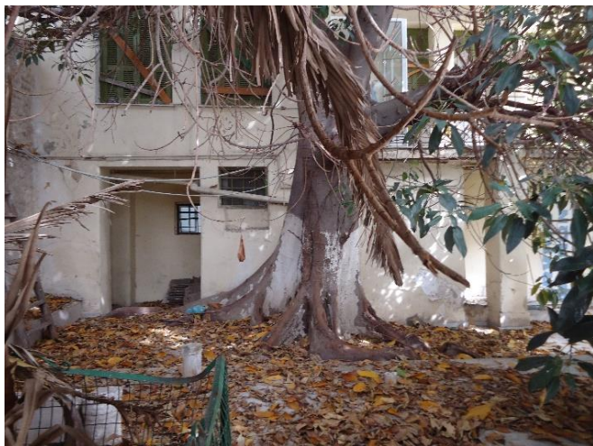
Εικόνα 20: Ο κορμός του δέντρου που εισέρχεται στην τοιχοποιία.
