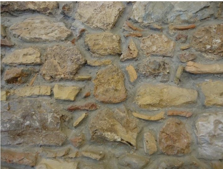
Εικόνα 23: Λεπτομέρεια τοιχοποιίας ισογείου
