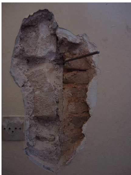
Εικόνα 70: Δειγματοληψία πλίνθου
