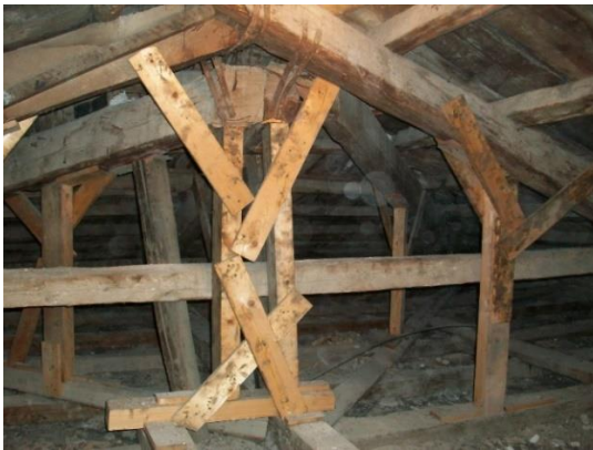
Εικόνα 7: Εσωτερικό στέγης- Πρόχειρες προσθήκες από τους ιδιοκτήτες(Προσωπικό αρχείο Πούλου Αθηνάς)
