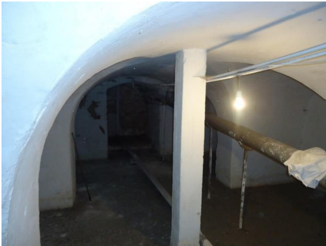
Εικόνα 27: Θόλοι υπογείου
