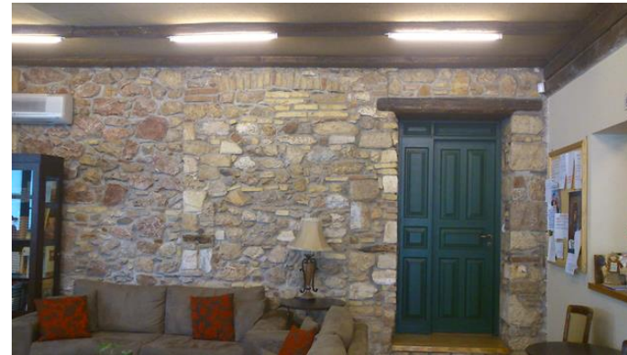
Εικόνα 42: Τοιχοποιία ισόγειου οικίας Δουρούτη (Λέσχη Φιλίας Δουρούτη)
