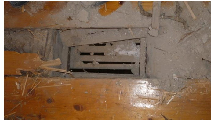
Εικόνα 48: Ξύλινες δοκοί πατώματος οικίας Δουρούτη
