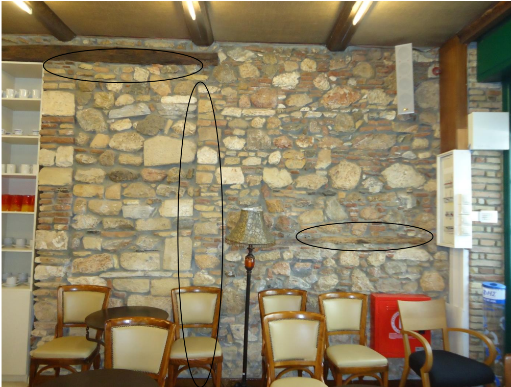
Εικόνα 33: Ασυνέχειες στη δομή της τοιχοποιίας καθώς και χρήση ξυλοδεσιών.
