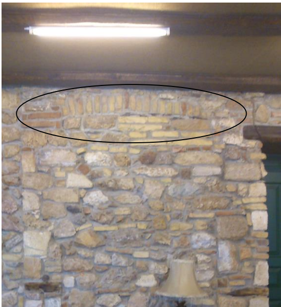
Εικόνα 34: Ενδεχόμενη ύπαρξη ανοίγματος στο σημείο με τόξο από πάνω του.
