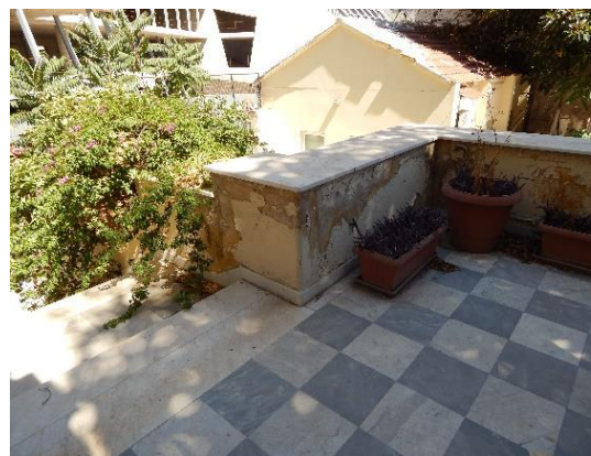
Εικόνα 23: Εντοπισμός υγρασίας.
