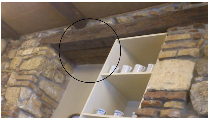
Εικόνα 36: Ξυλοδεσιά πάνω από παλαιότερο άνοιγμα.
