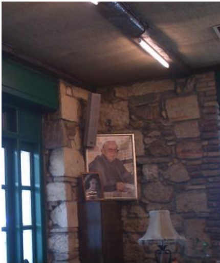
Εικόνα 111: Φωτογραφία πεσσού 1, εσωτερικά
