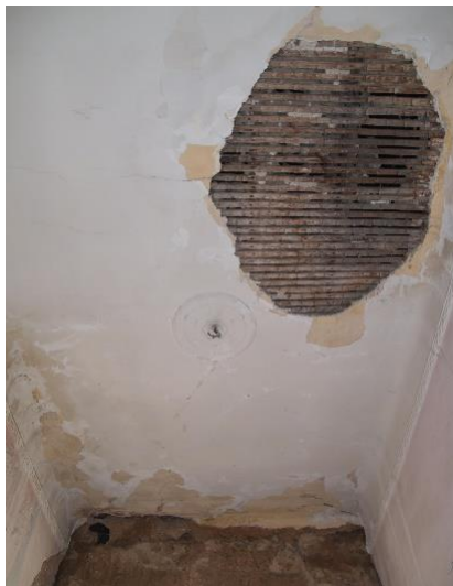
Εικόνα 43: Κάτω τμήμα πατώματος- Συγκρότημα Μεταξουργείου(Αρχείο Δήμου Αθηναίων)
