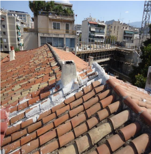
Εικόνα 2: Εξωτερική όψη στέγης. Βυζαντινά κεραμίδια και διαφορετικό υψόμετρο του κορφιά.
