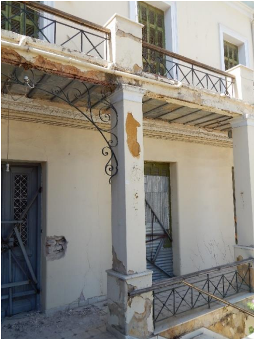
Εικόνα 19: Αποκόλληση επιχρίσματος και εντοπισμός υγρασίας.
