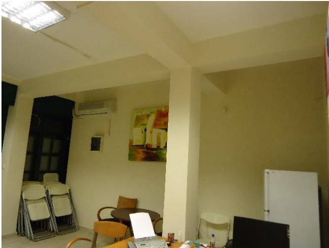
Εικόνα 24: Υποστύλωμα και δοκάρια στο ισόγειο
