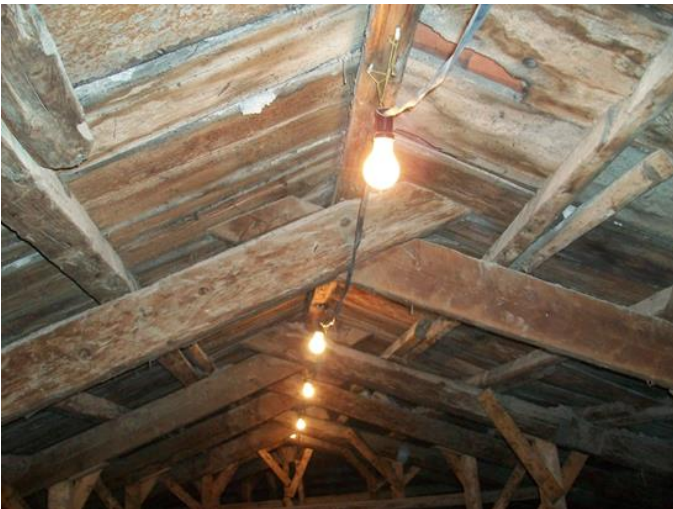
Εικόνα 5: Ζευκτά στέγης, εσωτερική όψη. (Προσωπικό αρχείο Πούλου Αθηνάς)
