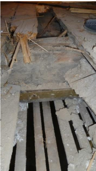
Εικόνα 9: Λεπτομέρεια ξύλινου πατώματος- εμφανές το μπαγδατί (Προσωπικό αρχείο Κάβουρας Μαρίας)
