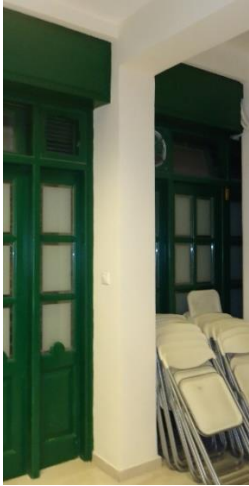
Εικόνα 132: Φωτογραφία πεσσού 5, εσωτερικά
