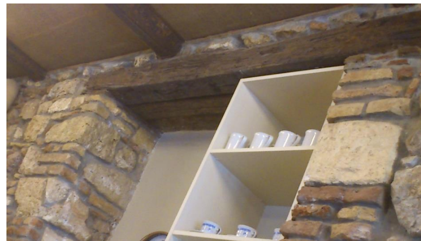
Εικόνα 61: Ξυλοδεσιά μεγάλου πλάτους( Ισόγειο Οικίας Δουρούτη)
