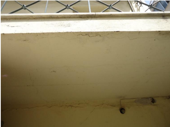
Εικόνα 171: Φωτογραφία δαπέδου μπαλκονιού α' ορόφου
