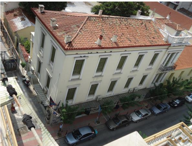
Εικόνα 3: Άποψη από ψηλά της στέγης. Γενική άποψη.
