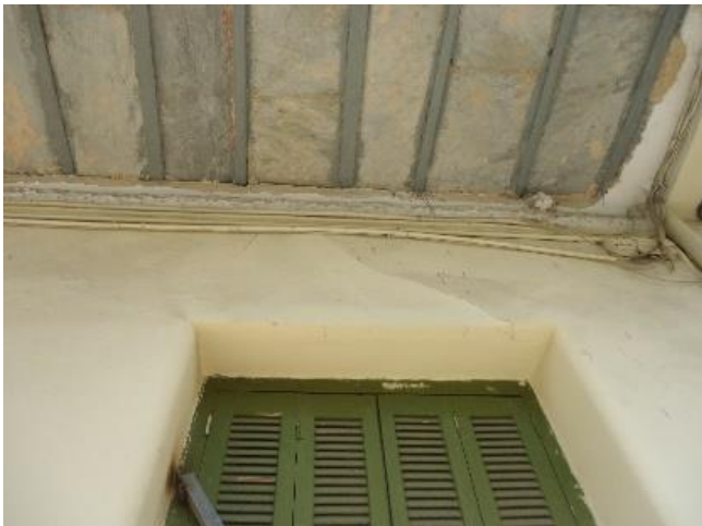
Εικόνα 14: Σχιστόλιθοι στο κάτω μέρος του μπαλκονιού.
