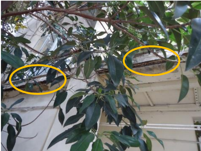
Εικόνα 12: Μεταλλική δοκός διπλού ταυ.
