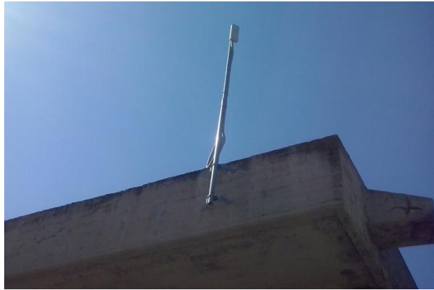
Εικόνα 7.6:5 Τελική τοποθέτηση πομποδέκτη
