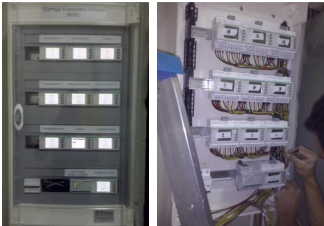
Εικόνα 7.4:3 Εγκατάσταση μετρητών ράγας σε εξωτερικό επίτοιχο πίνακα
