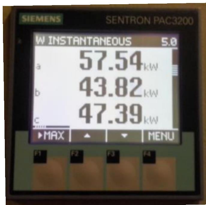
Εικόνα 7.4:4 Έλεγχος ενδείξεων για εντοπισμό λάθος ενδείξεων
