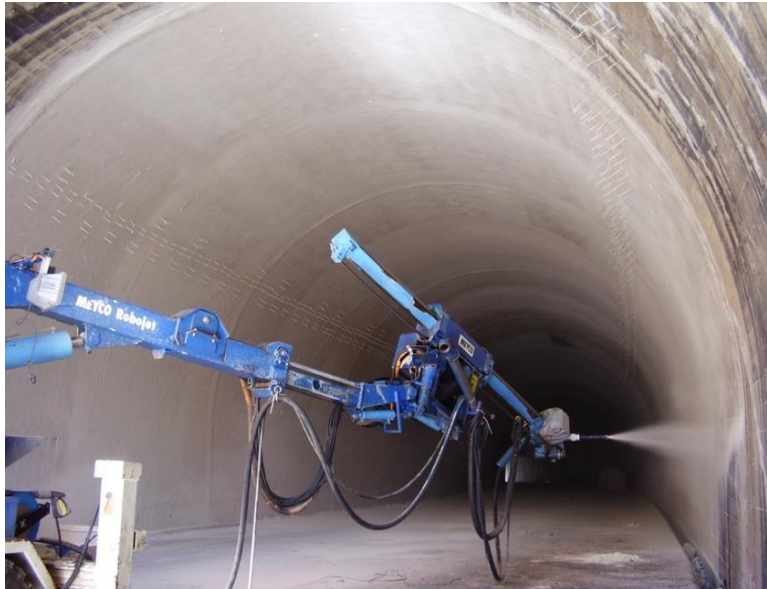
Εικόνα 3.11: Διαδικασία εκτόξευσης πυρίμαχου κονιάματος στην τελική επένδυση της σήραγγας [Δηλαβέρης,2004]
