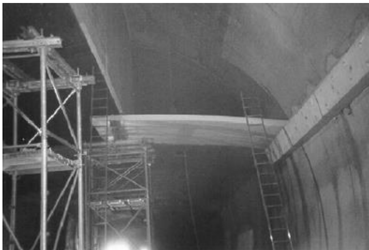
Εικόνα 3.31: Εγκατάσταση διαφορετικών προκατασκευασμένων τμημάτων σκυροδέματος [Αγγελόπουλος et al,2005].
