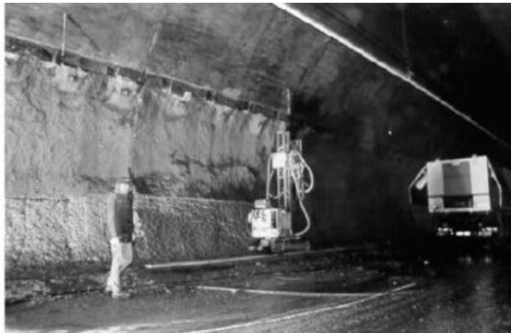
Εικόνα 3.26: Εργασίες για τον καθαρισμό της επιφάνειας του σκυροδέματος [Αγγελόπουλος et al,2005]
