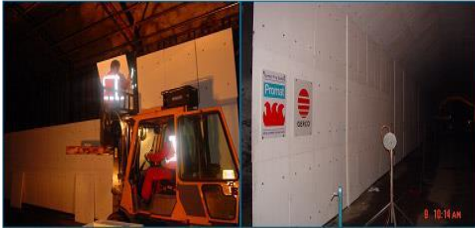
Εικόνα 3.15: Εφαρμογή πλακών πυροπροστασίας [www.promat-tunnel.com]
