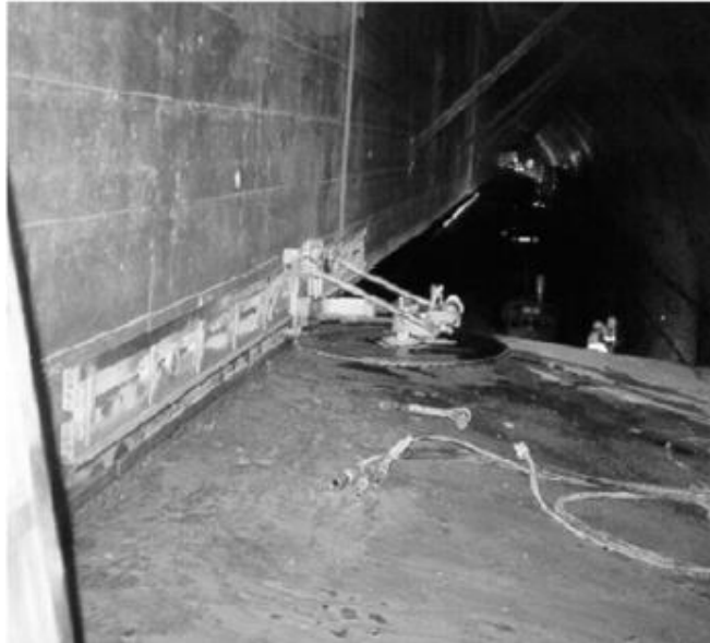
Εικόνα 3.25: Εργασίες για την αφαίρεση τμήματος της οροφής [Αγγελόπουλος et al,2005]
