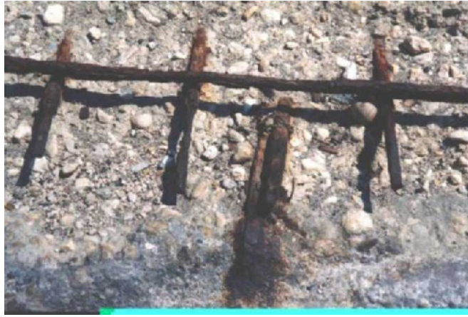
Εικόνα 1.6.1.1: Διάβρωση μεταλλικών αντικειμένων στο έδαφος
