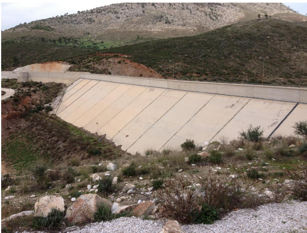
Σχήμα 2.11. Αντιπλημμυρικό Φράγμα Ραπεντώσας, Πηγή: Μπαμπάνης Αθανάσιος
