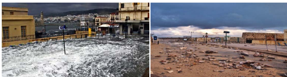
Εικόνα 4-12: Κατάκλυση θαλασσινού νερού λόγω κυματικής υπερπήδησης στην ευρύτερη περιοχή των λιμενικών εγκαταστάσεων και περιοχή αστοχίας του προσήνεμου μόλου.
