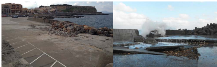
Εικόνα 4-11: Ζημιές στην βάση του προσήνεμου κυματοθραύστη (α) προηγούμενες ζημιές, φωτογραφία από την 4η Ιανουαρίου 2014, (β) νέες ζημιές μετά τις δομικές κατασκευές, φωτογραφία από την 14η Ιανουαρίου 2014.
