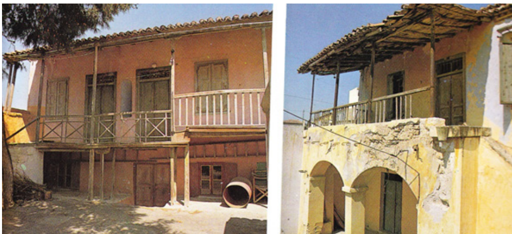
Αριστερά: Χαγιάτι στα Μέγαρα ενδιαφέρουσας ξυλοκατασκευής (Φιλιππίδης 1988, 223)
