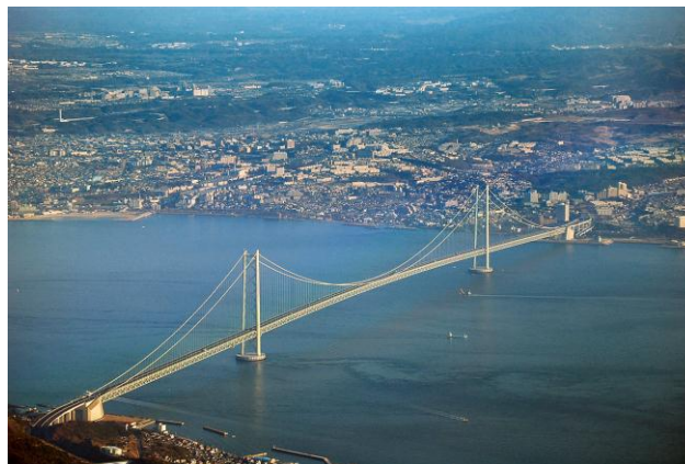
Σχήμα 6. Κρεμαστή γέφυρα Akashi Kaikyō στην Ιαπωνία (Wikipedia 3)
