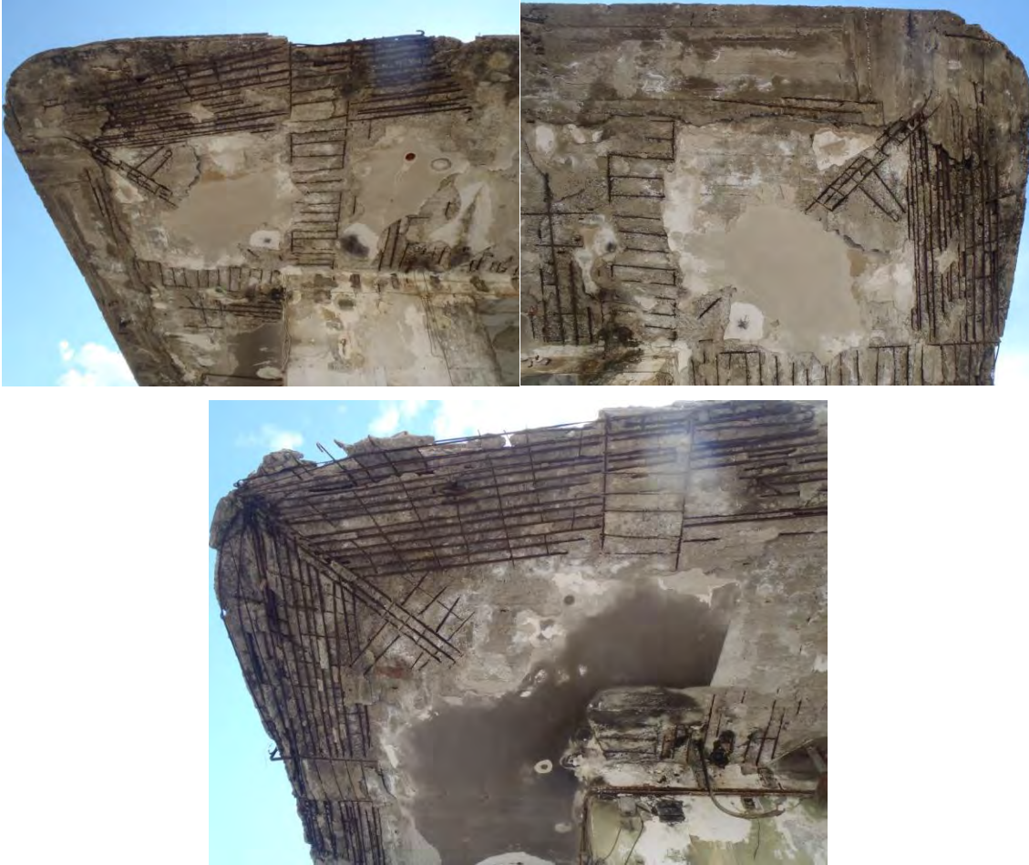
Σχήμα 3.38: Εκτεταμένες βλάβες στις γωνίες των προβόλων
