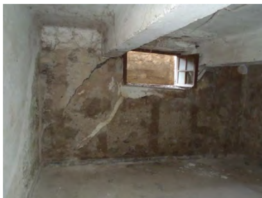
Σχήμα 3.48: Ρηγματώσεις στη λιθοδομή του υπογείου του καταστήματος ανατολικά της κεντρικής εισόδου
