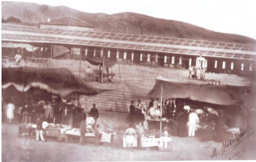
Σχήμα 2.42: Φωτογραφία της δημοτικής αγοράς από την πλατεία στα τέλη του 19 ου αι. Φαίνονται οι μαρμαρίνες σκάλες, η πτέρυγα της οδού Αρεθούσης και η τομή της με την πτέρυγα της Κριεζώτου και το κατεδαφισμένο συντριβάνι. 47
