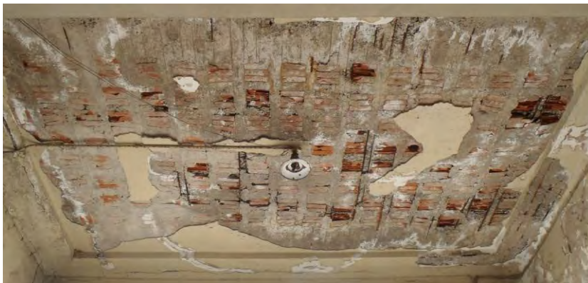
Σχήμα 3.40α: Οροφή ανατολικής εισόδου (πλάκα Zoellner)
