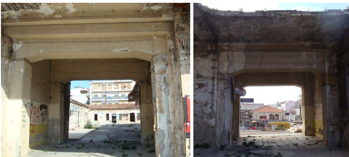
Σχήμα 3.43: Ανατολική είσοδος της δημοτικής αγοράς (όψη από την πλατεία – όψη από το εσωτερικό της αγοράς)
