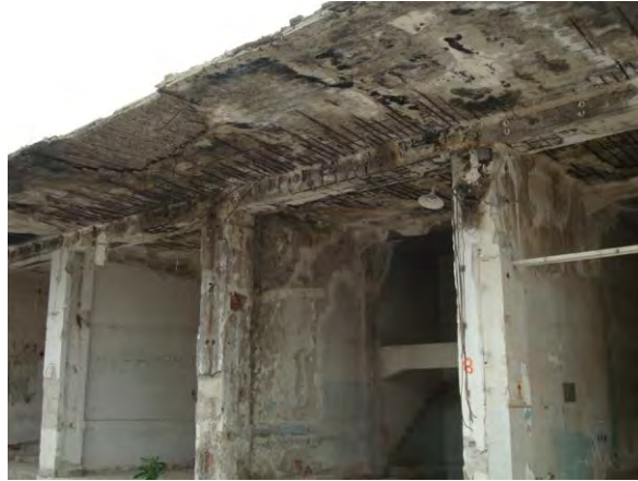
Σχήμα 3.36: Εκτεταμένες βλάβες στους περιμετρικούς προβόλους
