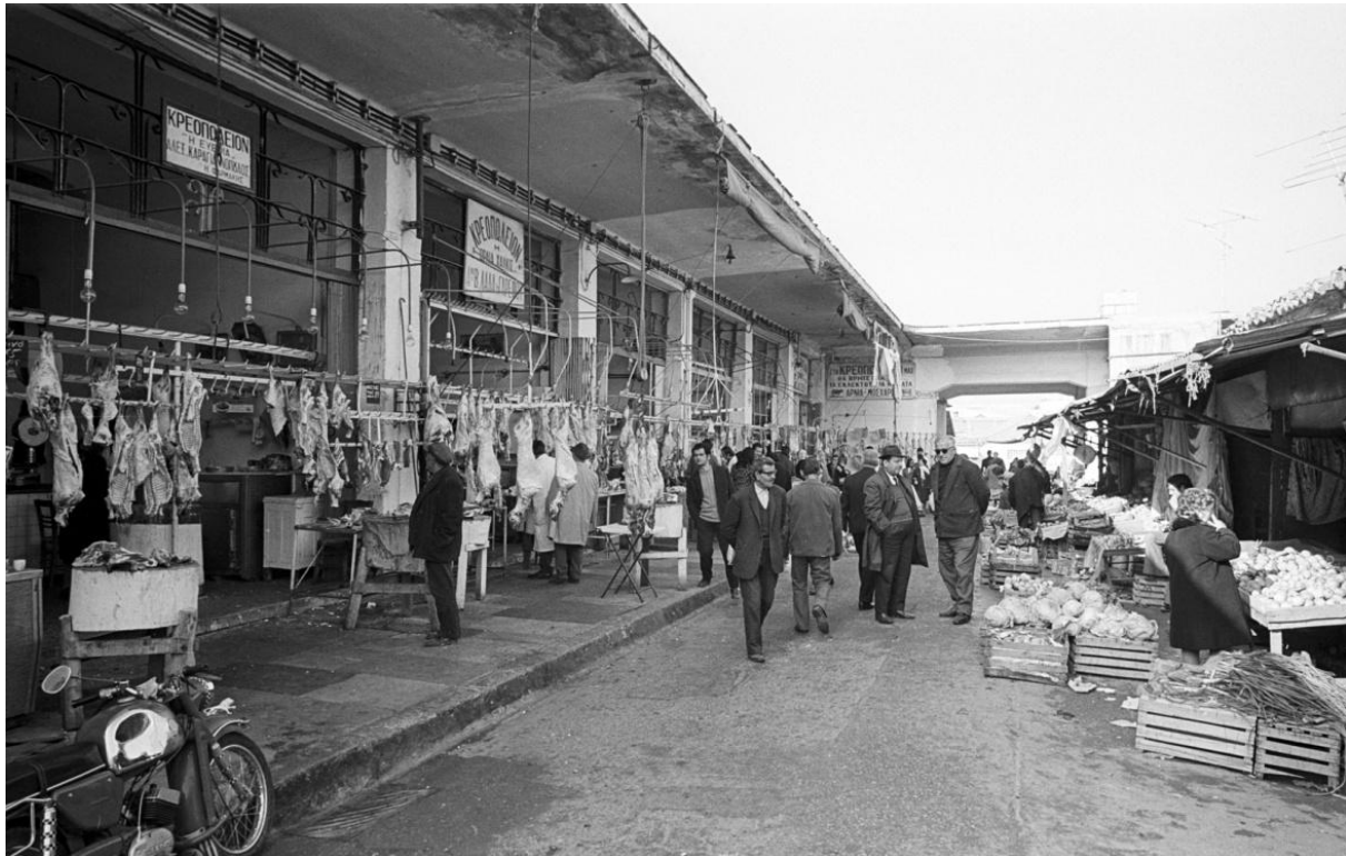
Σχήμα 2.53: Φωτογραφία του ανατολικού εσωτερικού διαδρόμου της δημοτικής αγοράς (1974-1975) 75
