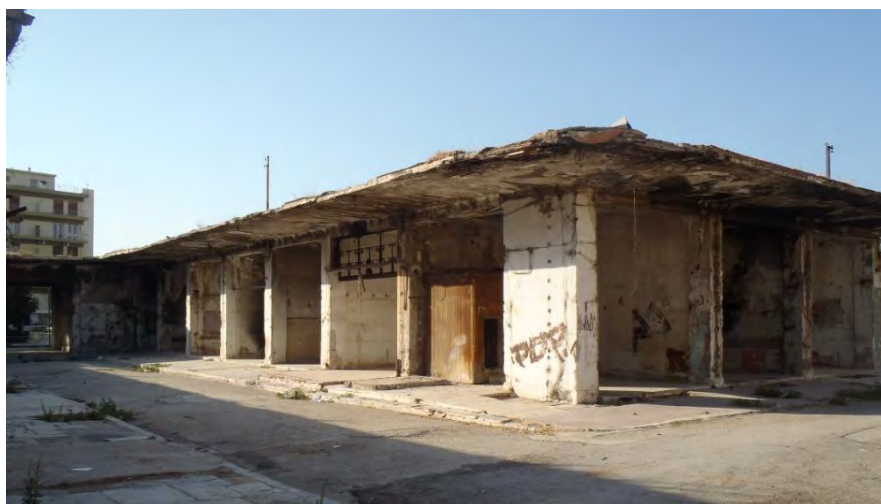
Σχήμα 3.6: Άποψη των εσωτερικών πτερυγών της β' φάσης της αγοράς. Εντυπωσιακοί οι περιμετρικοί πρόβολοι με το μεγάλο τους μήκος και το λεπτό τους πάχος
