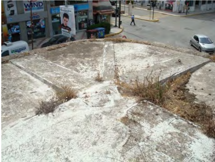
Σχήμα 3.33: Άποψη των ανεστραμμένων δοκών από πάνω στη γωνία προβόλου
