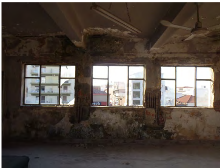
Σχήμα 3.12: Άποψη από το εσωτερικού του ορόφου. Υποστυλώματα οπλισμένου σκυροδέματος φέρουν τις δοκούς οπλισμένου σκυροδέματος της ορόφης
