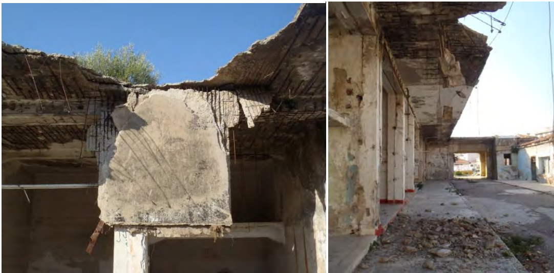
Σχήμα 3.37: Καταρρεύσεις προβόλων
