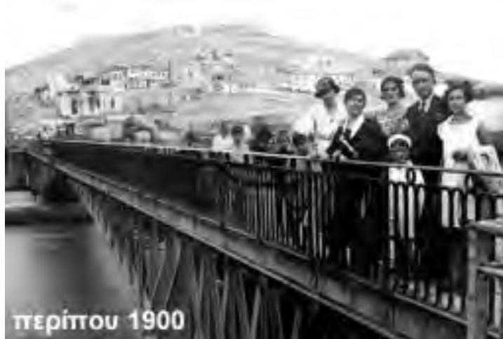
Σχήμα 2.24: Η νέα σιδερένια γέφυρα (αρχές του 20- αι.)
