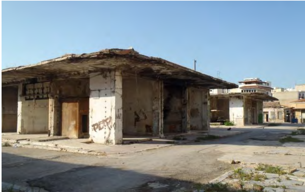
Σχήμα 2.69: Άποψη των εσωτερικών πτερύγων της β' φάσης της δημοτικής αγοράς
