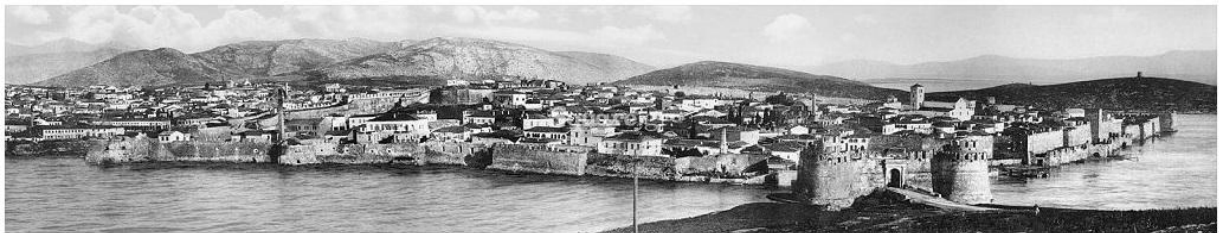
Σχήμα 2.22: Τμήμα πανοραμικής φωτογραφίας του Κάστρου της Χαλκίδας. Χρονολογείται μεταξύ των ετών 1884-1890. 32
