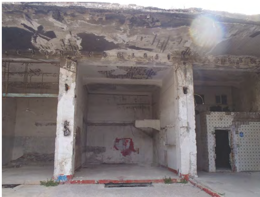
Σχήμα 3.14: Τροποποιήσεις σε καταστήματα (καθαίρεσεις παταριών, κατασκευή εσωτερικών χωρισμάτων)
