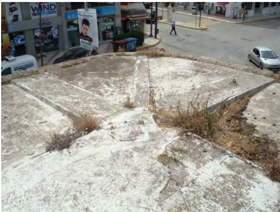
Σχήμα 2.70: Άποψη από πάνω των ανεστραμμένων δοκών στις γωνίες των προβόλων
