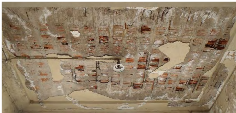
Σχήμα 2.71: Επιμελημένη κατασκευή πλακών οροφής
