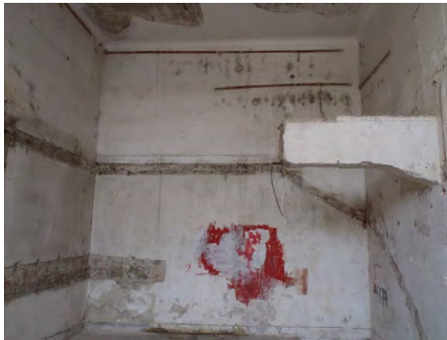
Σχημα 3.44: Καθαίρεσεις παταριών οπλισμένου σκυροδέματος
