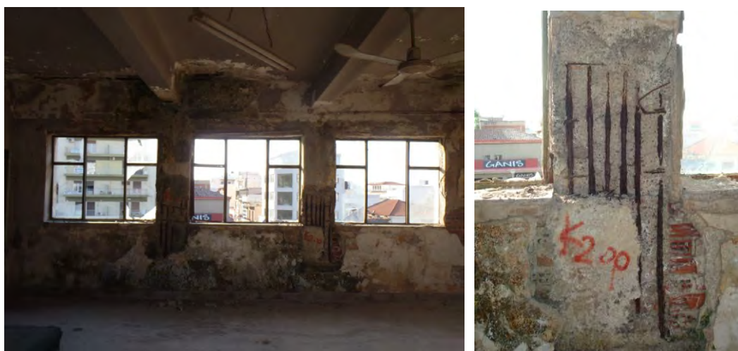
Σχήμα 3.44: Υποστυλώματα ορόφου βορινής πλευράς της μετωπικής πτέρυγας
