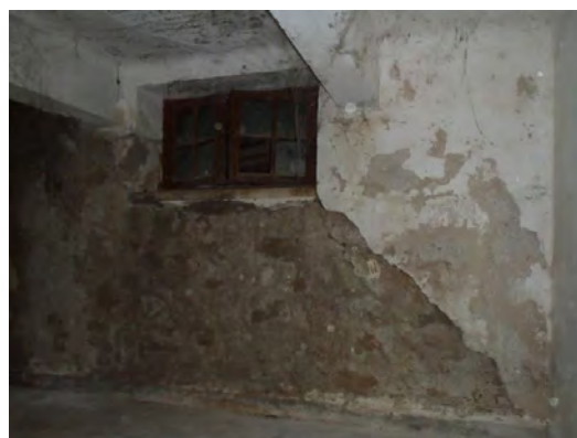
Σχήμα 3.49: Ρηγματώσεις στη λιθοδομή του υπογείου του καταστήματος δυτικά της κεντρικής εισόδου
