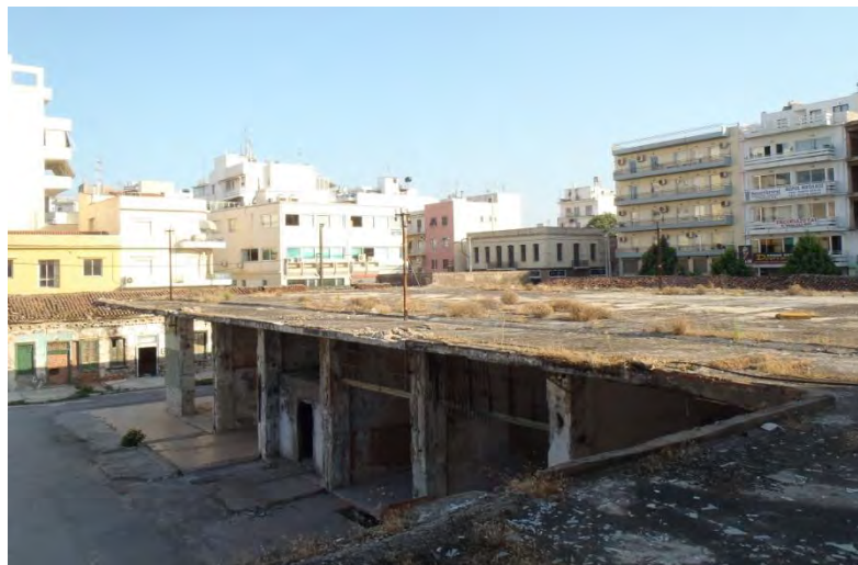
Σχήμα 3.46: Οροφή του ισογείου. Είναι εμφανής η βιολογική φθορά.
