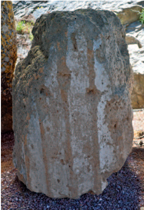
Εικ. 26. α. Σφόνδυλος κίονα της πρόστασης του ναού (Σ2). Διακρίνεται η επίχριση με κονίαμα λευκού χρώματος. β. Η άνω επιφάνεια του σφονδύλου, με την εγκοπή για τοποθέτηση εμπολίου.
