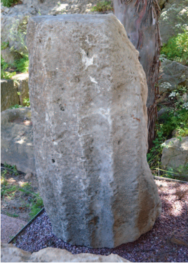
Εικ. 25. α. Σφόνδυλος κίονα της πρόστασης του ναού (Σ1). β. Η άνω επιφάνεια του σφονδύλου, με την εγκοπή για τοποθέτηση εμπολίου.
