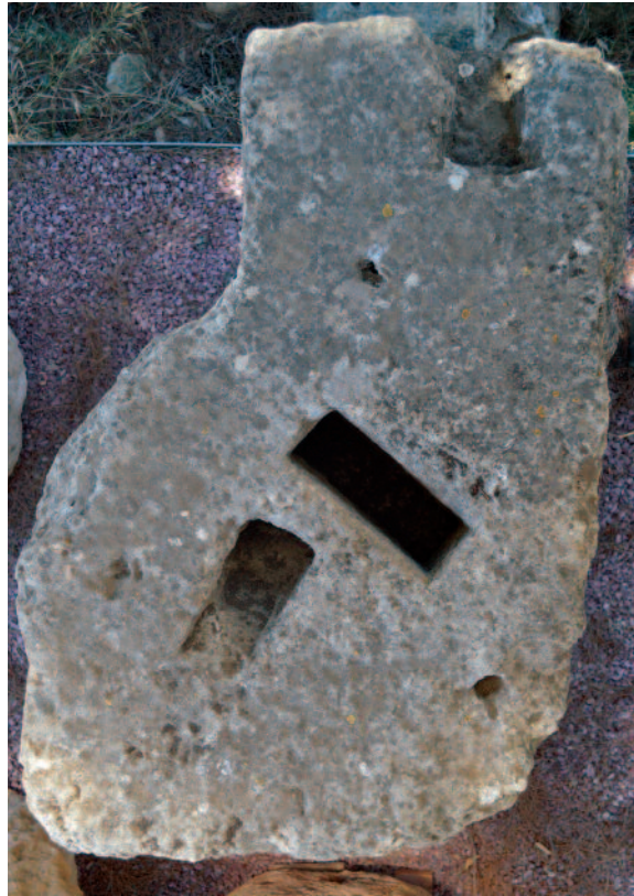
Εικ.28. α. Γωνιακό τρίγλυφο του ναού. β. Η άνω επιφάνεια του τριγλύφου με εγκοπές για τοποθέτηση πελεκίνου (πάνω), λύκου, καρκίνου (κέντρο) και μοχλού (κάτω δεξιά).
