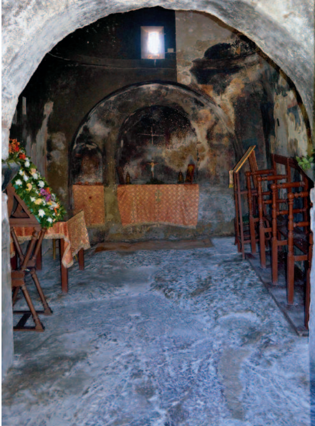
Εικ. 16. Το εσωτερικό της εκκλησίας του Αγίου Γεωργίου. Στο έδαφος διακρίνονται οι αυλακώσεις για την έδραση του αρχαίου κτηρίου.
