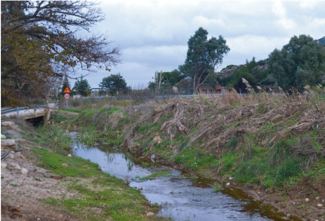
Εικ. 33. Η κοίτη του Ερασίνου στα δυτικά του αρχαιολογικού χώρου και η κατασκευασμένη το 1979 γέφυρα για τη διέλευση της οδού Βραυρώνας.
