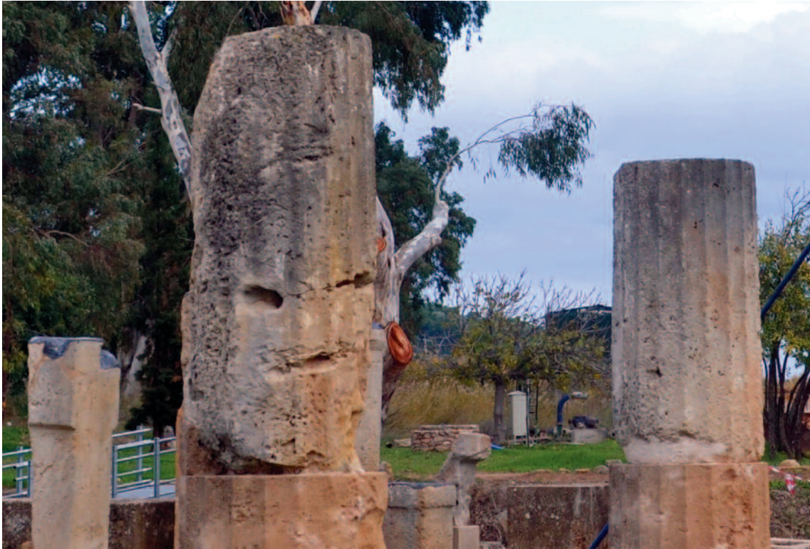
Εικ. 34. Κοιλότητες στην επιφάνεια κίονα της στοάς, λόγω τριχοειδούς αναρρίχησης των αλάτων.
