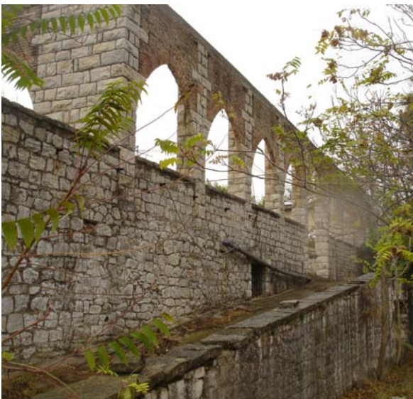
εικ. 47 : άποψη ράμπας ανόδου στον όροφο
