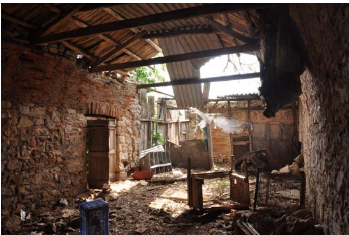
εικ.104, 105 : Ξύλινη στέγη που στηρίχθηκε στις γενέσεις του θόλου
