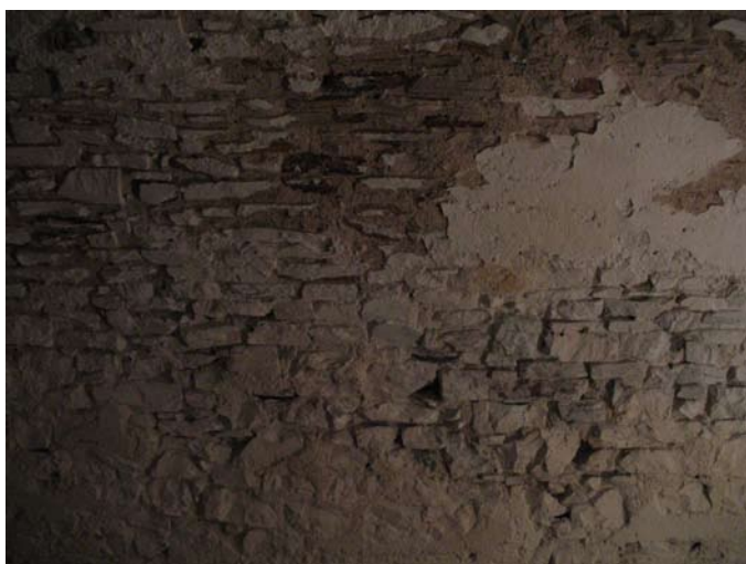
εικ.94, 95 : απόπλυση κονιάματος και στερεώσεις με τσιμέντο στους θόλους των στοών
