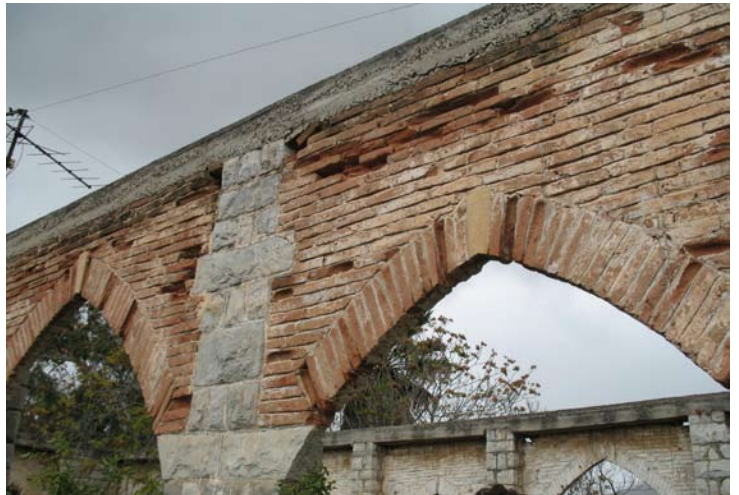
εικ.80, 81: χαρακτηριστικές φθορές στα τόξα του ορόφου και τα τύμπανα από πλίνθους. Απώλεια μάζας λόγω κρυστάλλωσης αλάτων στο εσωτερικό τους
