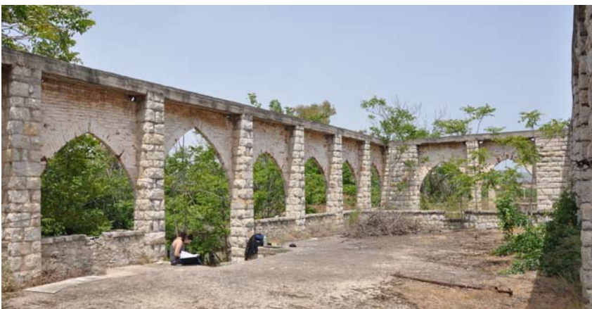
εικ. 49 : το κτίσμα του ορόφου από το εσωτερικό του
