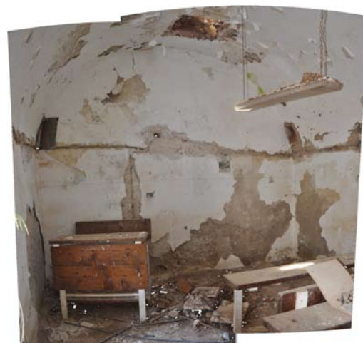
εικ. 62 : εσωτερικό του κτιρίου κ2 στην περιοχή κάτω από τις δύο καμινάδες. Υποθέτουμε πως χάλκινα καζάνια στη θέση αυτή εξυπηρετούσαν τη διπλή απόσταξη του κρασιού για να γίνει κονιάκ
