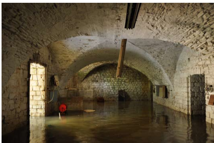
εικ. 76, 77: εισροή υδάτων ύψους 55εκ. στον προθάλαμο των στοών και τις στοές
