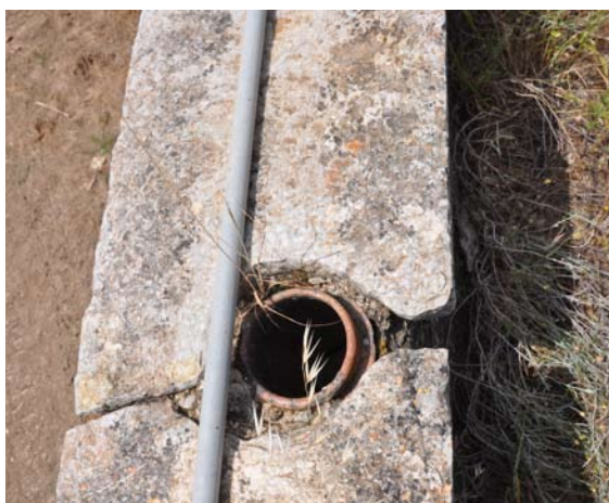
εικ. 41 (αριστερά) : η εστία του νοτιοδυτικού διαμερίσματος εικ. 42, 43(επάνω) : ο πήλινος καπναγωγός που διατρύπει το στηθαίο του δώματος εικ. 44 (κάτω): η πεσσοστοιχία παό το δώμα
