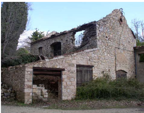
εικ. 70: το οινοποιείο των κτημάτων στο Τατόι. Πίσω από το χαμηλό κτίσμα βρίσκεται η ράμπα ανόδου στον όροφο (πηγή http://greekarchitects.gr/ )
