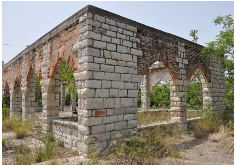
εικ. 48 (δεξιά) : το κτίσμα του ορόφου από το δώμα
