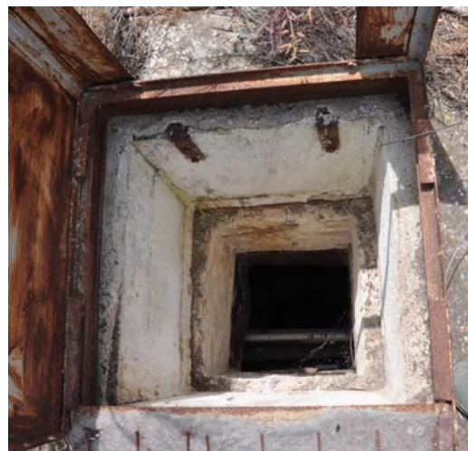
εικ. 51: το δώμα με τις νέες κατασκευές επί των ανοιγμάτων εξαερισμού / εικ. 52 : άνοιγμα εξαερισμού στο πάτωμα του δώματος
