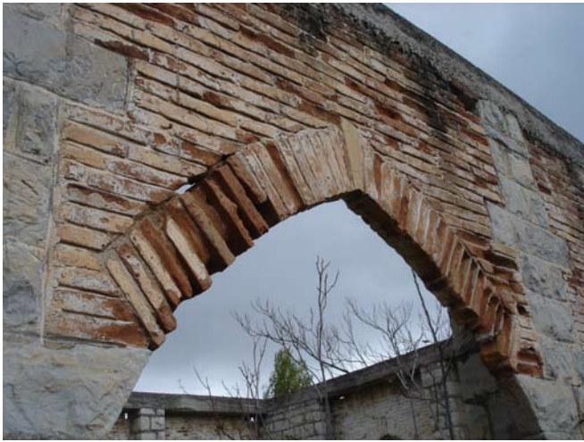
εικ.80, 81: χαρακτηριστικές φθορές στα τόξα του ορόφου και τα τύμπανα από πλίνθους. Απώλεια μάζας λόγω κρυστάλλωσης αλάτων στο εσωτερικό τους
