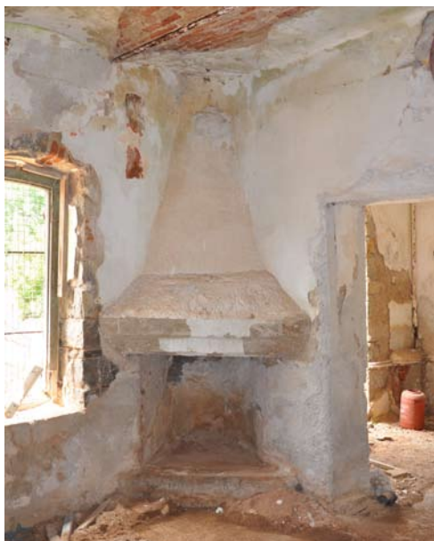
εικ. 41 (αριστερά) : η εστία του νοτιοδυτικού διαμερίσματος εικ. 42, 43(επάνω) : ο πήλινος καπναγωγός που διατρύπει το στηθαίο του δώματος εικ. 44 (κάτω): η πεσσοστοιχία παό το δώμα
