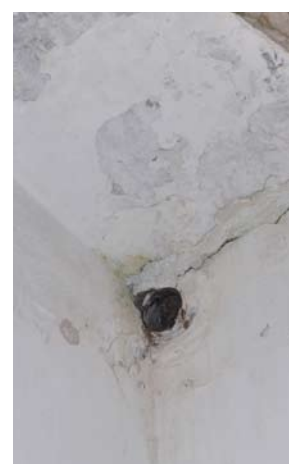
εικ. 41 (αριστερά) : η εστία του νοτιοδυτικού διαμερίσματος εικ. 42, 43(επάνω) : ο πήλινος καπναγωγός που διατρύπει το στηθαίο του δώματος εικ. 44 (κάτω): η πεσσοστοιχία παό το δώμα
