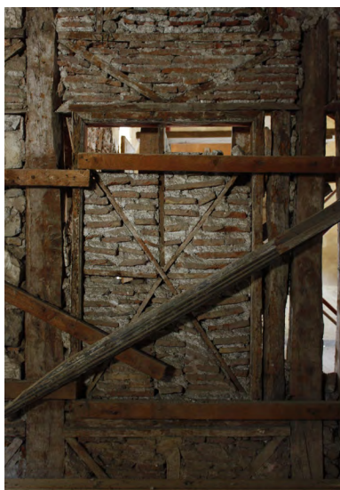
εικ.102-104, λεπτομέρειες κατασκευής ξυλόπηκτου τοίχου ανατολικού οντά
