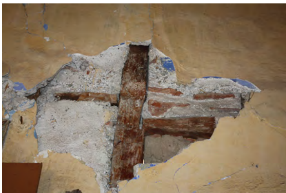
εικ.237-241, στοιχεία παθολογίας του χώρου του σοφά
