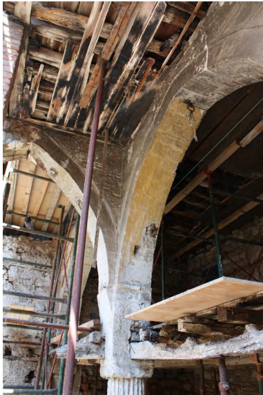
εικ.171-176, κατασκευή της τοξοστοιχίας
