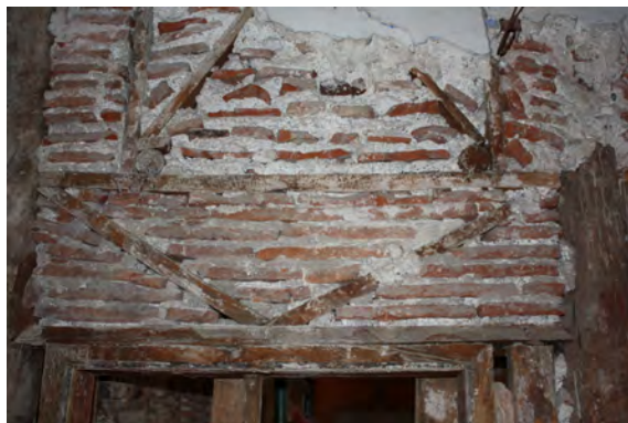
εικ.132-140, λεπτομέρειες κατασκευής σκελετού και πλήρωσης ξυλόπηκτων τοίχων
