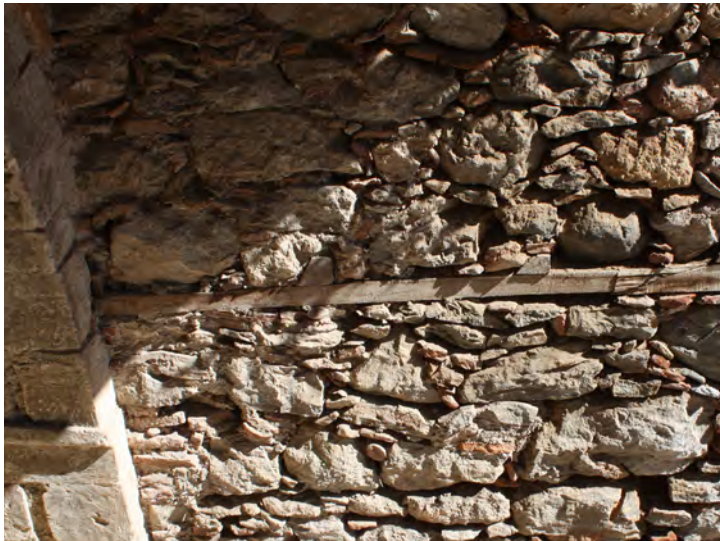
εικ.127-131, είδη τοιχοποιιών και ξυλοδεσιών στο Αρχοντικό
