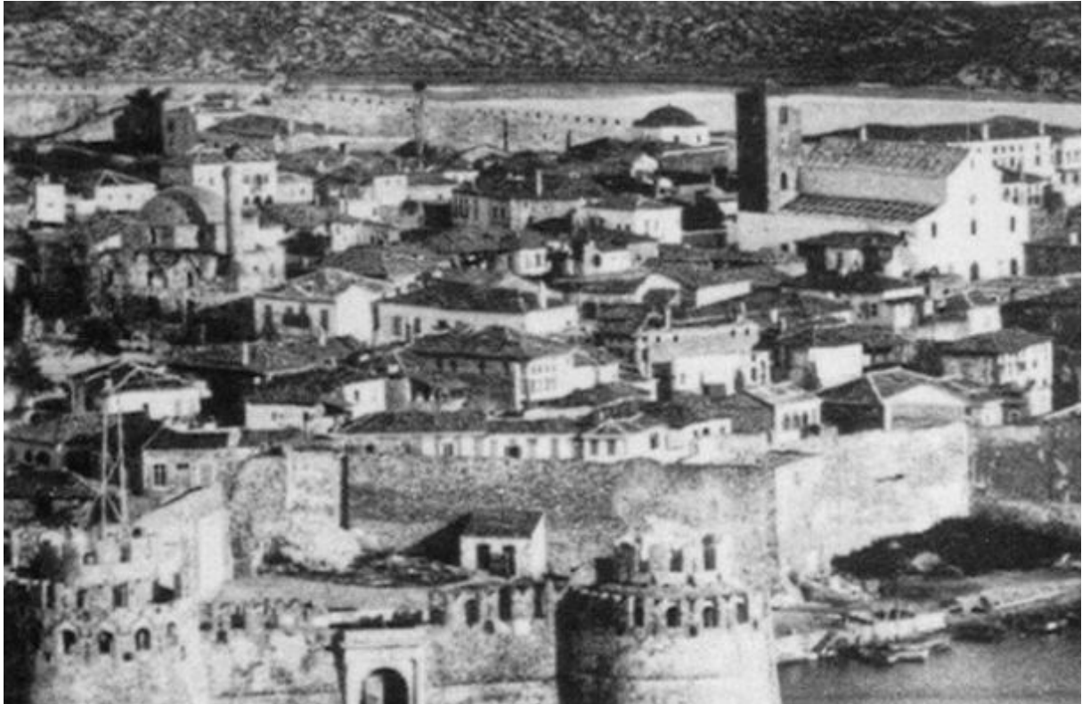
εικ.198, λεπτομέρεια από φωτογραφία του Κάστρου, στην οποία διακρίνεται η δυτική πλευρά του Αρχοντικού. Διατηρεί το σαχνισί και την αυθεντική διάταξη των ανοιγμάτων, (1859-1870)
