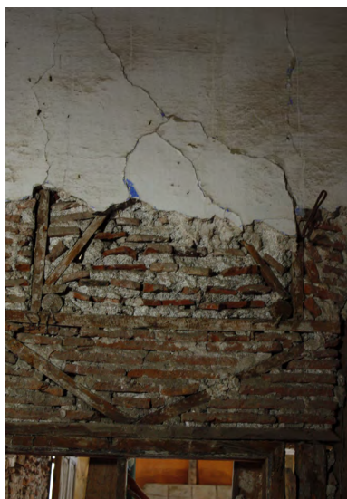
εικ.102-104, λεπτομέρειες κατασκευής ξυλόπηκτου τοίχου ανατολικού οντά
