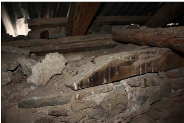
εικ.141, ο στρωτήρας στο βόρειο τοίχο
