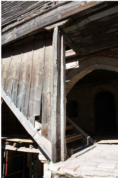
εικ.77-79, η κατασκευή της σκάλας
