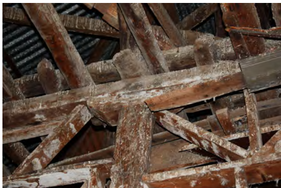
εικ.132-140, λεπτομέρειες κατασκευής σκελετού και πλήρωσης ξυλόπηκτων τοίχων
