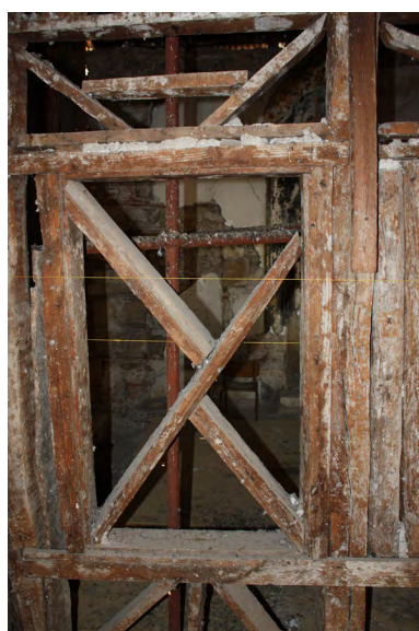
εικ.112-115, κατασκευή ξυλόπηκτου τοίχου δυτικού οντά
