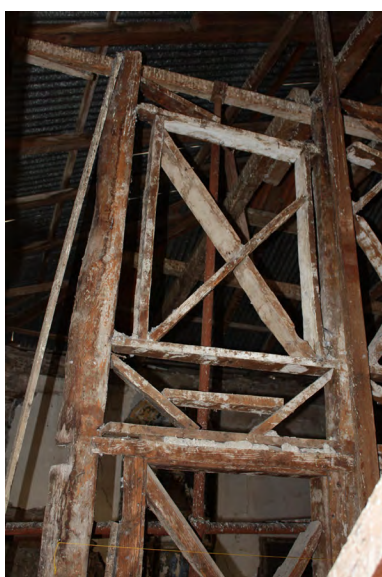
εικ.112-115, κατασκευή ξυλόπηκτου τοίχου δυτικού οντά
