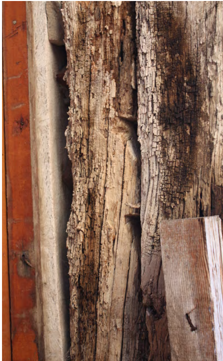
εικ.177, παλιό τμήμα ξύλου σε δεύτερη χρήση στο πρέμι της αυλόπορτας
