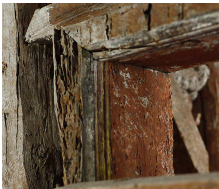
εικ.106, Αποκάλυψη χρωματισμών του κουφώματος στον ανατολικό οντά
