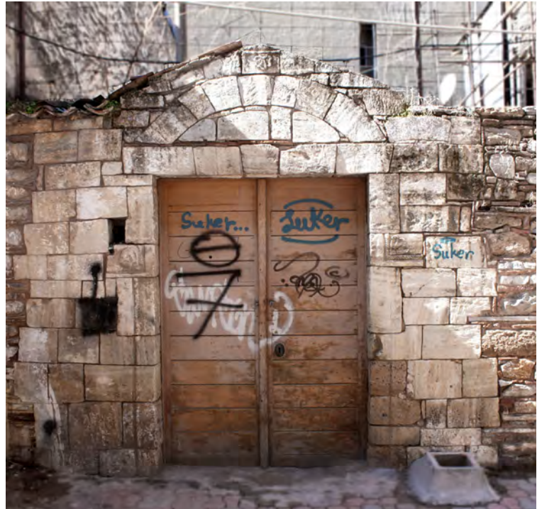
εικ.177, παλιό τμήμα ξύλου σε δεύτερη χρήση στο πρέμι της αυλόπορτας
