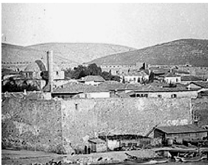
εικ.201, Λεπτομέρεια των θαλάσσιων τειχών της πόλης. Διακρίνεται το Αρχοντικό και οι βοηθητικοί του χώροι. Εντύπωση προκαλεί η καμινάδα που εμφανίζεται.
