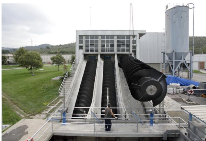
Εικόνα 5.4.1 Τρεις παράλληλοι κοχλίες στην Ισπανία το 2011 (φωτ. Archimedes Hydro Screw, www.flickr.com )
