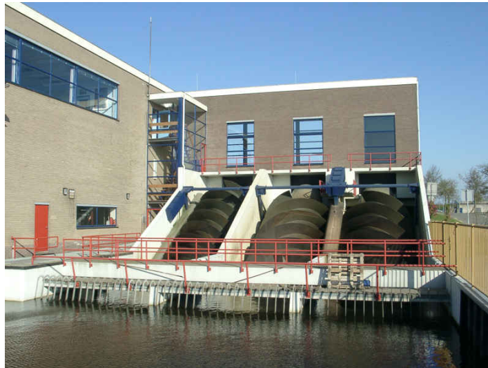
Εικόνα 5.4.2 Κοχλίες στο Kinderdijk της Ολλανδίας (κατ. 1972) αντικαθιστούν 19 αποστραγγιστικούς ανεμόμυλους του 1740 για άντληση 81000 \text{ m}^3/\text{h} ( www.math.nyu.edu )
