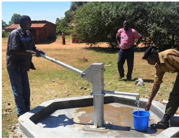
Εικόνα 5.4.4 Παλινδρομική αντλία στην Κένυα το 2012 ( www.thewaterproject.org )
