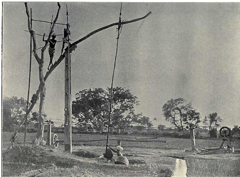
Εικόνα 4.2.2 Picottah με αντίβαρο δύο άτομα στην Ινδία (Slater, 1918)
