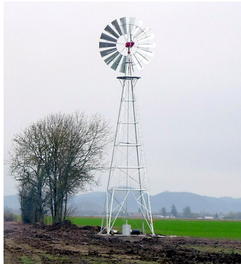
Εικόνα 5.4.10 Αποστραγγιστικός ανεμόμυλος αμερικάνικου τύπου, παροχής 80 m 3 /h στο Oregon των Η.Π.Α (φωτ. Thomas Conlon, Iron Man Windmill Co)
