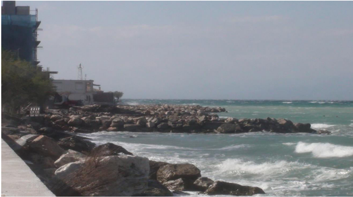
ΦΩΤΟ 2.5: ΘΩΡΑΚΙΣΗ ΜΕ ΟΓΚΟΛΙΘΟΥΣ
