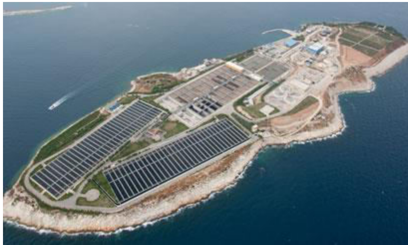
ΦΩΤΟ 1.6: ΕΓΚΑΤΑΣΤΑΣΗ ΕΠΕΞΕΡΓΑΣΙΑΣ ΑΠΟΒΛΗΤΩΝ
