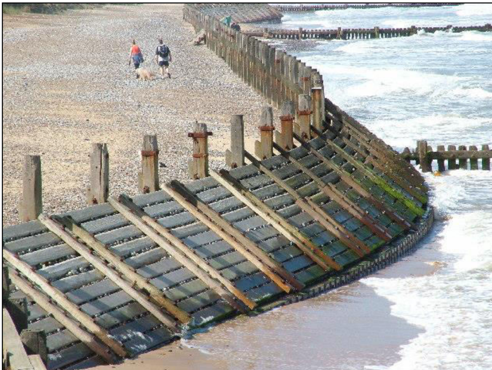
ΦΩΤΟ 2.8: ΤΥΠΙΚΗ ΔΙΑΤΟΜΗ REVETMENTS
