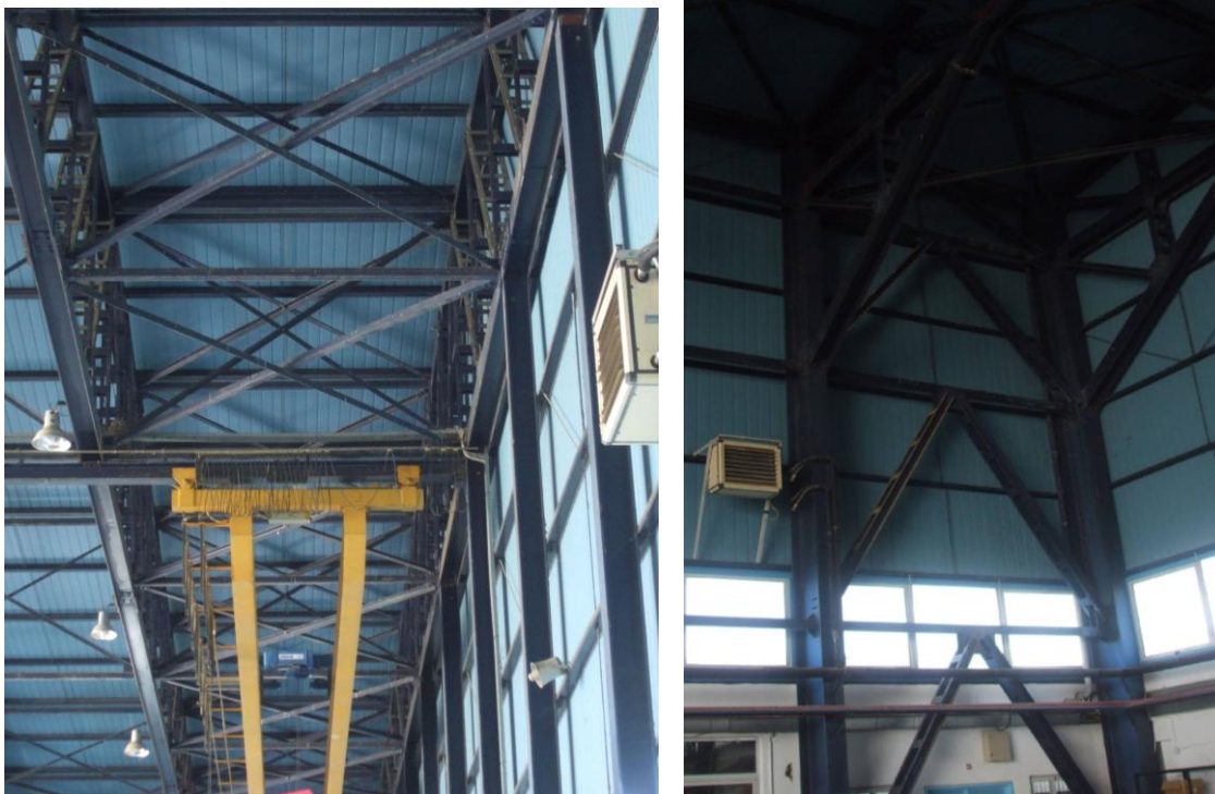
Φωτογραφίες 2.1 & 2.2: Οριζόντιοι και κατακόρυφοι σύνδεσμοι δυσκαμψίας
