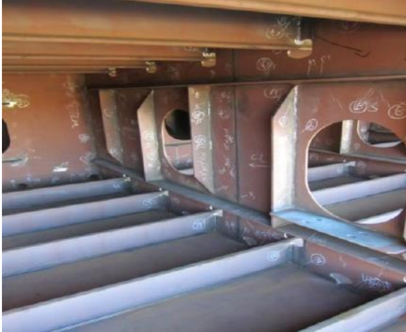
Εικόνα 4: Προετοιμασία επιφάνειας δεξαμενής έρματος [22]
