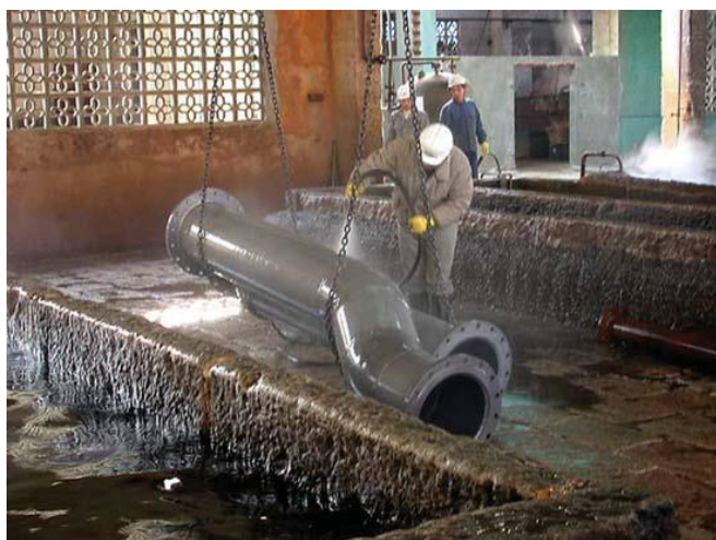
Εικόνα 6: Σωλήνες κατά τον καθαρισμό με εμβάπτιση σε οξέα [23]
