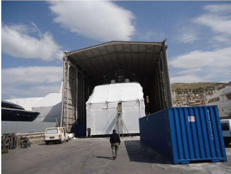
Εικόνα 8: Θαλαμηγός προ της εφαρμογής επιστρωμάτων, καλυμμένη με nylon και εντός υποστέγου, σε ναυπηγείο του Περάματος [φωτ. προσωπικού αρχείου]
