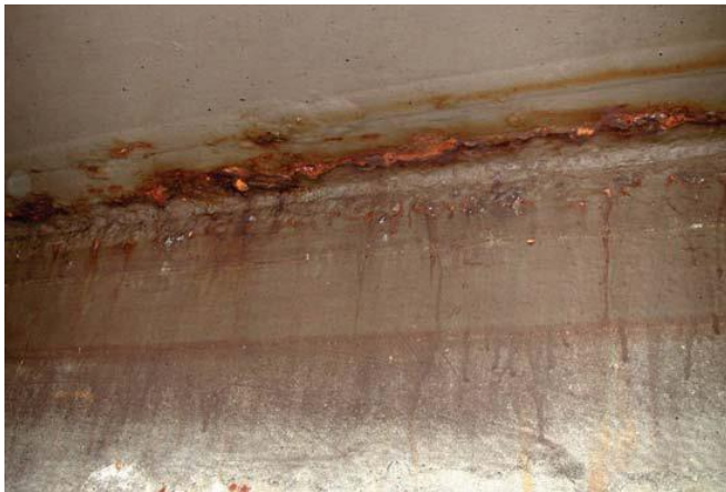
Εικόνα 35: Διάβρωση γύρω από συγκόλληση [23]
