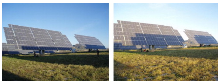
ΣΧΗΜΑ 3.1: Περιπτώσεις μερικής σκίασης προκαλούμενης από τμήμα της ίδιας εγκατάστασης. [4]
