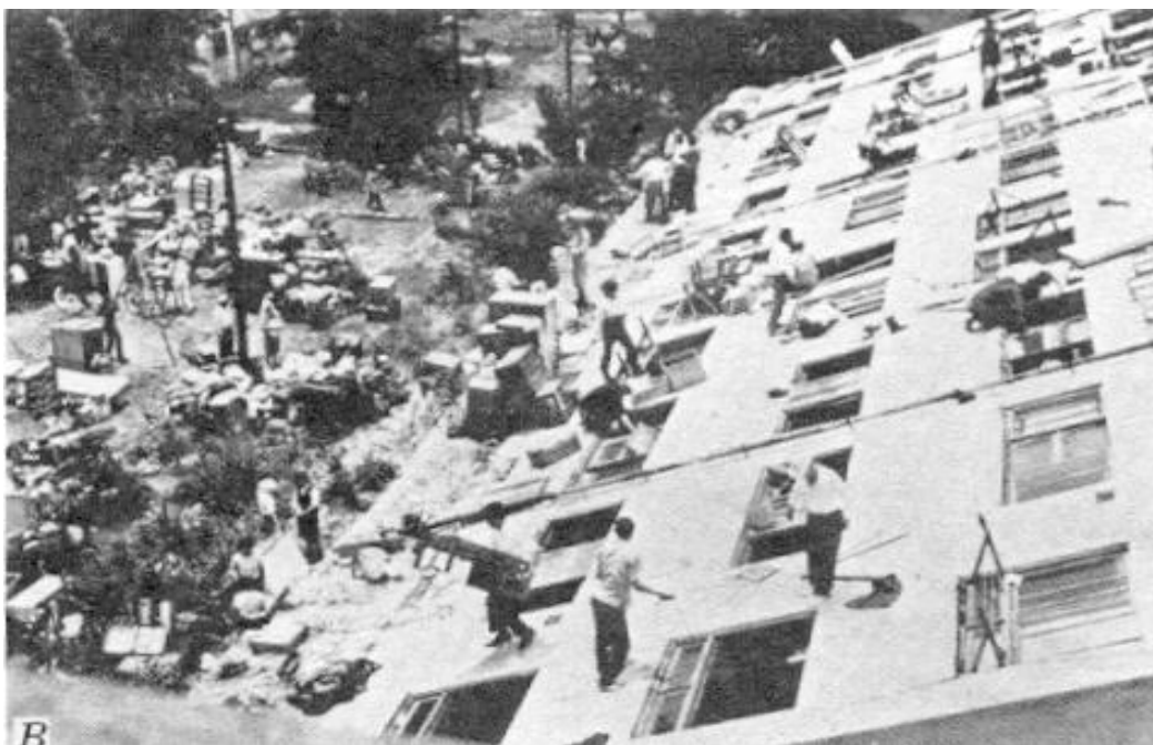
Εικόνα 2.10. Ένοικοι βρίσκουν οδό διαφυγής από τα κεκλιμένα – σχεδόν οριζοντιοποιημένα – κτίρια από την πρόσοψη αυτών. Πολλά από τα κτίρια στη συνέχεια επαναανυψώθηκαν και επαναλειτούργησαν
