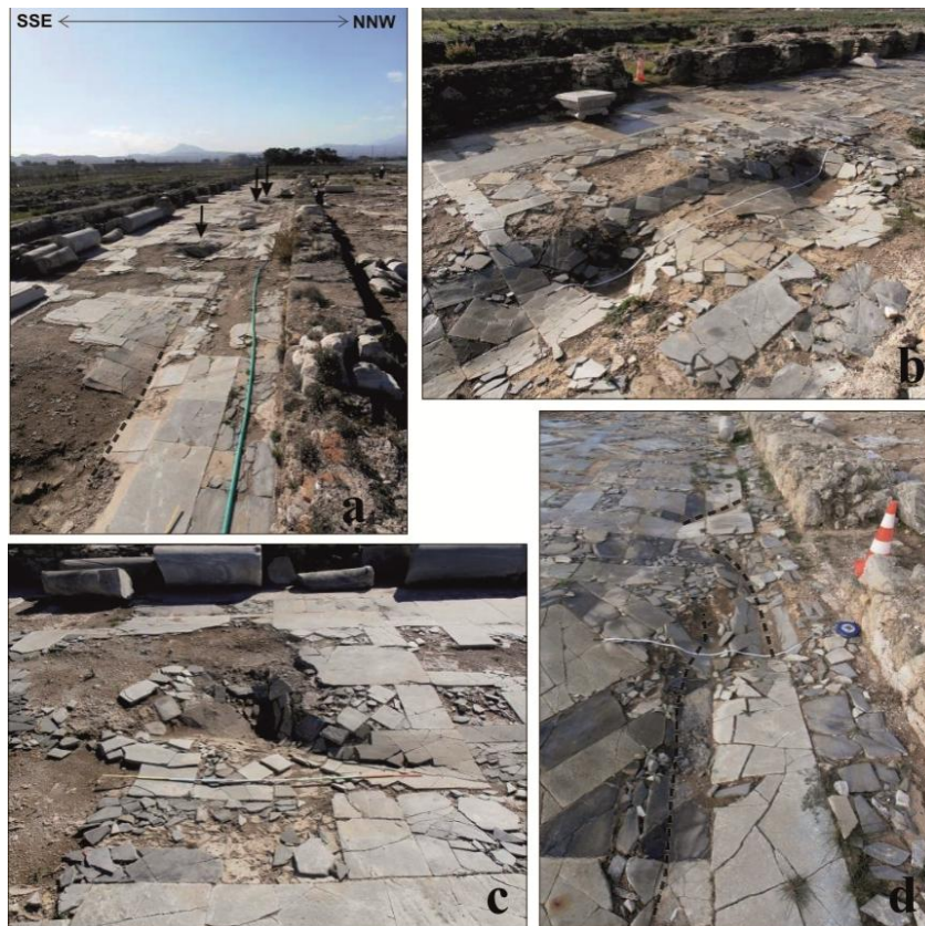
Εικόνα 3.6. Εκδηλώσεις του φαινομένου της ρευστοποίησης στο δάπεδο της Βασιλικής, όπου πραγματοποιήθηκαν οι μετρήσεις. Παρατηρούνται κυκλικές (b και c) και γραμμικές (d) αστοχίες.
