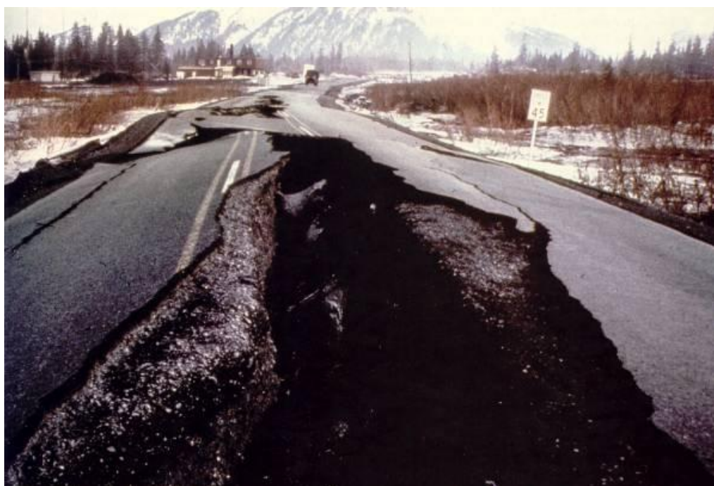
Εικόνα 2.14. Ο αυτοκινητόδρομος Seward που συνδέει την πόλη Anchorage με τη χερσόνησο Kenai στα νοτιοδυτικά, υπέστη δραματικές παραμορφώσεις εξαιτίας του σεισμού του 1964.
