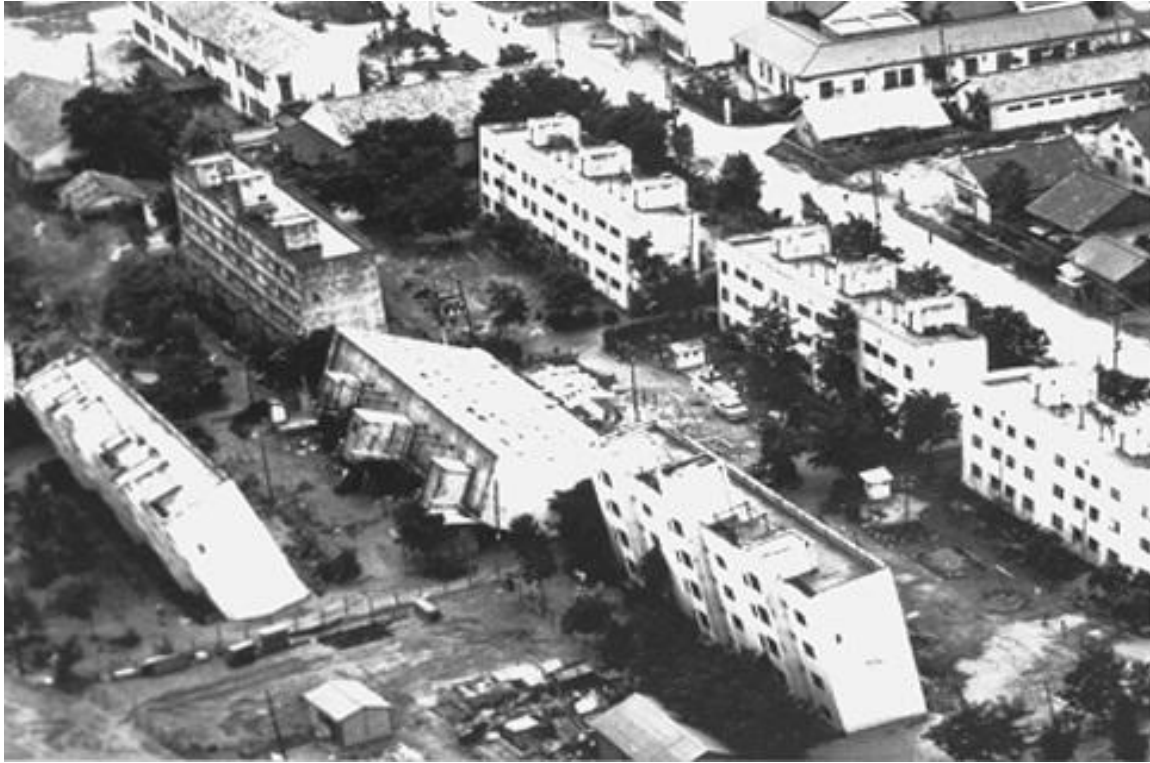
Εικόνα 2.8. Ανατροπή πολυκατοικιών λόγω ρευστοποίησης των υποκείμενων εδαφικών σχηματισμών (Σεισμική δόνηση μεγέθους Ms 7.5 στη Niigata, Ιαπωνία, το 1964)
