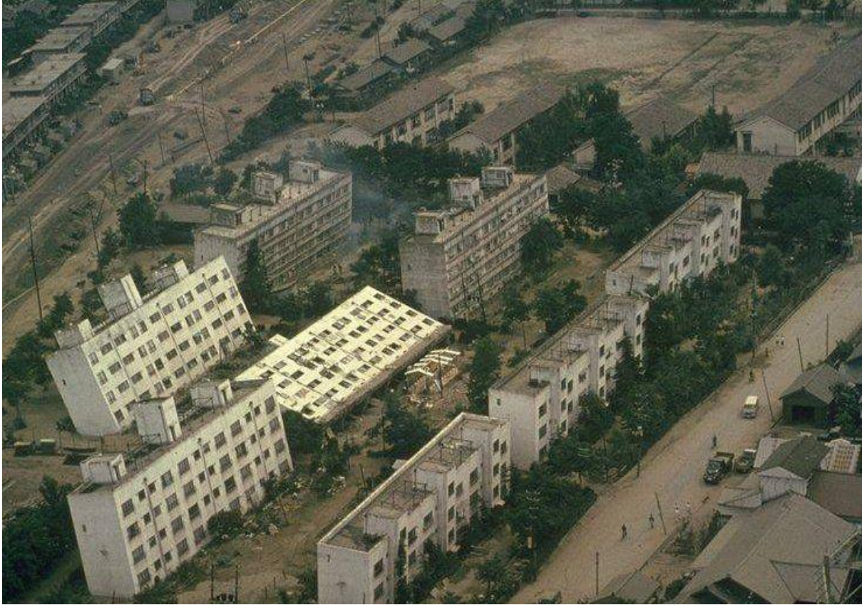
Εικόνα 2.7. Ανατροπή πολυκατοικιών στην πόλη Niigata της Ιαπωνίας λόγω σεισμικής δόνησης μεγέθους Ms 7.5 που προκάλεσε το φαινόμενο της ρευστοποίησης
