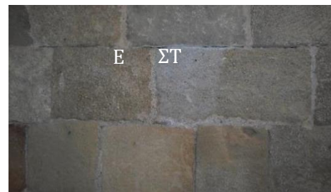
Εικ.9.8β. Ανοιχτόχρωμος πωρόλιθος - Η τοιχοποιία μετά το πέρας 3 μηνών από την εφαρμογή (Ε)B005, (ΣΤ)PMC1:1
