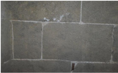
Εικ.9.8α. Γκρίζος πωρόλιθος - Η τοιχοποιία πριν την εφαρμογή
