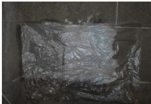
Εικόνα 9.5. Στιγμιότυπα από τον ξενώνα της Αγίας Αικατερίνης κατά την επί τόπου εφαρμογή των στερεωτικών υλικών στον γκρίζο πωρόλιθο
