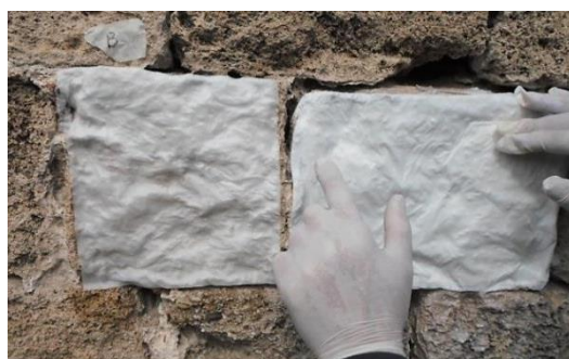
Εικόνα 9.4. Στιγμιότυπα από την είσοδο της τάφρου κατά την επί τόπου εφαρμογή των στερεωτικών υλικών
