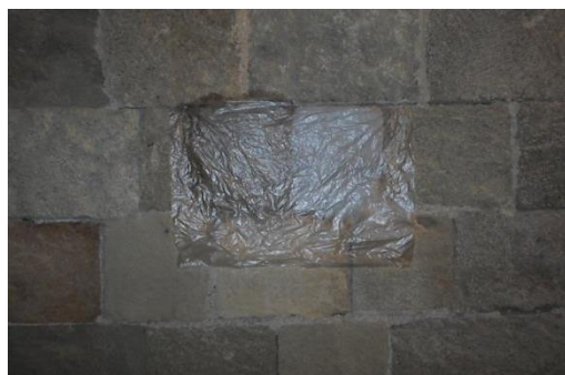
Εικόνα 9.6. Στιγμιότυπα από τον ξενώνα της Αγίας Αικατερίνης κατά την επί τόπου εφαρμογή των στερεωτικών υλικών στον ανοιχτόχρωμο πωρόλιθο
