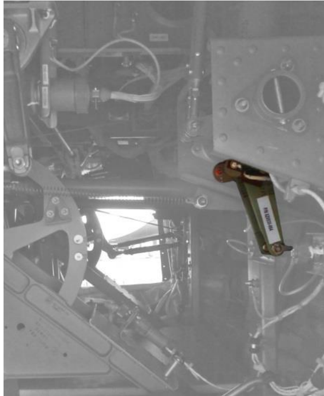
Εικόνα 5.7. Το σημείο τοποθέτησης των χαλύβδινων δακτυλίων
