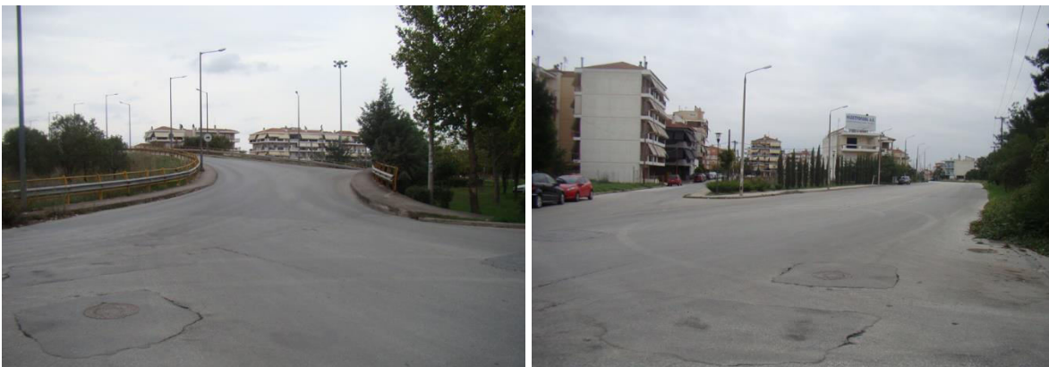
Εικόνα 5.40. Η κατάληξη της Θεοφράστου σε αερογέφυρα όπου μετέπειτα συνδέεται με την Καρδίτσης
