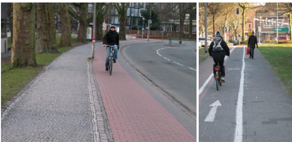
Εικόνα 4.3. Ποδηλατόδρομοι στο επίπεδο του πεζοδρομίου: πλακόστρωτος (δεξιά) και με λευκή διαγράμμιση (αριστερά) (Πηγή: VEP, Münster, 2025)
