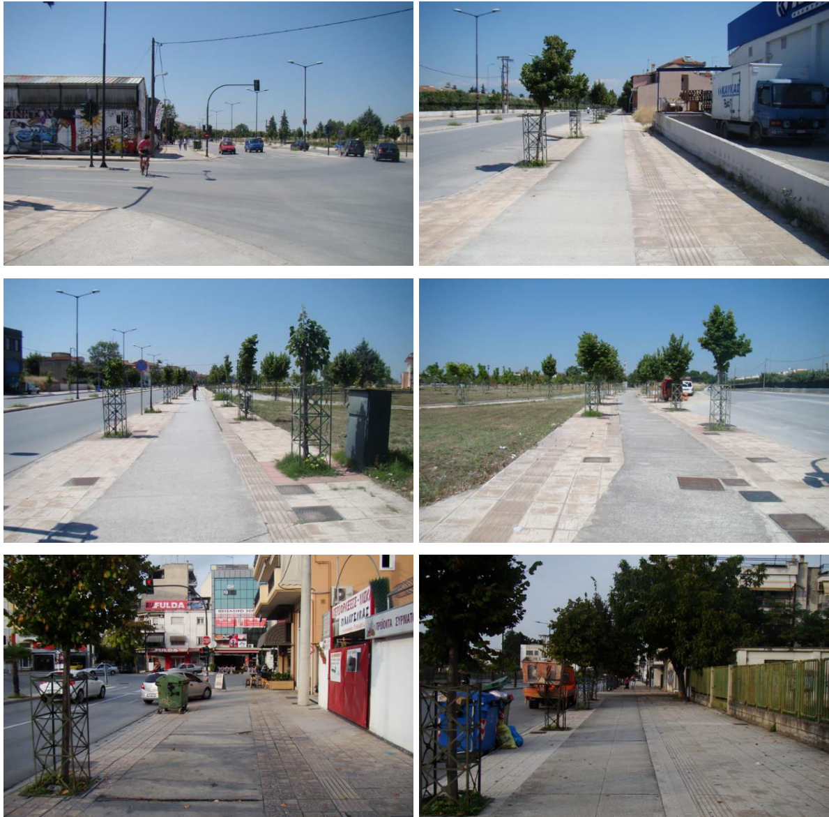
Εικόνα 5.12. Πάνω: Η διαμόρφωση των ποδηλατόδρομων στη διασταύρωση Σαρίμβη με την τάφρο Χατζηχαλάρ. Μέση: Η διαμόρφωση κατά μήκος του πάρκου Χατζηχαλάρ Κάτω: Απόψεις της οδού Σαρίμβη
