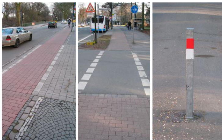
Εικόνα 4.17. Διαγράμμισεις ποδηλατοδρόμων (αριστερά και κέντρο) και πάσσαλος σήμανσης (δεξιά) (Πηγή: VEP, Münster, 2025)
