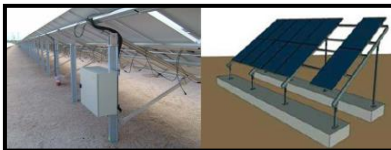
Εικόνα 3.28: Εδαφόμεψη βάσεων (αριστερά) και σκυροδέτηση σε δοκάρι (δεξιά) Πηγή: TEE TMK [1]
