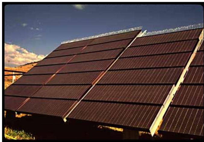
Εικόνα 3.13: Φωτοβολταϊκό πάρκο με πανέλα καδμίου-τελλουρίου Πηγή: http://ee.utep.edu/ [37]
