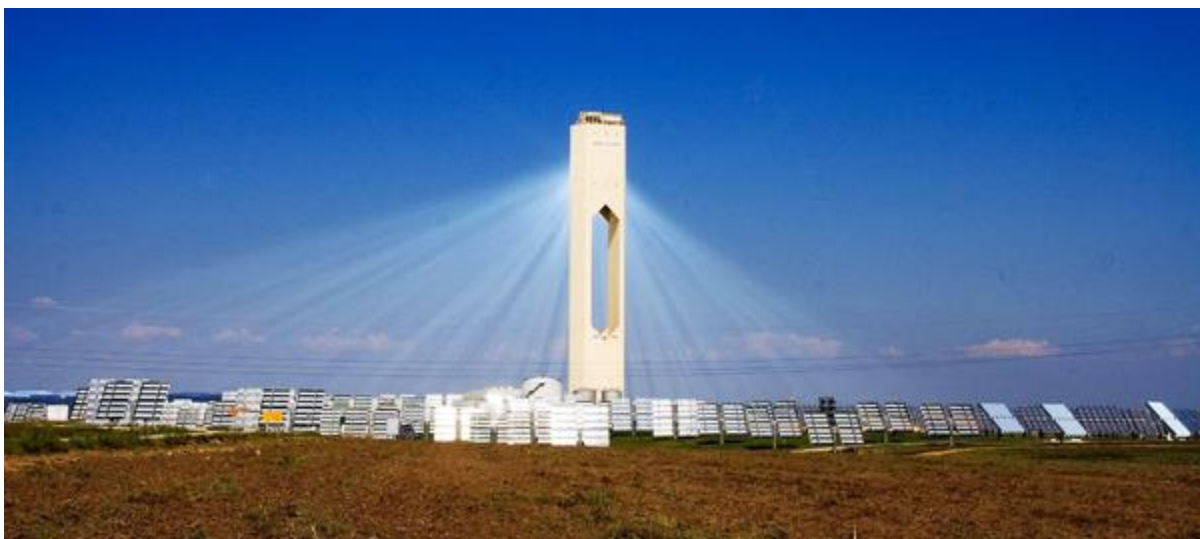
Σχήμα 2.7. Ηλιακός πύργος ισχύος.[8]
