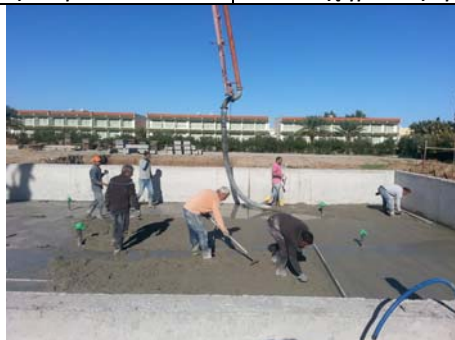
γ. Άποψη σκυροδέτησης σε πραγματικό χρόνο
