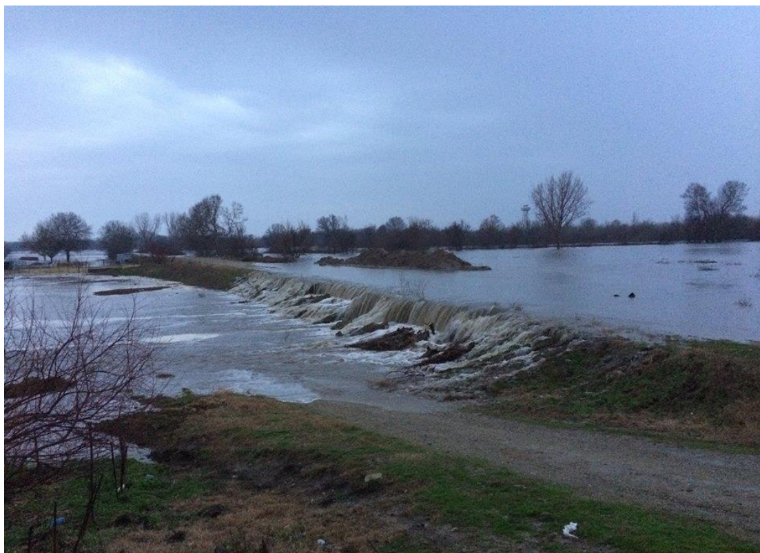
Σχήμα 5.6: Υπερβλητό ανάχωμα Πόρου κατά τις πλημμύρες του 2014
