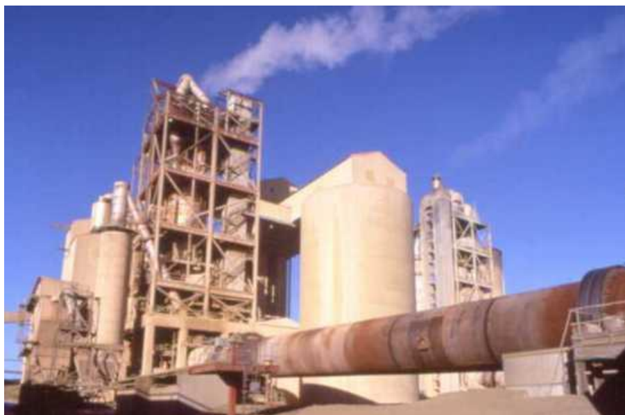
Εικόνα 2. Περιστροφικός κλιβανός τσιμεντοβιομηχανίας [10]
