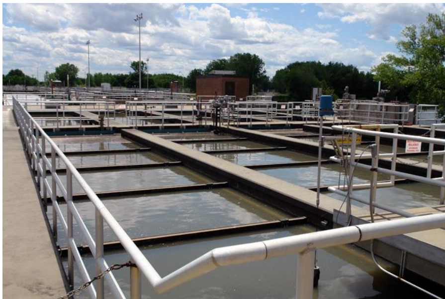
Εικόνα 1.6: Δεξαμενές καθίζησης [ http://www.bcua.org/WPC_VT ]
