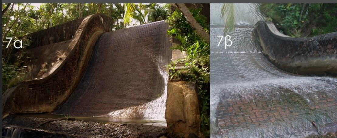
Όνομα: Fonte River Dam, Χώρα: Γκουάμ Τύπος: Φράγμα βαρύτητας σκυροδέματος Υψος: 7,3m Έτος ολοκλήρωσης: 1910
