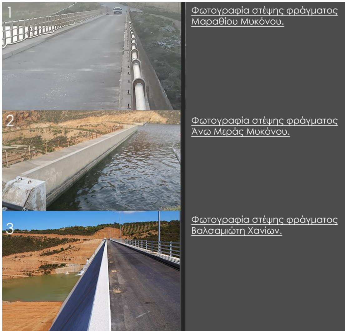
Εικόνα 10.15 Φωτογραφίες από τις στέψεις ελληνικών φραγμάτων ΑΚΣΕ (πηγές φωτογραφιών: 1,2: φωτογραφίες του συντάκτη της εργασίας, 3: www.blackathania.blogspot.com ).
