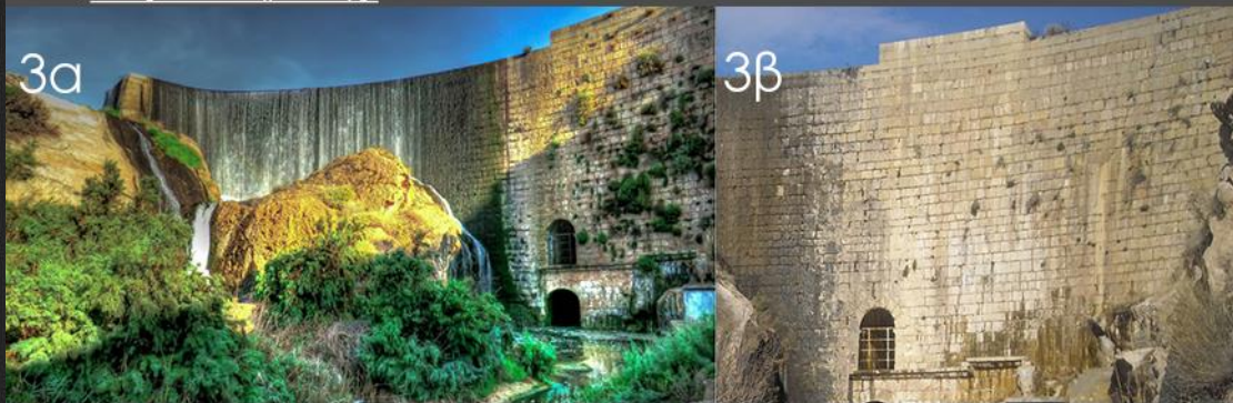
3α Όνομα: Elche, Χώρα: Ισπανία, Τύπος: Φράγμα βαρύτητας σκυροδέματος με τοξωτή κατοπή, Ύψος: 23m, Έτος ολοκλήρωσης: 1632
