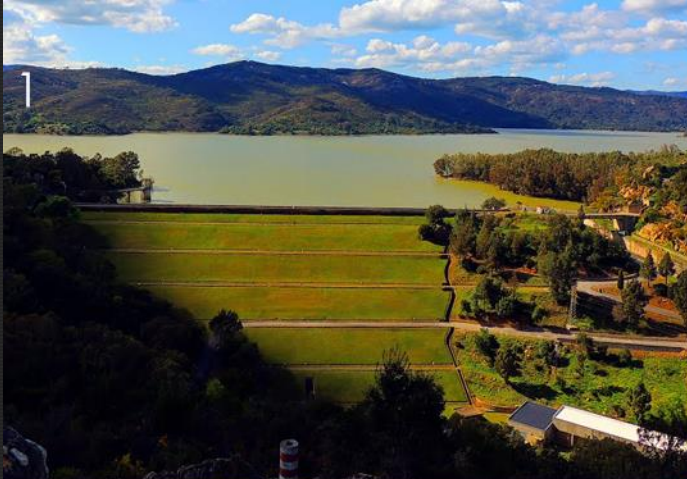
Όνομα: Guadarranque Χώρα: Ισπανία Τύπος: Χωμάτινο φράγμα με αργιλικό πυρήνα Ύψος: 67m Έτος ολοκλήρωσης: 1965
