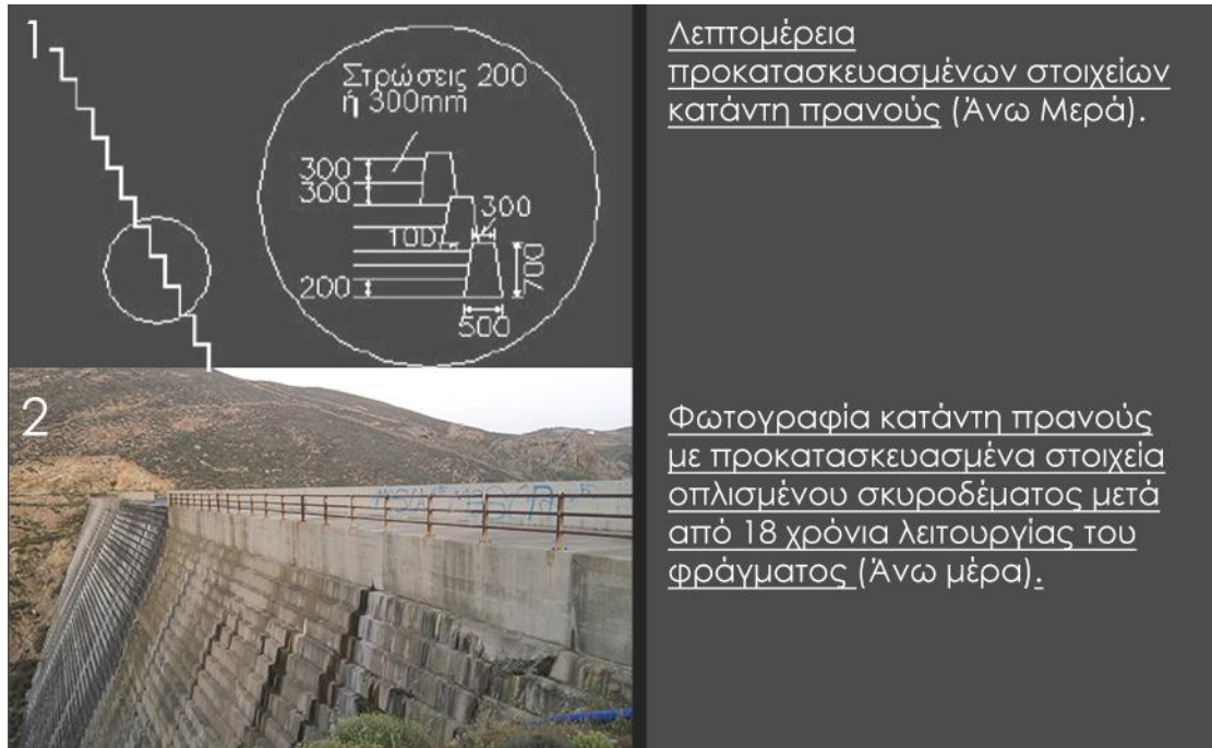
Εικόνα 10.11 Λεπτομέρεια και φωτογραφία προκατασκευασμένων στοιχείων σκυροδέματος φράγματος Άνω Μεράς (Κούμouλος, 2012 σ. 22 και 47), πηγή φωτογραφίας: φωτογραφία του συντάκτη της εργασίας).
