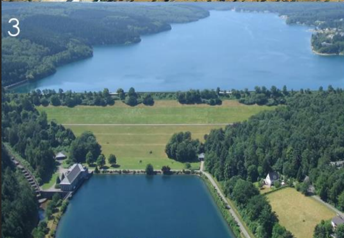
Όνομα: Sorpe Χώρα: Γερμανία Τύπος: Χωμάτινο φράγμα με πυρήνα από σκυρόδεμα Ύψος: 69m Έτος ολοκλήρωσης: 1935
