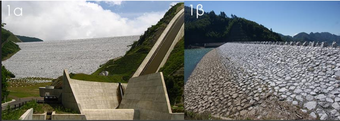
Όνομα: Μιναμιαίκι, Χώρα: Ιαπωνία, Τύπος: Λιθόρριπτο φράγμα, Ύψος: 136m, Έτος ολοκλήρωσης: 2005
