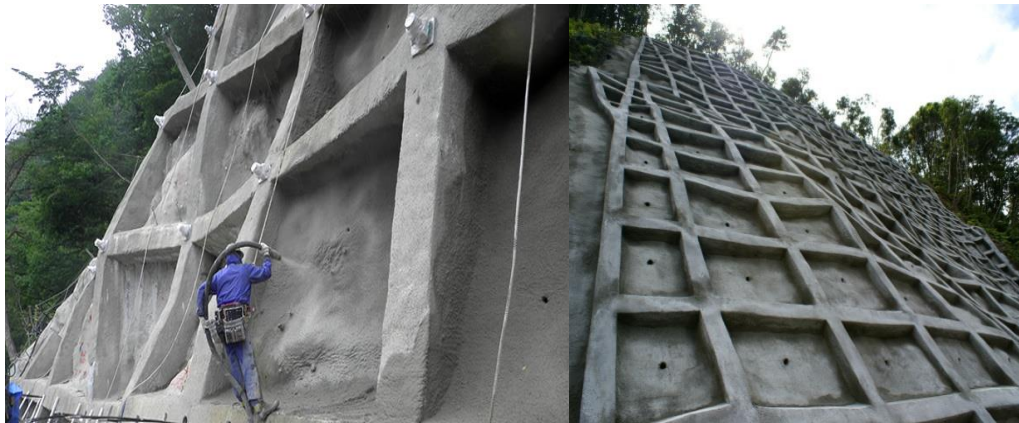
Εικόνα 4.19 Φωτογραφίες από τη διαδικασία κατασκευής και το τελικό αποτέλεσμα.
