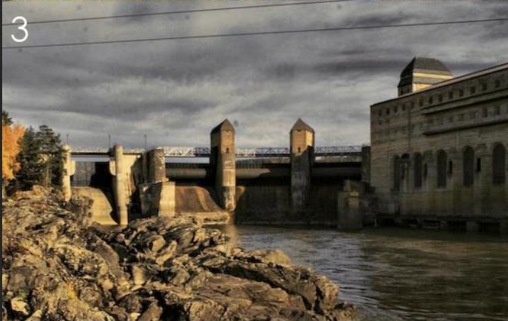
Όνομα: Solbergfoss Χώρα: Νορβηγία Τύπος: Φράγμα βαρύτητας σκυροδέματος Ύψος: 45m Έτος ολοκλήρωσης: 1924
