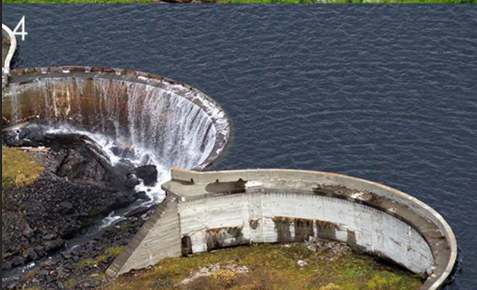
4 Όνομα: Øvre Eggevatn Χώρα: Νορβηγία Τύπος: Τοξωτό φράγμα Ύψος: 10m Έτος ολοκλήρωσης: 1950
