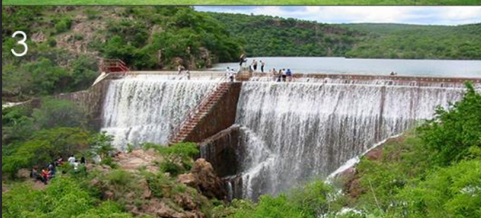
3 Όνομα: Malraso del Calvillo Χώρα: Μεξικό Τύπος: Λιθόχτιστο Φράγμα Ύψος: 32m Έτος ολοκλήρωσης: 1934
