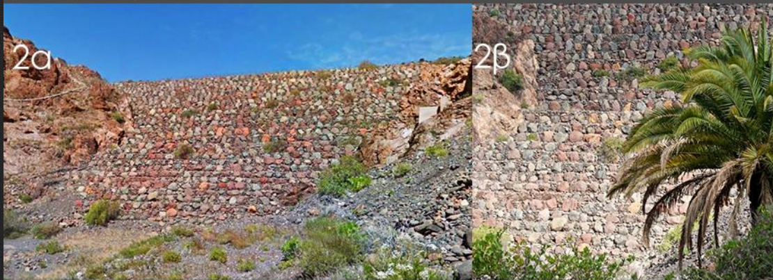
Όνομα: Τίρατζανα, Χώρα: Ισπανία, Τύπος: Χωμάτινο με αργιλικό πυρήνα, Ύψος: 44m, Έτος ολοκλήρωσης: 1974
