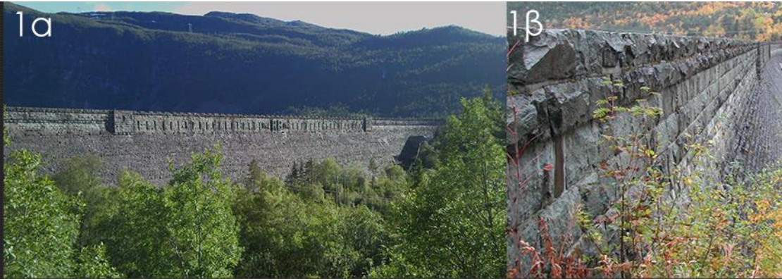
1α Όνομα: Ringedalssvatn, Χώρα: Νορβηγία, Τύπος: Φράγμα βαρύτητας σκυροδέματος, Ύψος: 33m, Έτος ολοκλήρωσης: 1918
