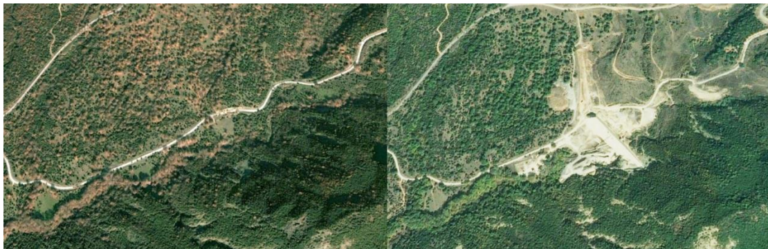
Εικόνα 2.1 Τοποθεσία φράγματος Ληθαίου Τρικάλων: Κάτοψη της περιοχής πριν και μετά την κατασκευή του φράγματος.
