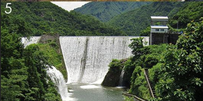
5 Όνομα: Kuromata Χώρα: Ιαπωνία Τύπος: Φράγμα βαρύτητας σκυροδέματος Ύψος: 24,5 Έτος ολοκλήρωσης: 1926
