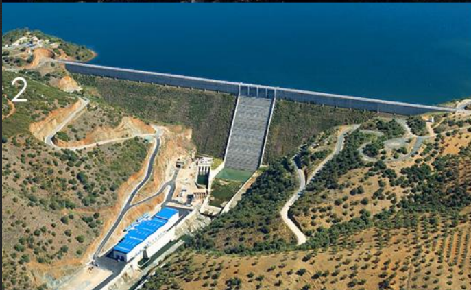
Όνομα: La Breña II Χώρα: Ισπανία Τύπος: Φράγμα βαρύτητας RCC Ύψος: 119m Έτος ολοκλήρωσης: 2007
