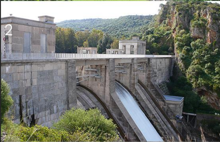
Όνομα: Bornos Χώρα: Ισπανία Τύπος: Φράγμα βαρύτητας σκυροδέματος Ύψος: 45m Έτος ολοκλήρωσης: 1961
