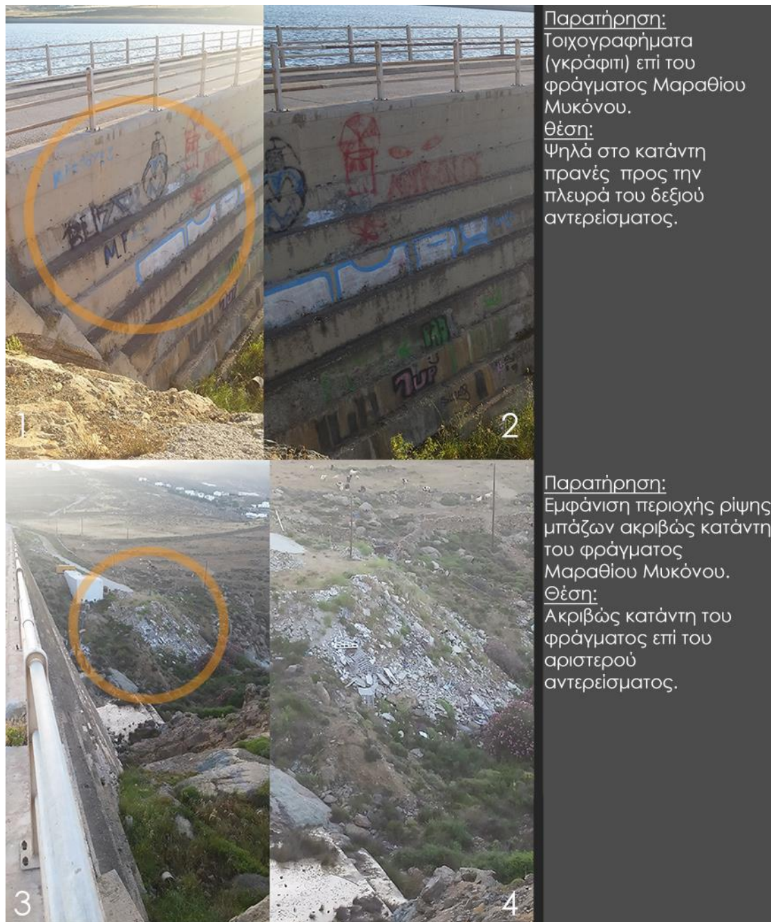
Εικόνα 6.3 Φωτογραφίες σχετικές με τις παρατηρήσεις για την αισθητική εικόνα του φράγματος Μαραθίου Μυκόνου (πηγές φωτογραφιών: φωτογραφίες του συντάκτη της εργασίας).
