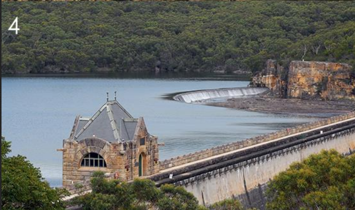
Όνομα: Cataract Χώρα: Αυστραλία Τύπος: Φράγμα βαρύτητας σκυροδέματος Ύψος: 56m Έτος ολοκλήρωσης: 1907
