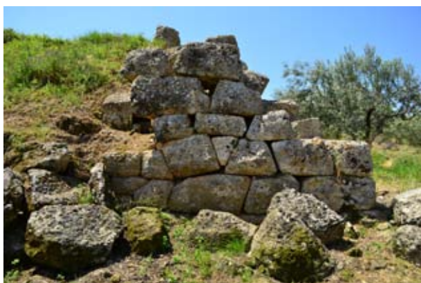
Η βόρεια παρειά της γωνίας σε πλήρη αποδιοργάνωση, αλλά σε νέα ισορροπία. Όπως και στη ΒΑ γωνία, οι (φαινόμενες ως πρώτες) τρεις στρώσεις σώζονται σχετικά καλά.
