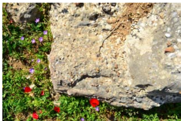
Κάτω αριστερά: Ίχνος από φωλεά σφήνας λατόμησης στην πίσω όψη λίθου επί της ΒΔ γωνίας αναλήμματος. Κάτω δεξιά: Το ίδιο ίχνος σε λίθο του τοίχου αντιστήριξης στο νοτιοανατολικό πρανές.
