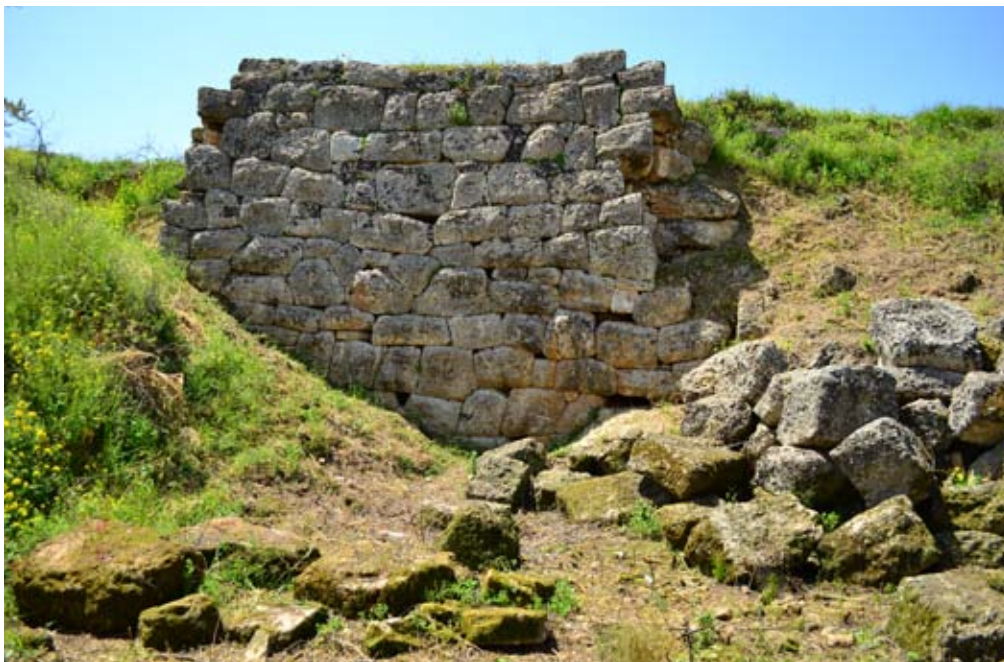
Όψη του εναπομείναντος μέρους τοίχου στο μέσον του αναλήμματος. Δεξιά ο λιθοσφωρός από την κατάρρευση του τοίχου προς τα δυτικά και αριστερά ομάδα αρχιτεκτονικών μελών από λευκό πορόλιθο και καστανόκόκκινο ασβεστιτικό ψαμμίτη.
