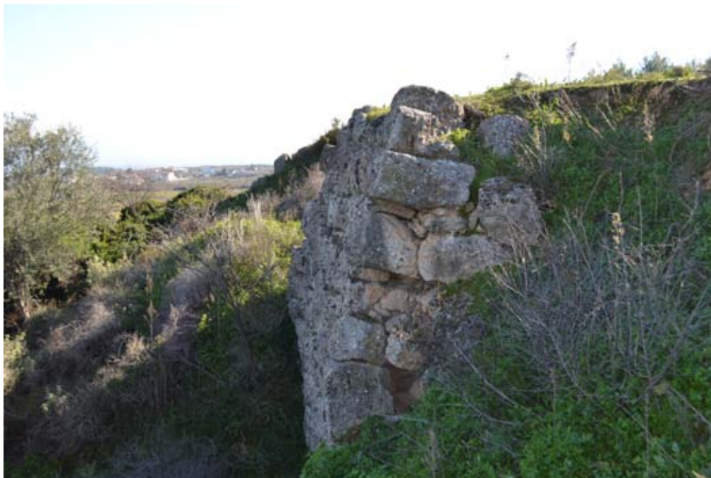
Το σωζόμενο μέρος του τοίχου αντιστήριξης στο μέσον της μακράς πλευράς. Πίσω διακρίνεται η επίχωση του τμήματος που έχει καταρρεύσει. Άποψη από τα δυτικά.
