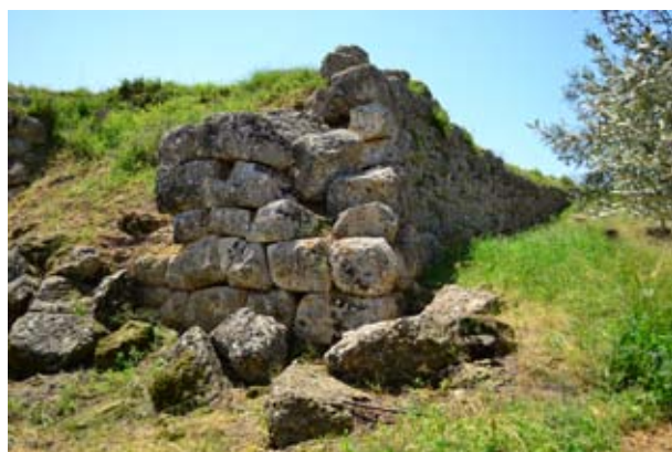
Η πλειονότητα των γκερμισμενων λίθων της γωνίας βρίσκεται πιθανόν θαμμένη εκεί όπου κατέπεσε.
