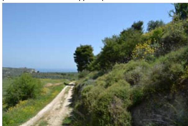
Το νοτιοανατολικό πρανές από τα νότια. Ο δρόμος σκάφτηκε εις βάρος της κλίσης που γίνεται απότομη προς τη σφενδόνη.
