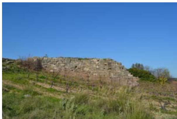
Άποψη αναλήμματος από τα ανατολικά.
