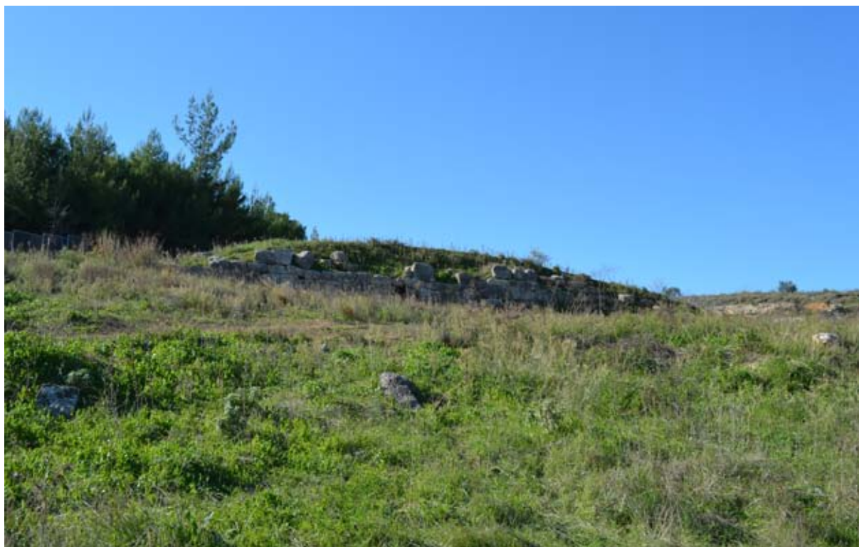
Άποψη του νοτιοανατολικού πρανού και του τοίχου αντιστήριξης από τα ανατολικά. Διακρίνεται η ήπια κλίση του εδάφους προς τα δυτικά.
