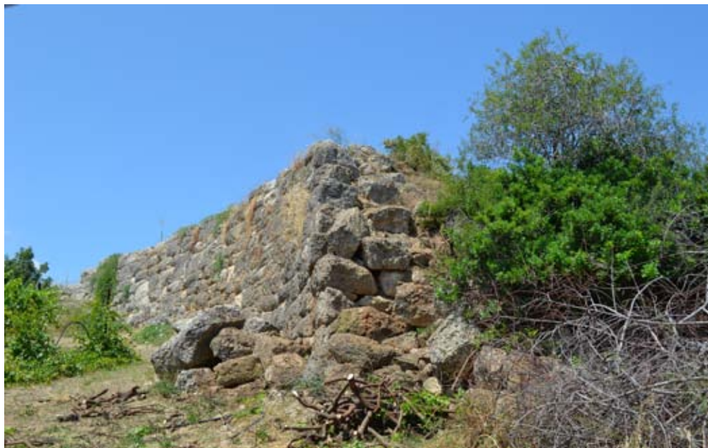
Η ΒΑ γωνία του αναλήμματος μετά την τμηματική αποψίλωση.
