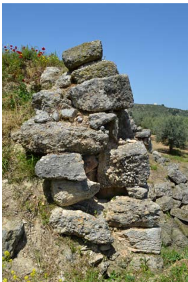
Τρόπος λιθοσυμπλοκής τοίχου αντιστήριξης. Οι έδρες των λίθων έντονα διαβρωμένες, φανερώνουν ότι το τμήμα τοίχου προς τα ανατολικά έχει καταρρεύσει αιώνες πριν. Άποψη από τα ανατολικά.
