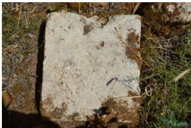
Βαθμίδα από λευκό πωρόλιθο, άνω έδρα. Πάνω πιθανά σημάδια απολάξευσης υποδοχής για μεταλλικό σύνδεσμο.
