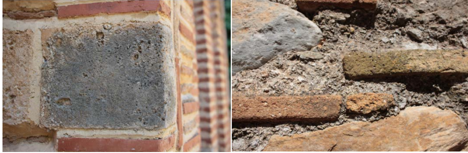
εικ.: (αριστερά)κόκκινοι οπτόπλινθοι αποκατάστασης , (δεξιά) κόκκινοι και κίτρινοι οπτόπλινθοι
