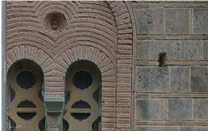
εικ.: δίλοβο παράθυρο κόχης ιερού, αντικατάσταση επιθήματος κιονίσκου
