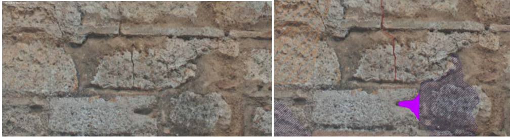
εικ.: κατακόρυφη ρηγμάτωση λίθου και οπτοπλίνθου στην περιοχή αριστερά της βόρειας κεραίας (επάνω μέρος)
