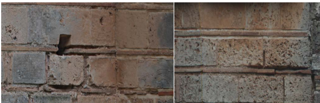
εικ.: χρωματικές αλλοιώσεις σε προστατευόμενες ζώνες λόγω επικαθήσεων: εσωτερική γωνία κογχών/ κάτω απ' τη στέγη
