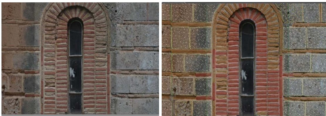
εικ.: επέμβαση στην κόγχη της πρόθεσης με κόκκινες πλίνθους αποκατάστασης, ορθοφωτογραφία και χαρτογράφηση
