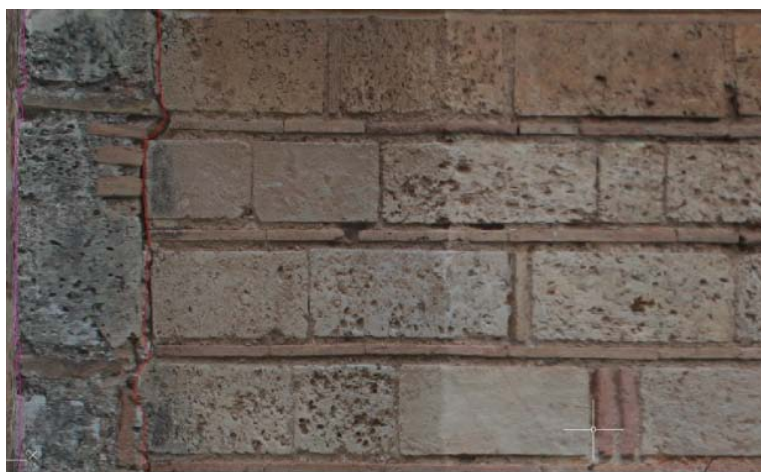
εικ.: ρηγμάτωση αποκόλλησης κόγχης διακονικού από νοτιοανατολική γωνία
