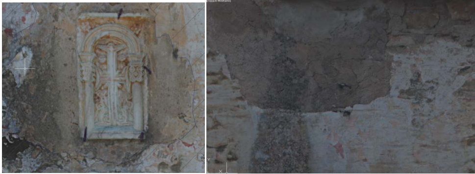
εικ.: δυτική όψη : επεμβάσεις συμπλήρωσης με τσιμεντιτικά κονιάματα
