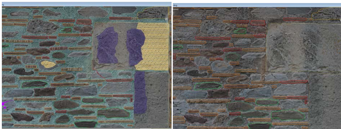
εικ. : νοτιοανατολική γωνία, γωνιακοί πωρόλιθοι
