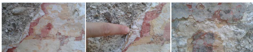
εικ.: δυτική όψη : στρώματα χρωματικών επιστρώσεων
