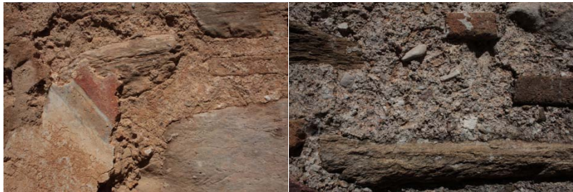
εικ.: (αριστερά) ίχνη τοιχογράφησης , (δεξιά) αυθεντικό κονίαμα
