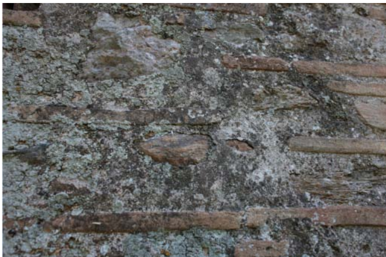
εικ.: μαύρη, λευκή βιοδιάβρωση και πράσινοι φυλλώδεις επιλιθικοί λειχήνες, βόρεια όψη
