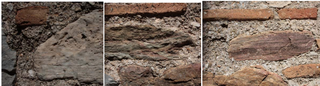
εικ.: (αριστερά)συμπαγής ασβεστόλιθος, (μέσο) σχιστόλιθος, (δεξιά) ερυθρός συμπαγής λίθος
