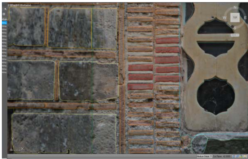
εικ.: δίλοβο παράθυρο κόχης ιερού, αντικατάσταση οπτοπλίνθων
