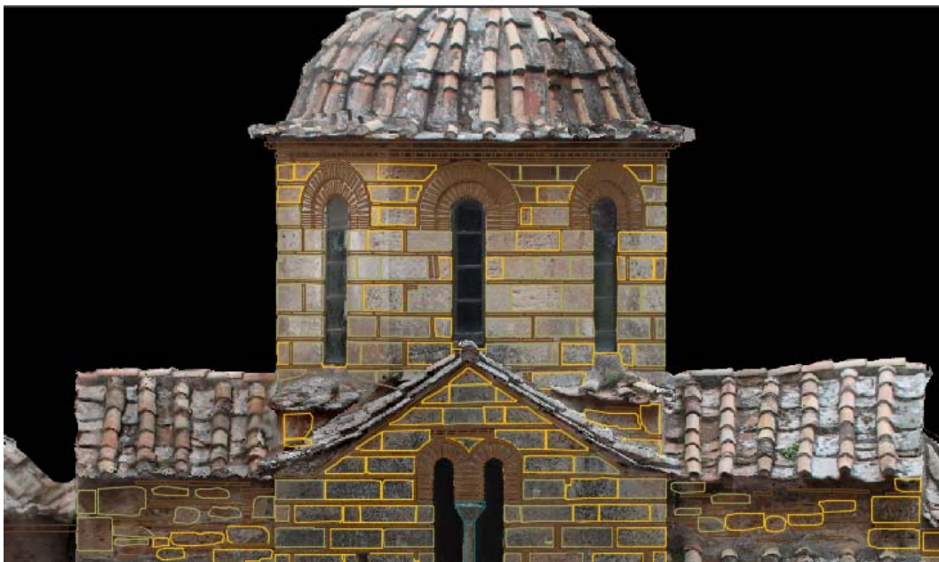
εικ.: νότια όψη κογχυλιάτες λίθοι και πλίνθοι (κατά τη διαδικασία χαρτογράφησης)
