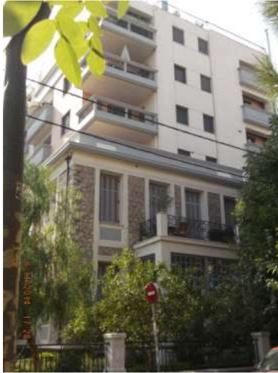
Εικόνα 7: Προσθήκη Ορόφων σε Υπάρχον Διατηρητέο Κτίριο
