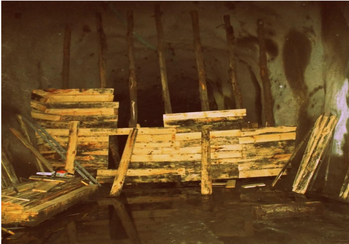
Εικόνα 32. Κατασκευή του φράγματος όπου θα μεταφερθεί το υλικό πλήρωσης.
