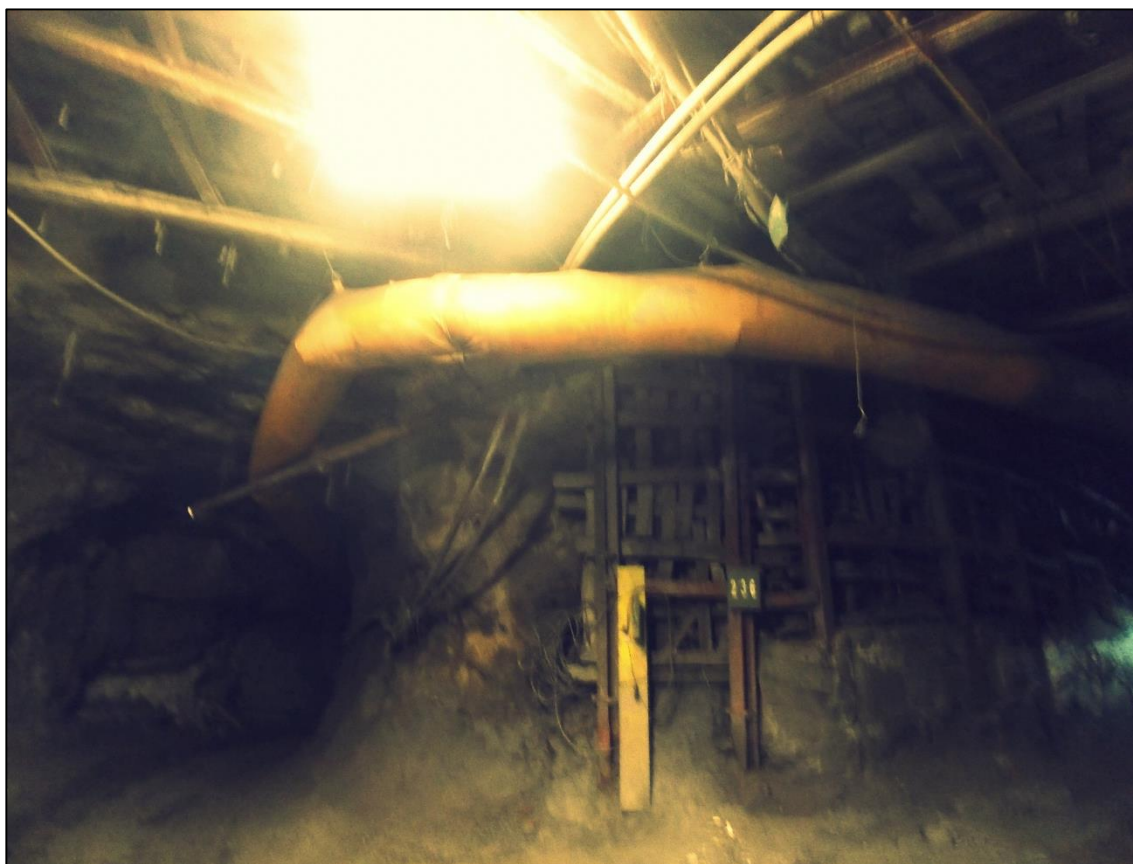
Εικόνα 7. Μεταλλείο Μαύρων Πετρών, προσπελαστική στοά, κύκλωμα αερισμού.
