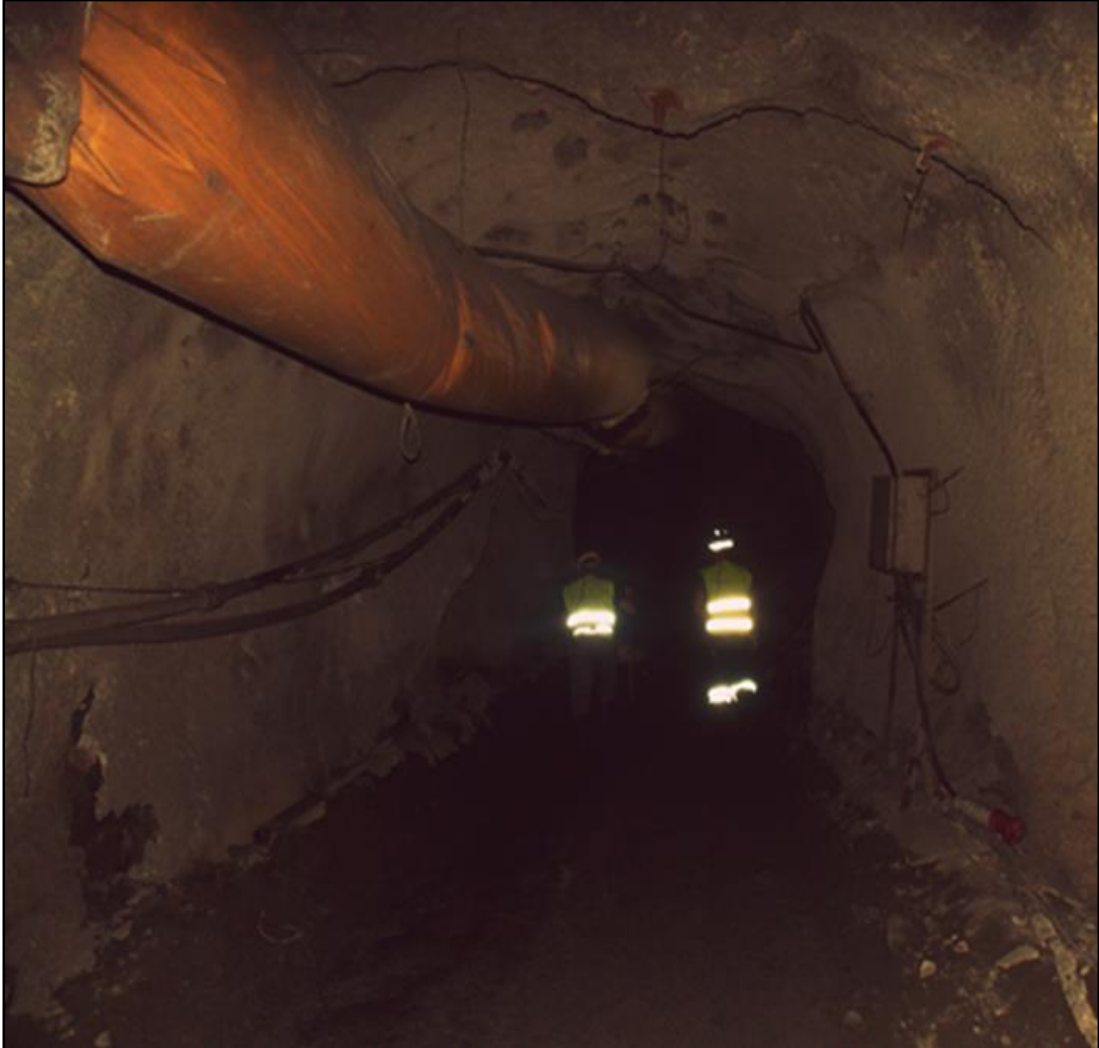
Εικόνα 4. Στοά υποστηριζόμενη από εκτοξευόμενο σκυρόδεμα (shotcrete).
