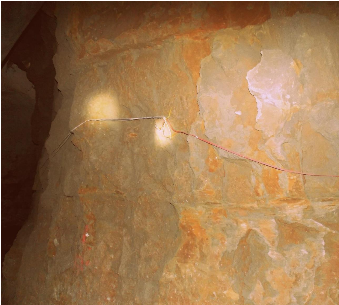
Εικόνα 2. Λιθογομωμένη στοιά με χαρακτηριστικό χρώμα του υλικού λιθογόμωσης στο μεταλλείο Μαύρων Πετρών.
