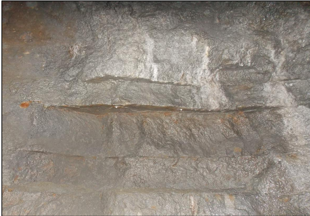
Εικόνα 9. Υλικό λιθογόμεωσης σε πληρωμένη στοά. Χαρακτηριστικό χρώμα και μορφή του σώματος της λιθογόμεωσης.
