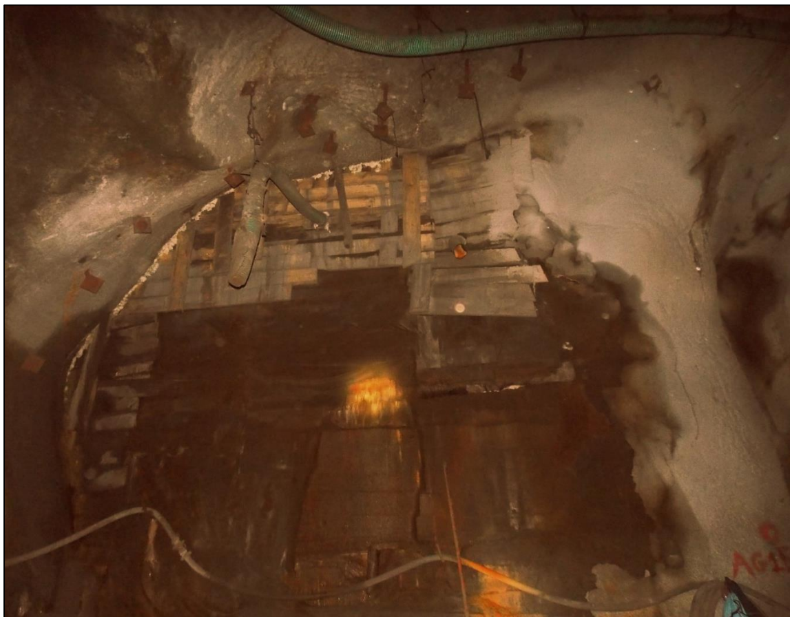
Εικόνα 33. Ξύλινο φράγμα όπου μεταφέρεται υδραυλικά το υλικό λιθογόμωσης και συγκρατείται προσωρινά.
