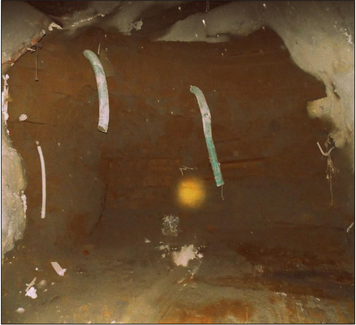
Εικόνα 3. Στοά πληρωμένη υδραυλικά, με το υλικό λιθογόμωσης όπου φαίνονται δύο αντλίες μεταφοράς του υλικού.
