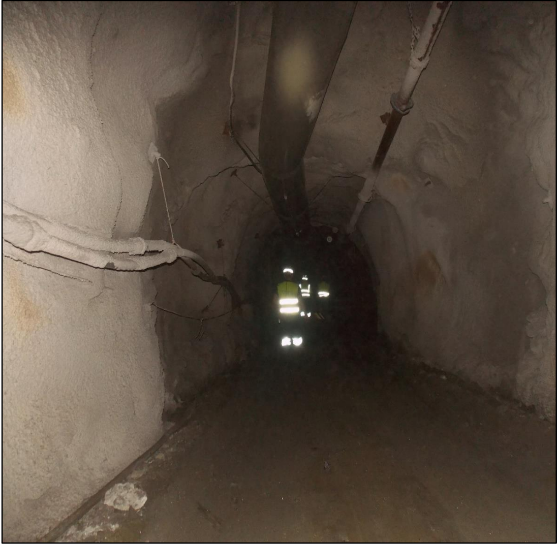
Εικόνα 5. Στοά υποστηριζόμενη από εκτοξευόμενο σκυρόδεμα στο μεταλλείο των Μαύρων Πετρών.
