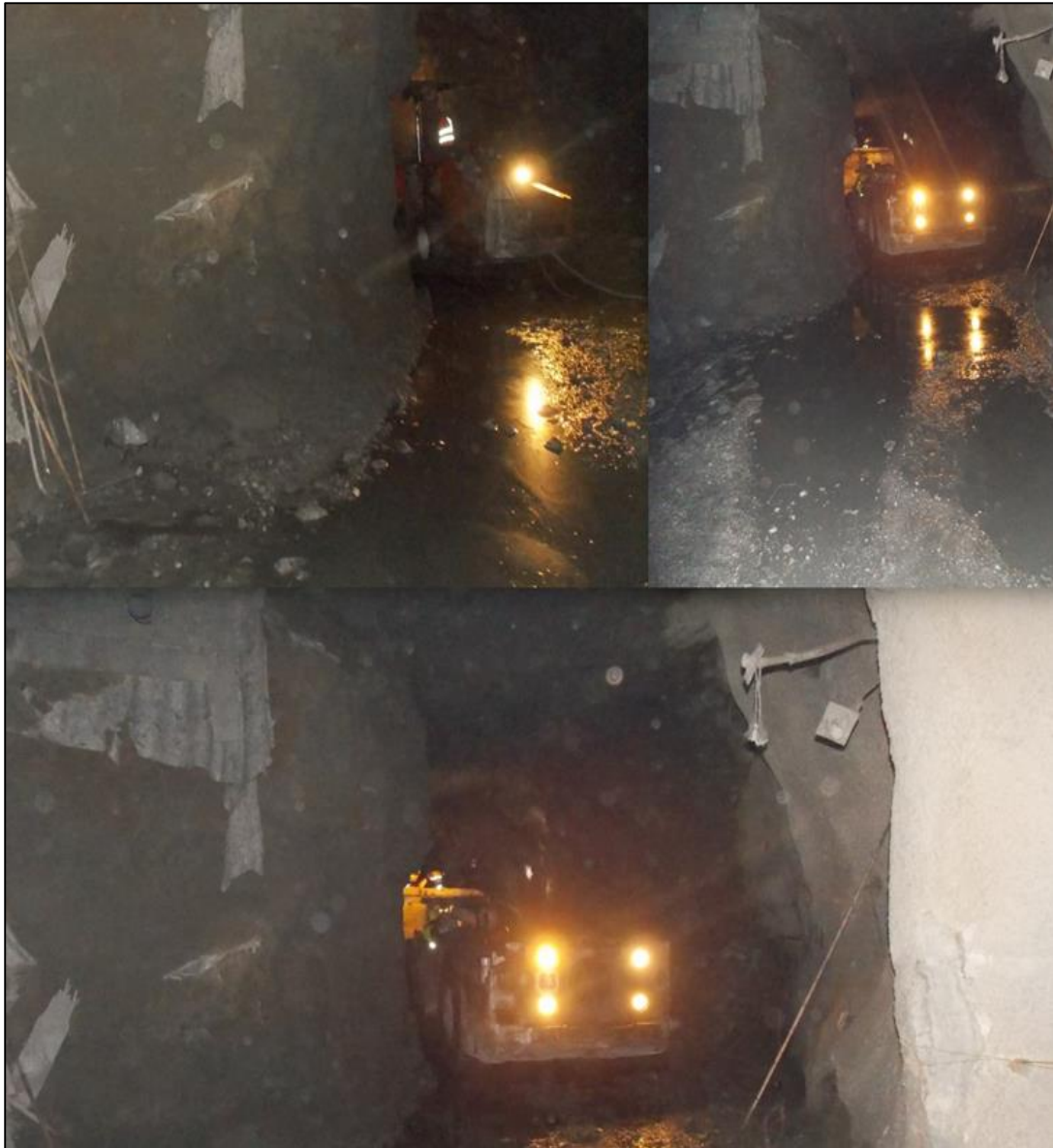
Εικόνα 8. Διατηρητικό μηχάνημα και φορτωτής κινούνται στο μέτωπο για εργασίες δίπλα σε λιθογομωμένη στοά στο μαγαλείο Μαύρων Πετρών.
