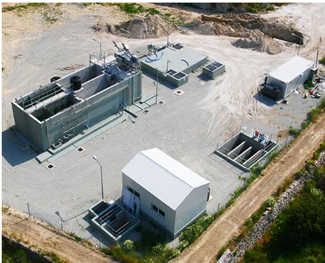
Εικόνα 4.3 : Εγκατάσταση MBR στη νήσο Μήλο
