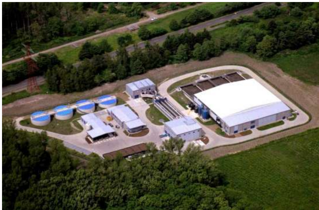
Εικόνα 4.5 : Μονάδα βιοαντιδραστήρα MBR του Nordkanal στο κρατίδιο North Rhine Westphalia της Γερμανίας
