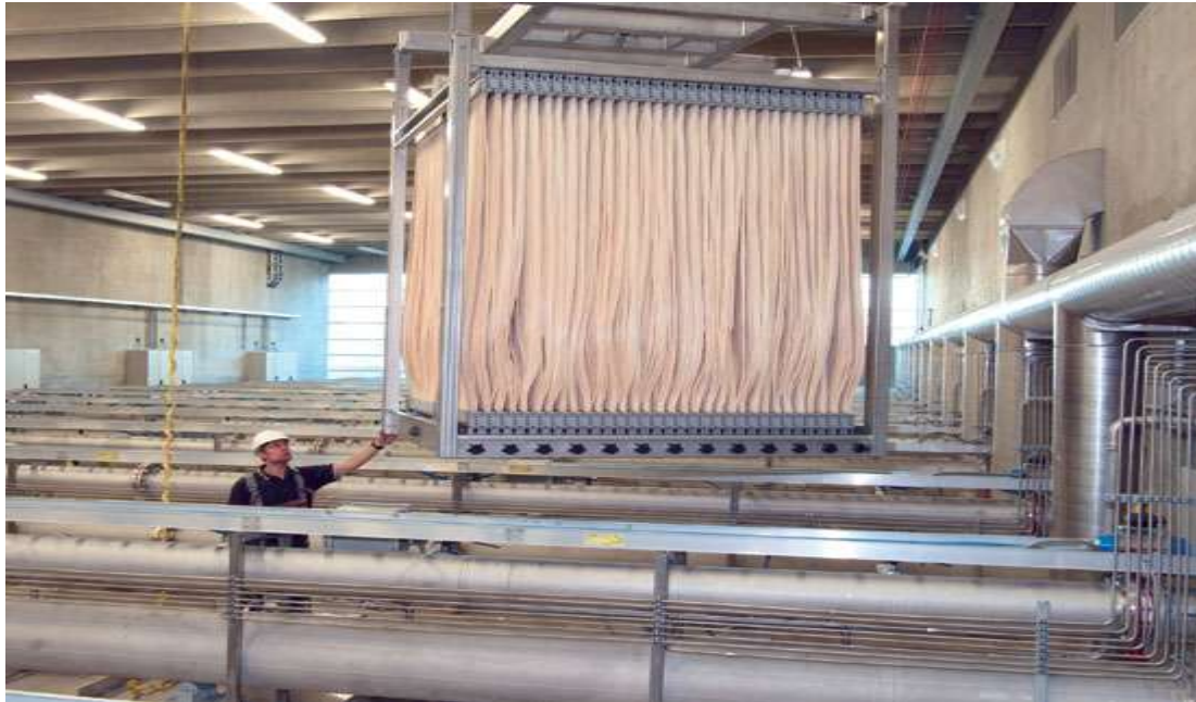
Εικόνα 4.7 : Μεμβράνη με τριχοειδείς κοίλες ίνες (hollow-fibre membrane)
