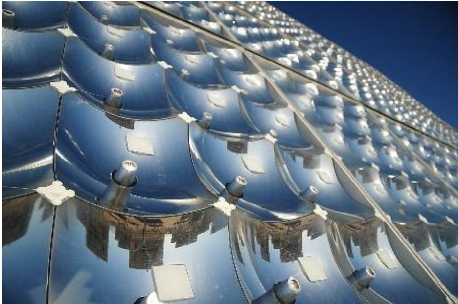
Εικόνα 1.2: Συστοιχία συγκεντρωτικών φωτοβολταϊκών στοιχείων ( www.renewableenergyworld.com )
