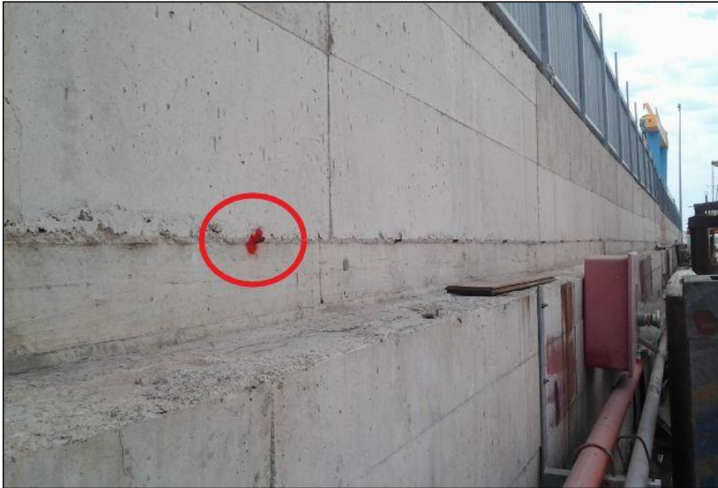
Εικόνα 3.5. Σημάδι από το οποίο γίνεται εξασφάλιση στάσης
