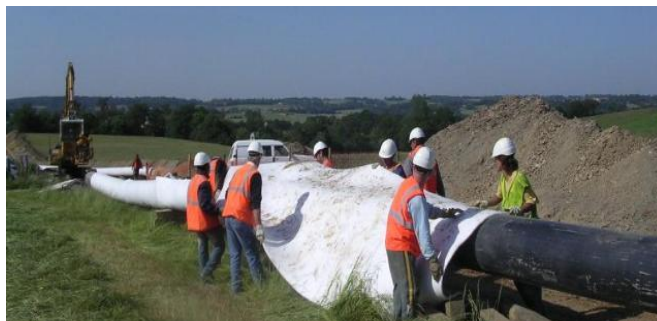
Σχήμα 1-5: Περιέλιξη αγωγού με γεωύφασμα (De Saedeleir)
