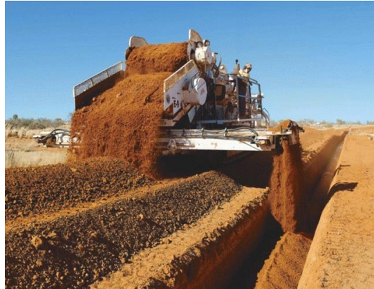
Σχήμα 1-3: Διάστρωση κοκκώδους επιχώσης (Pipelines International)
