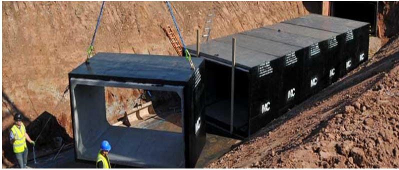
Σχήμα 1-7: Προκατασκευασμένα ορθογωνικά στοιχεία από οπλισμένο σκυρόδεμα (FP McCann)
