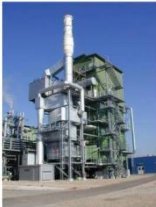
Εικόνα 10.10: Linde-υγραέριο-αναμορφωτής ατμού με CO μετατροπέα (Λάμπρου Ε.)
