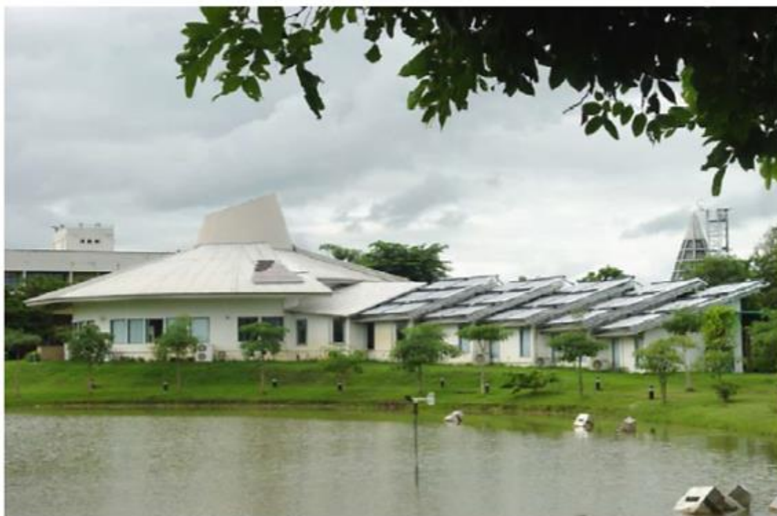
Εικόνα 9.11: Το κτίριο SERT στο οποίο έγινε η εγκατάσταση συστήματος ηλιακής ψύξης (Pongtornkulpanich et al. 2008)
